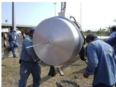
En la cabeza armada se encontrará la varilla de pararrayos la cual estará sujeta sólidamente al poste por medio de un conector mecánico, la varilla puede ser tipo Faraday o Dipolo (toroidal).
