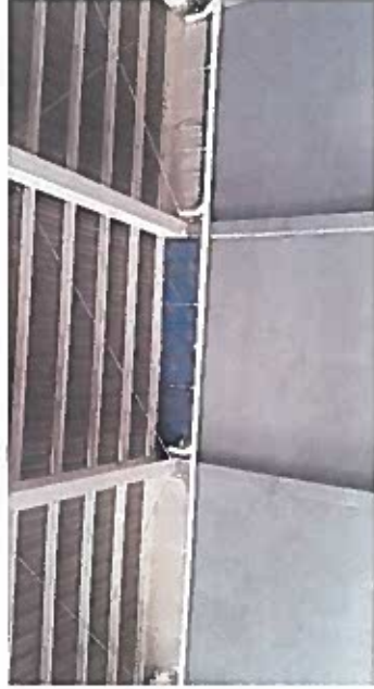
suministro y colocacion de bajante pluvial
