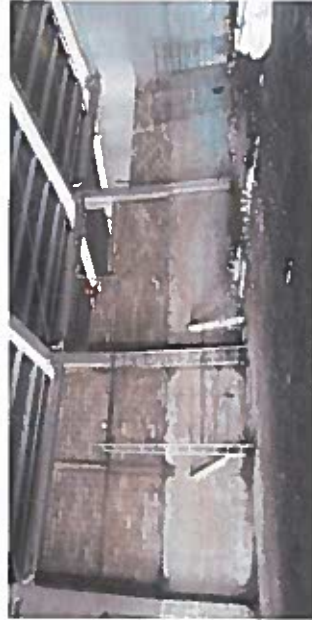
cimbrado de castillos y cadena
