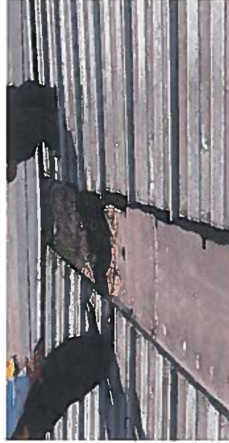
revision de bajantes agua pluvial
