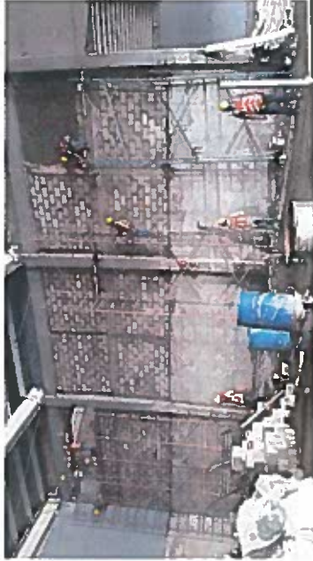
construccion de muro de block de 12x20x40 cm
