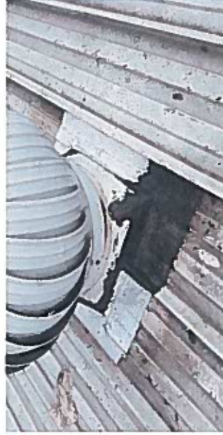
sellado con tpo band y plastic cement en extractores
