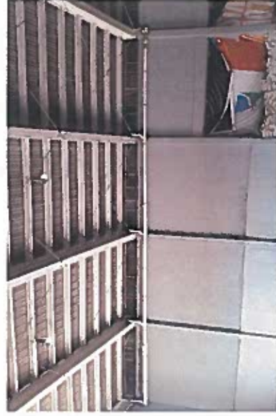
suministro y colocacion de bajante pluvial
