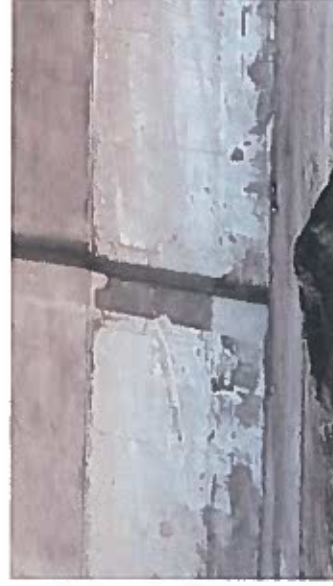
terminacion de Resana en desconchamiento de concreto
