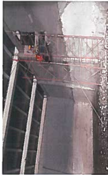
demolicion de muro en eje G
