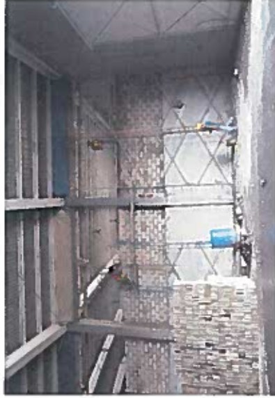
construccion de muro de block de 12x20x40 cm
