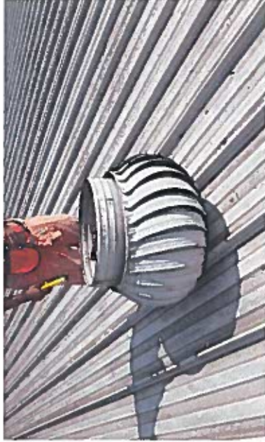
retiro de extractores para su limpieza
