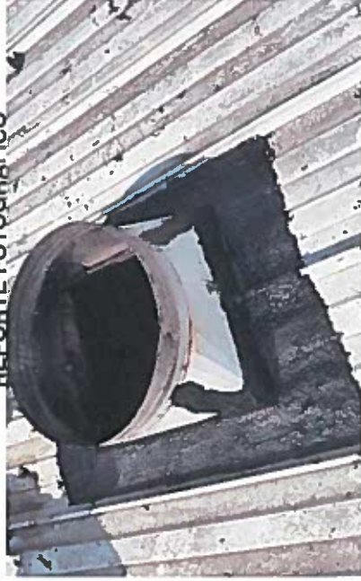
retiro de extractores para su limpieza
