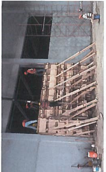
COLADO DE MURO DE CONCRETO G-5-G6
