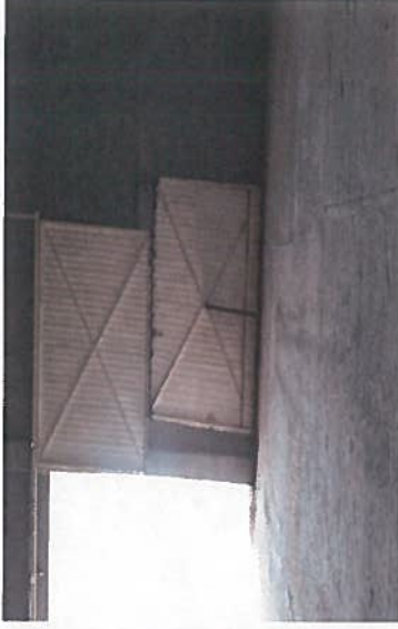
Corte de hoja de porton de bodega 1
