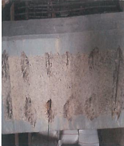
RANURADO DE COLUMNA PARA AMARRE DE ACERO
