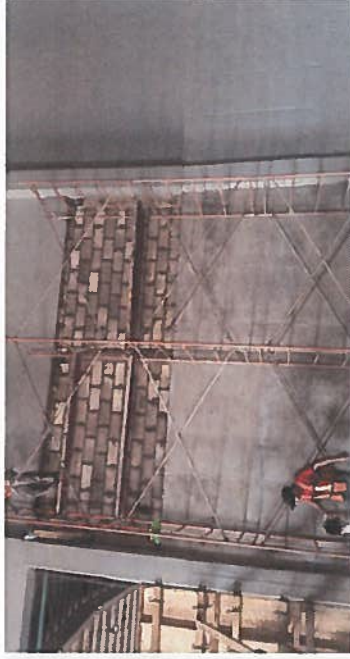
Colado de concreto para castillos
