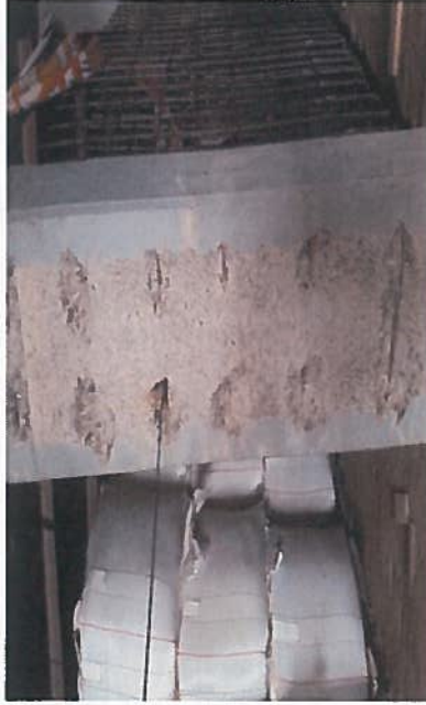
Demolición de columna para anclar estribos
