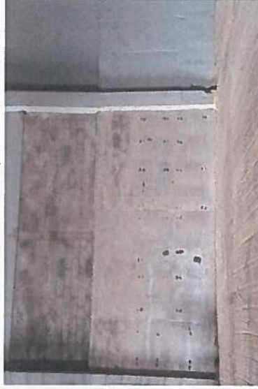
Aplanado en muro de block
