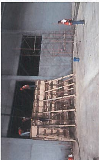
CIMBRADO DE MURO DE CONCRETO G5-G6
