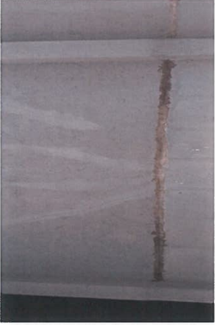
SELLADO DE JUNTA DE MURO
