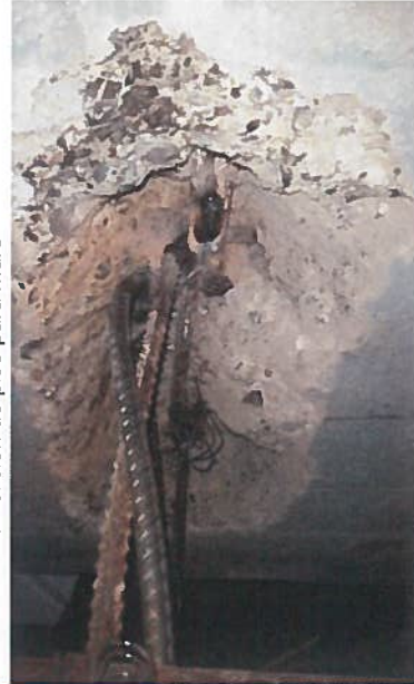
Soldadura para estribos.
