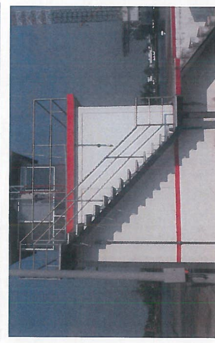
Instalacion de barandales en planta de azotea de cuarto de bombas y en area de atracadero de muelle tramo I.
