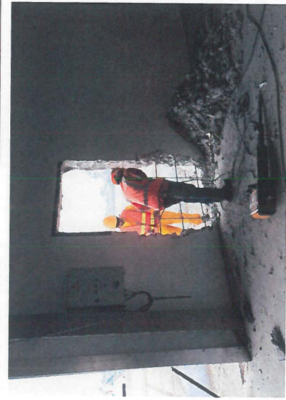
DEMOLICION DE MURO ARMADO DE 20 CM. DE ESPESOR
