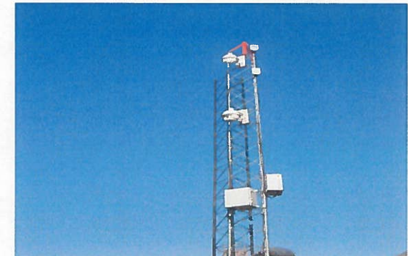
SE CONCLUYO CON LA COLOCACION DE GABINETES NEMA
