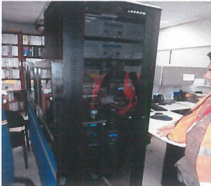
SE CONCLUYO CON LA INSTALACION DE GABINETE
