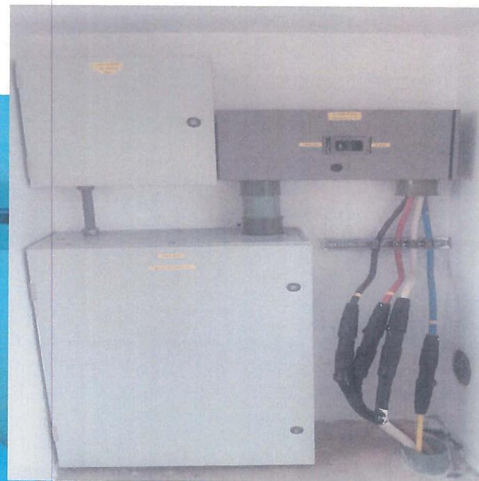
Suministro e instalación de Interruptor termo magnético en tableros derivados marca SIMENES Cat FXD63B250L o similar Incluye: Gabinete, Tapa y zapatas para su instalación y conectores bumdy mecánicos para conexión aplicación de cinta Scotch 23 y 33 consumibles, materiales, mano de obra, equipo, herramienta y todo lo necesario para la correcta ejecución del concepto, P.U.O.T.
