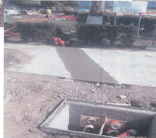
Demolición y reposición de concreto hidráulico  $f'c = 250 \text{ kg/cm}^2$  en cruce de arroyo en acceso a muelle de dragas, incluye: trazo y corte con disco de diamante para delimitar área de demolición, demolición por medios manuales o mecánicos, retiro del material producto de la demolición hasta el lugar indicado por la supervisión dentro del primer kilómetro, reposición de concreto, mano de obra, equipo, herramienta y todo lo necesario para la correcta ejecución del concepto, P.U.O.T.
