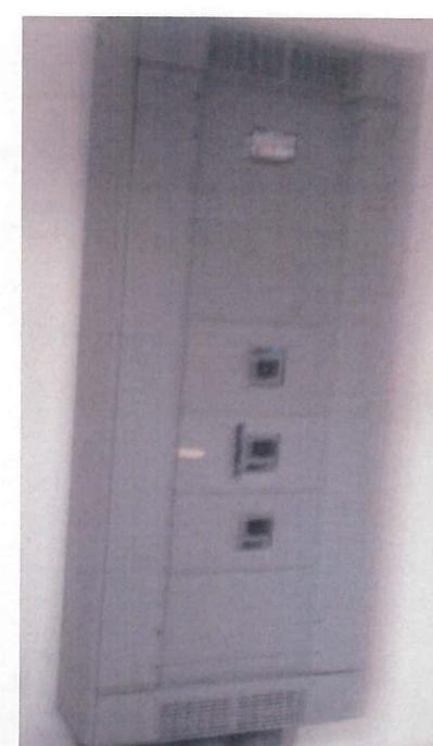
Suministro e instalación de Interruptor termo magnético en tableros derivados marca SIMENES Cat LXD63B500 o similar, Incluye: Zapatas para su instalación, consumibles, materiales, mano de obra, equipo, herramienta y todo lo necesario para la correcta ejecución del concepto, P.U.O.T.
