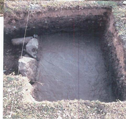
Construcción de zapata aislada con medidas de 0.80 x 0.80 x 0.60 mts. Con concreto f'c=250 kg/cm<sup>2</sup>, armada con varilla de #3 @ 20 cm en ambos sentidos en parrilla y #4 en dado de acuerdo a lo indicado en el proyecto, Incluye: habilitado y colocación de acero de refuerzo, vaciado y vibrado del concreto, consumibles, materiales, mano de obra, equipo, herramienta y todo lo necesario para la correcta ejecución del concepto, P.U.O.T.
