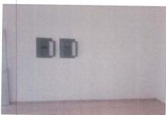
en las presentes imágenes se muestra la colocacion de salidas electricas para luminarias, la instalacion de tableros de distribucion de 3 faces de 20 circuitos con tapa tipo empotrar, la instalacion de interuptores termomagneticos de 30 amp. Y 40 amp.
