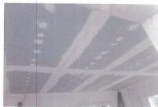
en las presentes imágenes se muestra la colocacon de muro de durock a dos caras, el emboquillado, repellado y perfilado de vano de ventanas y puertas de acceco con 15 cm de ancho en promedio. Al igual se muestra la colocación de sistema de cielo corrido a base de tabla roca
