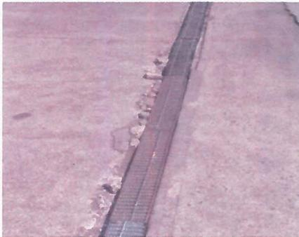
VISTA DE PARRILLAS TIPO IRVING TIPO IS-06 3/16X 1-1/4" ACABADO DENTADO GALVANIZADO H-20 CON ANGULO DE REMATE.
