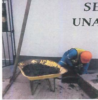
DESASOLVE DE DREN PLUVIAL RETIRANDO MATERIAL DE SU INTERIOR.
