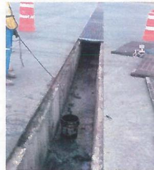
RETIRO DE LODOS DE INTERIOR DE DREN PLUVIAL EN AREA DE BODEGA MULTIPROPOSITOS.
