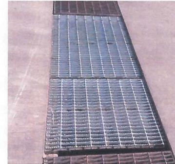
VISTA DE PARRILLA MARCA TIPO IRVING IS-06 3/16 X 1-1/4" ACABADO DENTADO GALVANIZADO H-20 DIMENSIONES DE 0.80 X 0.70 MTS.
