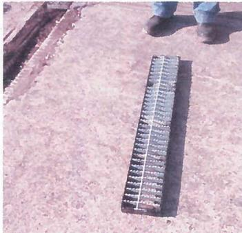
VISTA DE PARILLAS TIPO IRVING TIPO IS-06 3/16X 1-1/4" ACABADO DENTADO GALVANIZADO H-20 DIMENSIONES DE 1.00X0.16MTS.
