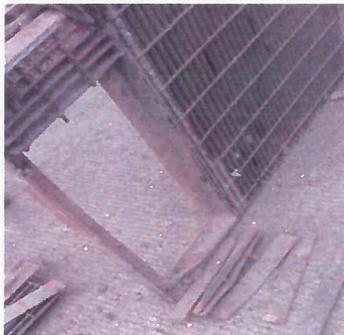
VISTA DE PARRILLAS EN MAL ESTADO QUE SERAN RETIRADAS Y SUSTITUIDAS EN MODULOS COMPLETOS.
