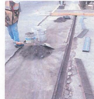
LIMPIEZA DE DREN PLUVIAL RETIRANDO MATERIAL PARA POSTERIORMENTE INSTALAR REJILLAS TIPO IRVING.
