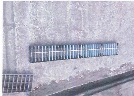
PARILLAS TIPO IRVING TIPO IS-06 3/16X 1-1/4" ACABADO DENTADO GALVANIZADO H-20 DIMENSIONES DE 1.00X0.16MTS.
