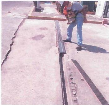
RETIRO DE PARRILLAS EN MAL ESTADO PARA TRASLADAR A TALLER Y SER REPARADAS.
