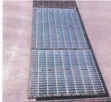
INSTALACION DE PARRILLAS MARCA IRVING TIPO IS-06 3/16X1-1/4" ACABADO DENTADO GALVANIZADO H-20 DIMENSIONES DE 1.00X.80M.
