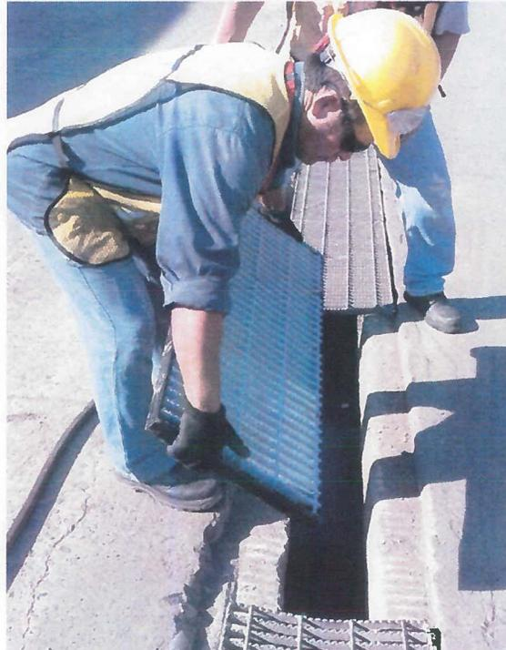
SUMINISTRO E INSTALACION DE PARRILLAS MARCA IRVING TIPO IS-06 3/16X1 1/4" ACABADO DENTADO GALVANIZADO H-20 DIMENSIONES DE 1.02X0.40M.
