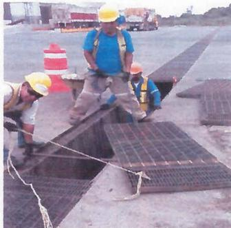
LEVANTAMIENTO DE PARRILLAS TIPO IRVING PARA CONTINUAR CON TRABAJOS DE LIMPIEZA DE DREN PLUVIAL.
