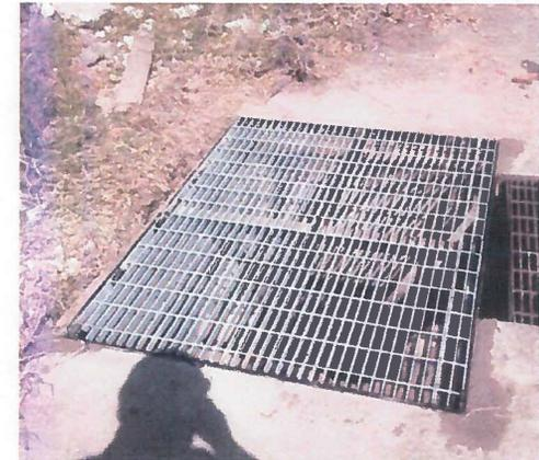
VISTA DE INSTALACION DE PARRILLA MARCA IRVING TIPO IS-06 3/16" X 1/4" ACABADO DENTADO GALVANIZADO H-20 DIMENSIONES DE 1.20 X 1.47 MTS.
