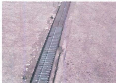
VISTA DE PARILLAS TIPO IRVING TIPO IS-06 3/16X 1-1/4" ACABADO DENTADO GALVANIZADO H-20 DIMENSIONES DE 1.00X0.16MTS. INSTALADA.
