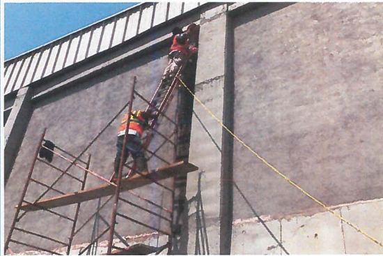
COLOCACIÓN DE DREN PLUVIAL
