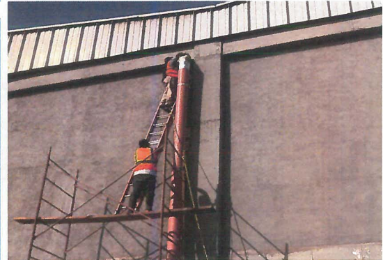
COLOCACIÓN DE DREN PLUVIAL
