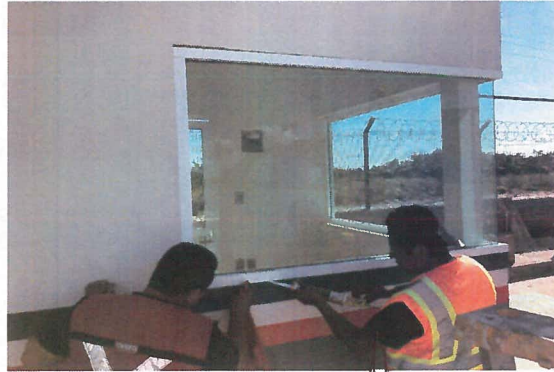
INSTALACIÓN DE VENTANAL FIJO A BASE DE ALUMINIO
