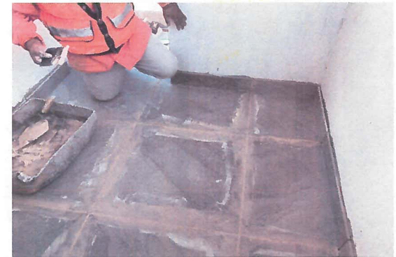
COLOCACIÓN DE PISO LOSETA EN CASETA
