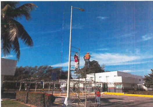
COLOCACION DE LUMINARIAATB2 60BLEDE70 MVOLT R3 NR
