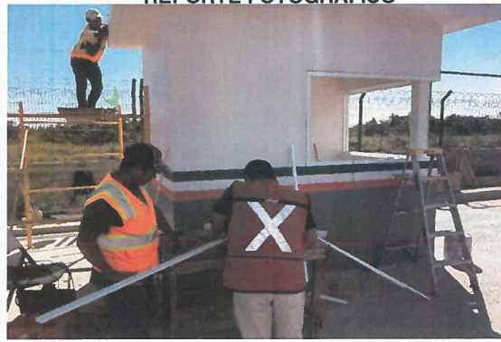
INSTALACIÓN DE VENTANAL FIJO A BASE DE ALUMINIO
