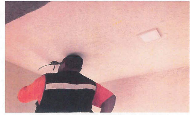
COLOCACIÓN DE LUMINARIO SOLALED 9W 6500K
