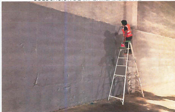
COLOCACIÓN DE IMPERMEABILIZANTE
