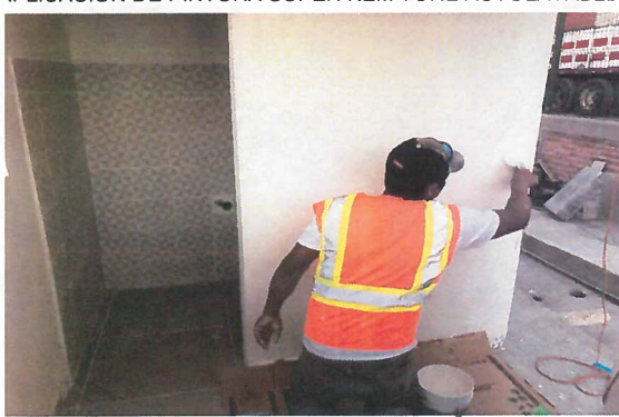
APLICACIÓN DE PINTURA SUPER KEM TONE AUTOLAVABLE
