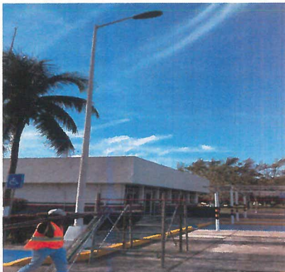
COLOCACION DE LUMINARIAATB2 60BLEDE70 MVOLT R3 NR
