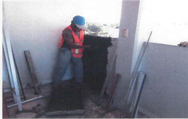
Muro de tabique rojo recocido de 7x14x28
