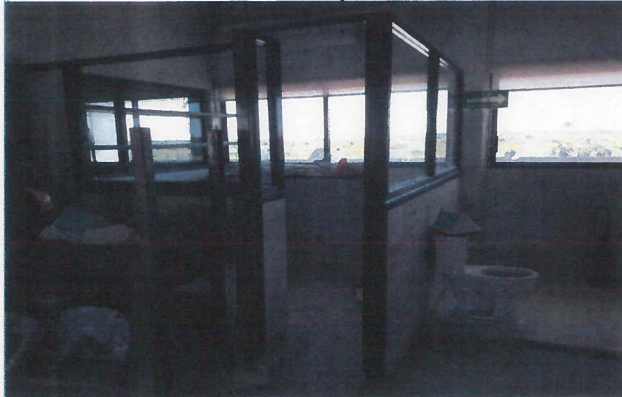
Retiro de cancelería y muro de durock
