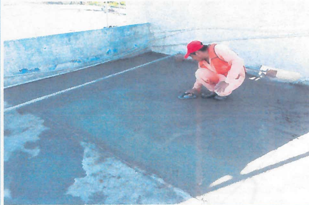
Entortado en asote para dar pendientes del 1%
