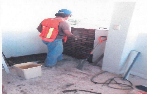
Muro de tabique rojo recocido de 7x14x28
