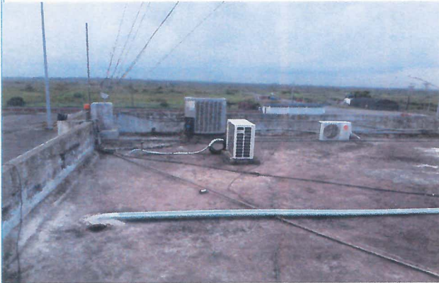
Entortado en asote para dar pendientes del 1%
