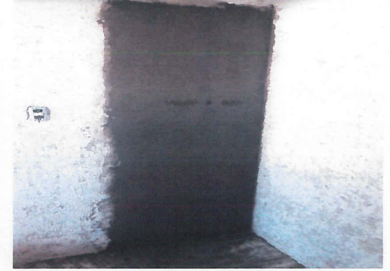
Aplanado fino en muros con mortero cemento-arena 1:6
