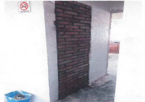
Aplanado fino en muros con mortero cemento-arena 1:6
