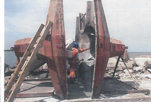
Se aplica desmoldante a la cimbra metalica para evitar que se adiera el concreto a la cimbra durante el colado.
