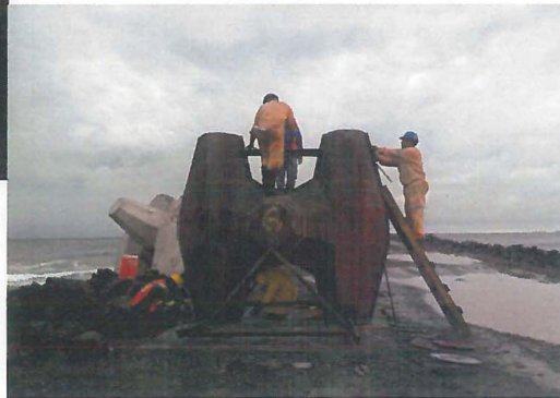
Se realiza la instalacion de los tornillos de 5/8 x2" para union de las dos caras de cimbra.
