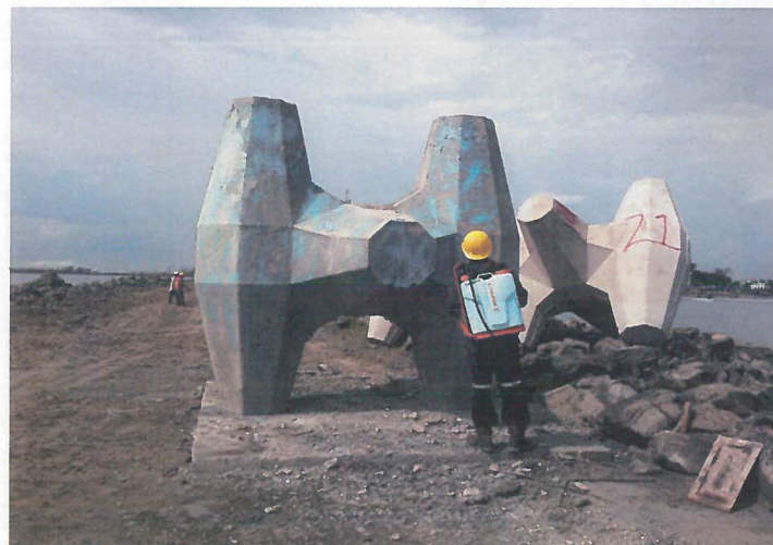
Se aplica el curacreto con bomba tipo mochila a los Core-Loc's.
