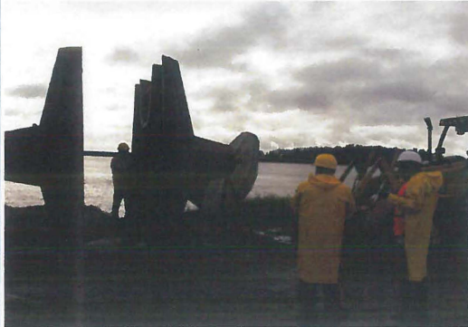
Se rehubican cimbras metálicas a las plantillas de Concreto
