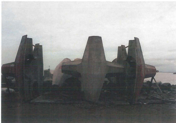
Se realizan los trabajos de decimbrado de los Core-Loc's.
