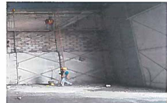
suministro y habilitado de acero para castillos
