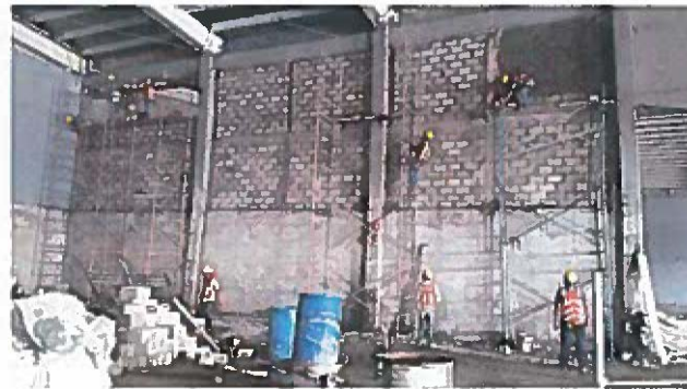
construccion de muro de block de 12x20x40 cm
