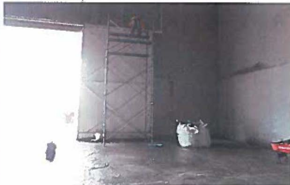
pintura en eje m
