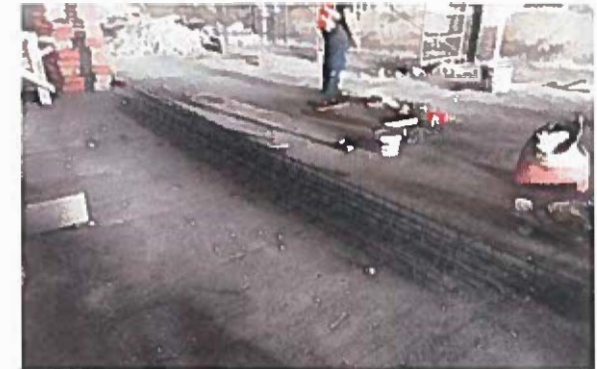
suministro y habilitado de acero para castillos
