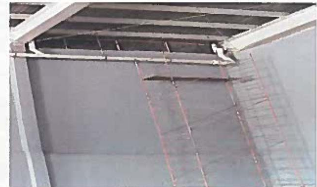
suministro y colocacion de bajante
