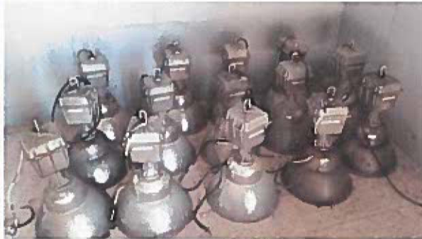
retiro de luminarias
