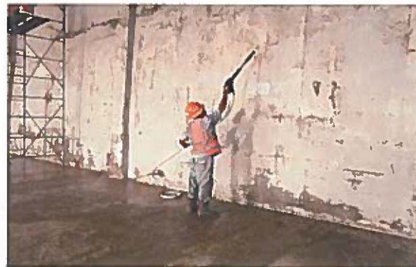
lavado de muros en paredes interiores de bodega
