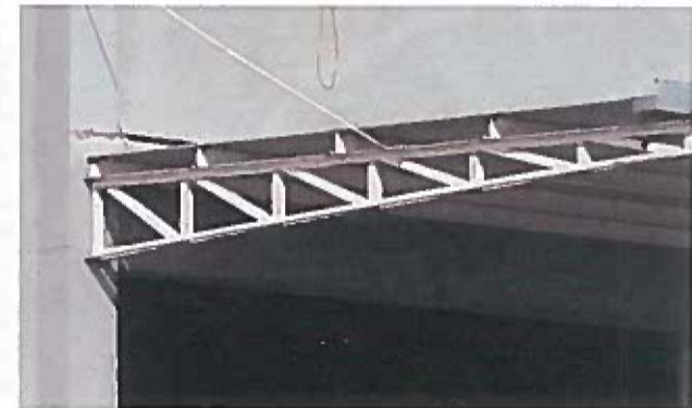
comienzo de ranurado para colocacion de lamina
