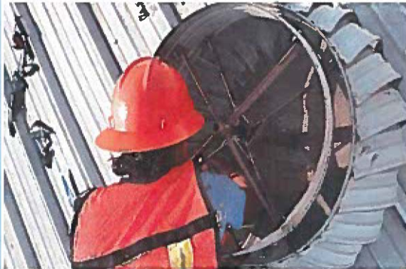
limpieza de extractores.
