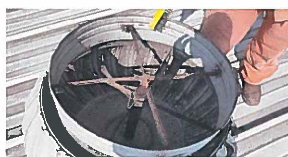
limpieza de extractores
