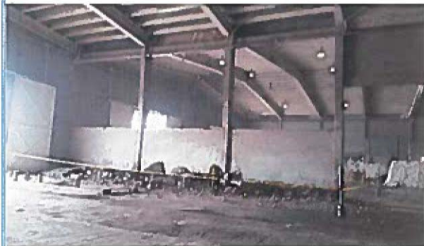
demolicion de muro en eje m
