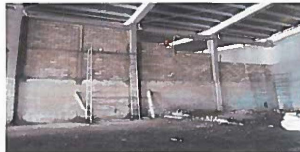
cimbrado de castillos y cadena
