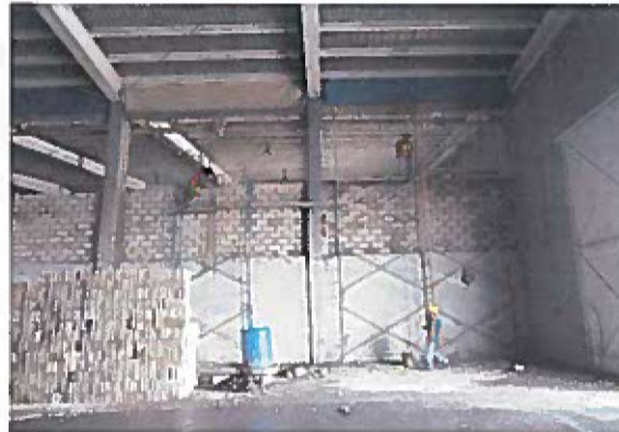
construccion de muro de block de 12x20x40 cm
