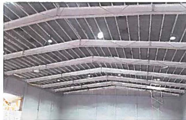
suministro y colocacion de luminaria
