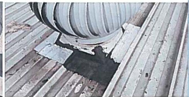
sellado con tpo band y plastic cement en extractores
