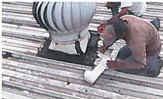
colocacion de cinta luminada en extractores
