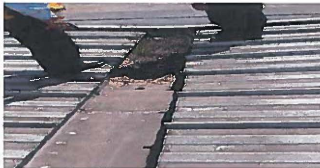
revison de bajantes agua pluvial
