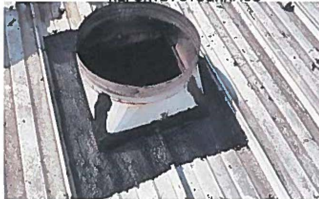
retiro de extractores para su limpieza
