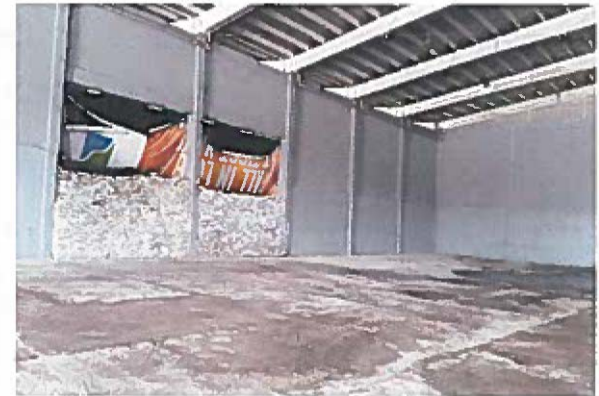
terminacion de pintura en diferentes ejes
