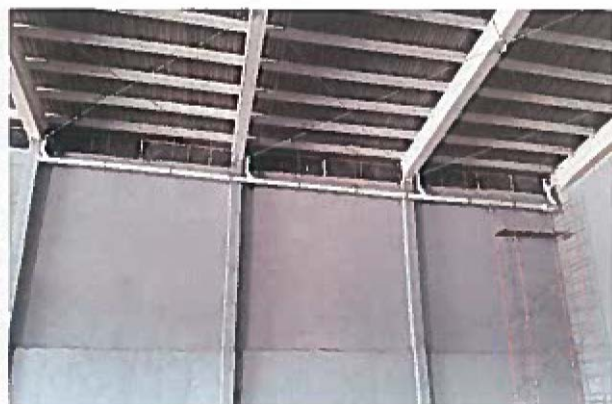
suministro de bajante de agua pluvial
