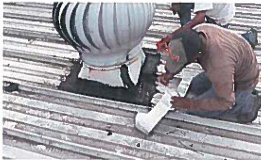
colocacion de cinta luminada en extractores
