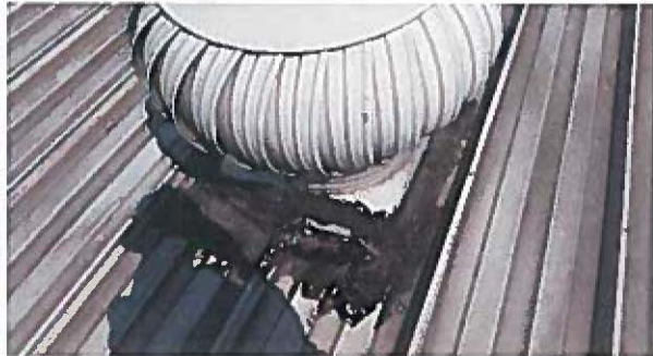
revison de extractores dañados
