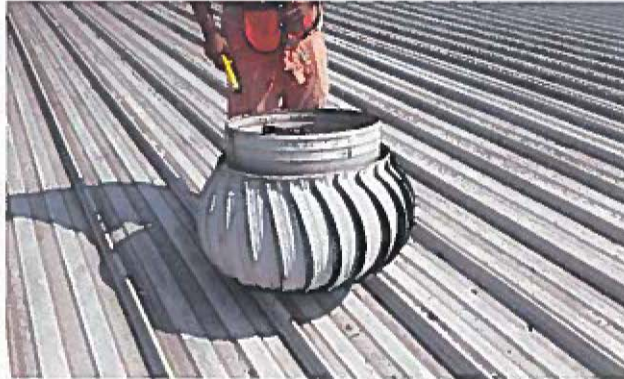
retiro de extractores para su limpieza
