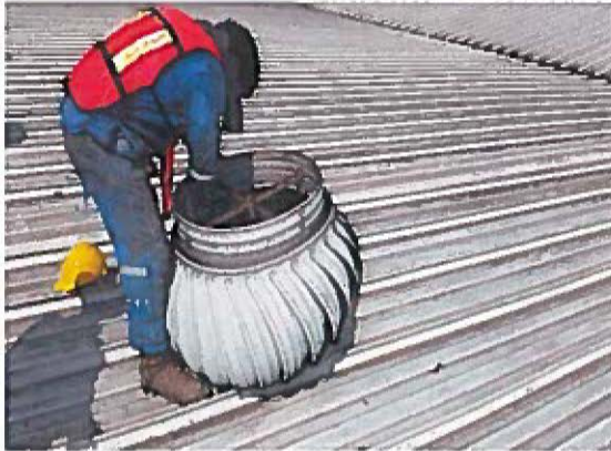
limpieza de extractores.
