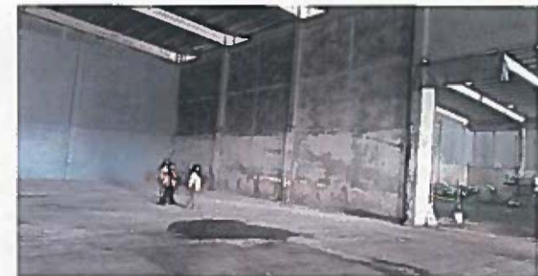
reboque de muro eje g terminado
