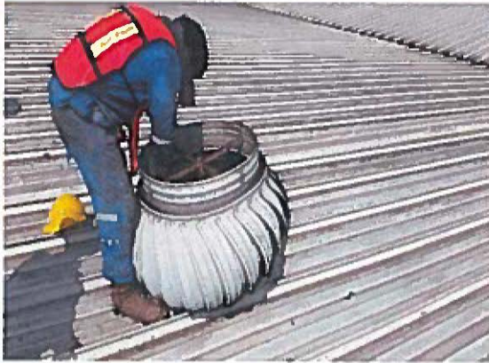
limpieza de extractores.
