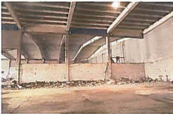
demolicion de muro en eje m
