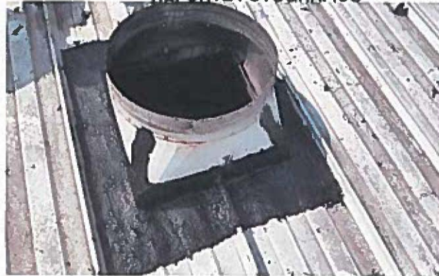
retiro de extractores para su limpieza
