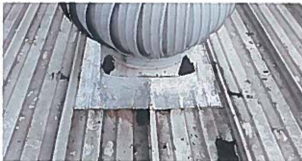
sellado de extractores.
