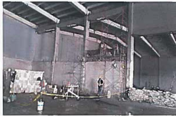
construccion de muro de block de 12x20x40 cm
