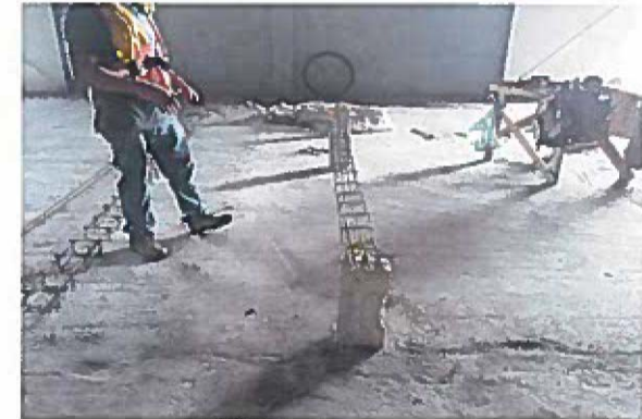
suministro y habilitado de acero para castillos
