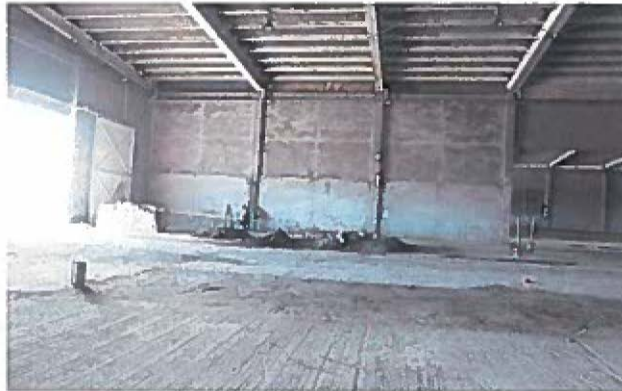
terminacion de aplano en muro de block
