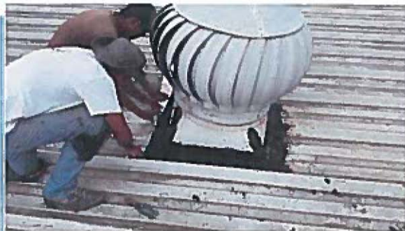
colocacion de cinta luminada en extractores
