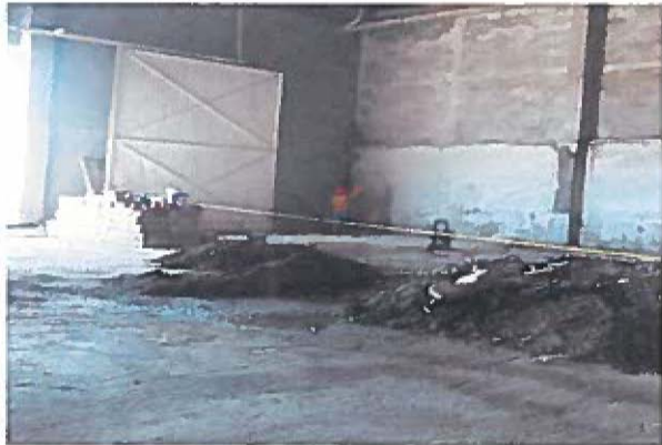
terminacion de lavado de muros
