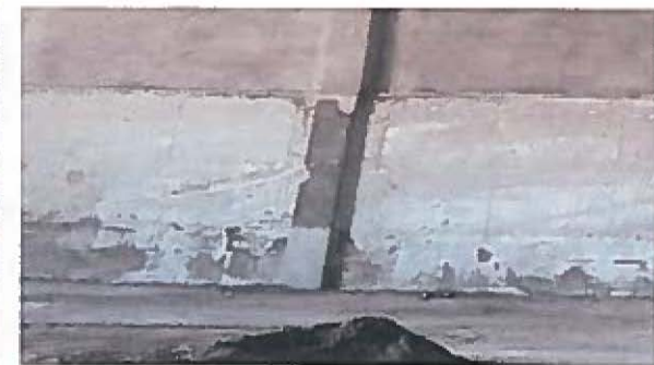
terminacion de Resane en desconchamiento de concreto
