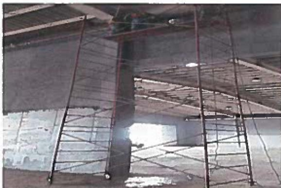
RETIRO DE BAJANTES AGUA PLUVIAL
