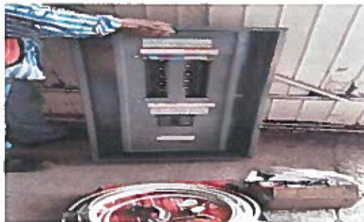
mantenimiento a tablero de distribucion
