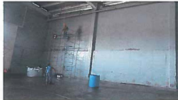
lavado de muros en paredes interiores de bodega
