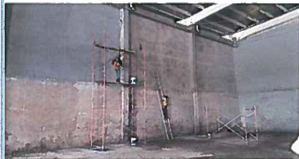
pintura en eje m
