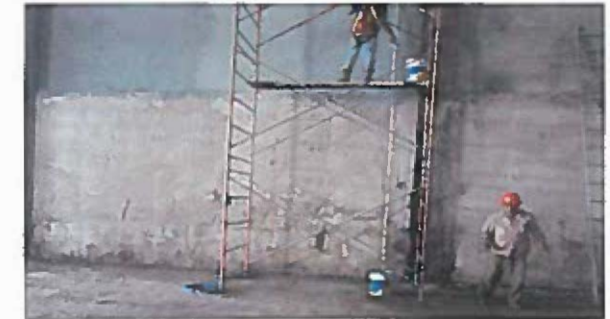
pintura de muro en eje A
