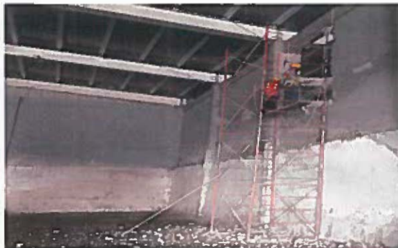
demolicion de muro en eje G
