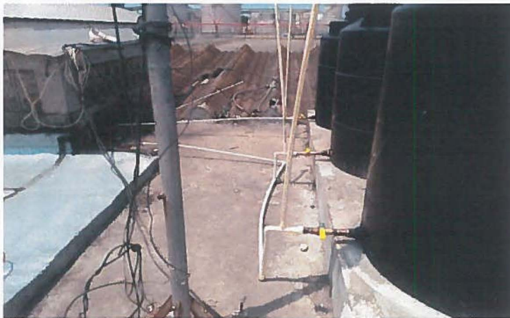
Instalacion de tuberia de cpvc para alimentar muebles sanitarios. Asi mismo, se realizo limpieza a los tinacos existentes.
