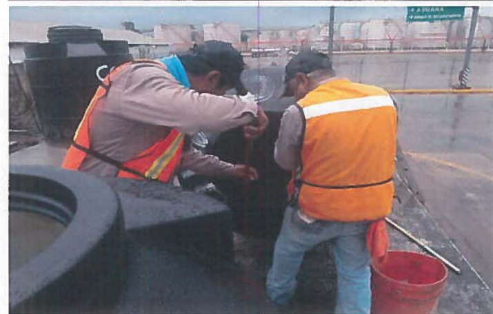
Instalacion de tuberia de cpvc para alimentar muebles sanitarios. Asi mismo, se realizo limpieza a los tinacos existentes.
