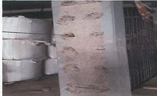
Demolición de columna para anclar estribos
