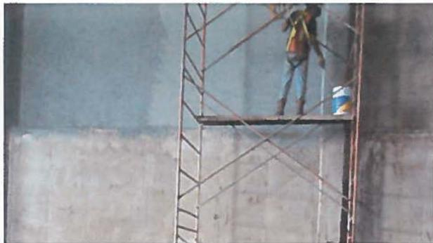
Sellador y pintura acrílico en muro de block
