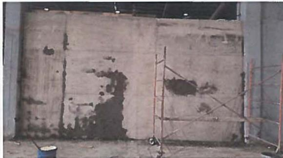
Colocación de curacreto en muro de concreto
