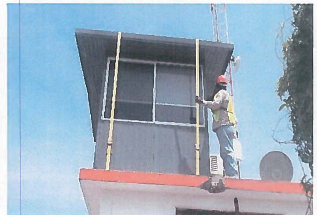
Instalacion de barandales en atracadero gitana asi como en la parte superior e instalacion de eslingas en casetas ubicadas en muelle tramo I y II.
