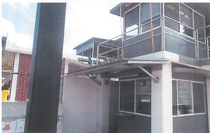
Instalacion de cubierta con estructura de PTR y lamina galvanizada asi como instalacion de respisa de acero inoxidable, en area de caseta situada en muelle tramo I.
