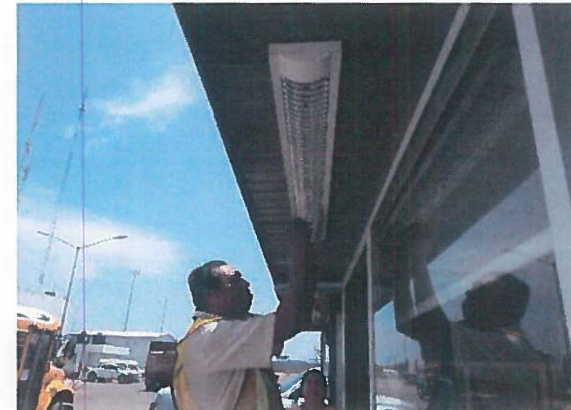
Trabajos de instalacion de luminarios y apagadores en casetas de vigilancia de la UNAPROP-14.
