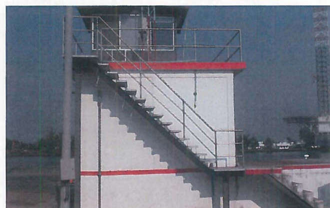
Instalacion de barandales en planta de azotea de cuarto de bombas y en area de atracadero de muelle tramo I.
