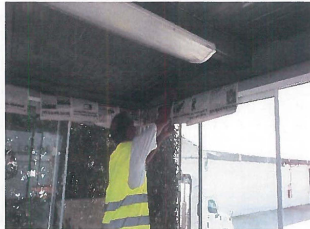
Aplicación de pintura con esmalte alquidalico anticorrosivo brillante en casetas prefabricadas.
