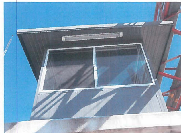
Aplicación de pintura con esmalte alquidamico anticorrosivo brillante en casetas prefabricadas.
