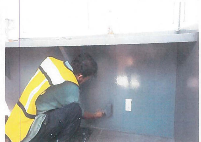
Aplicación de pintura con esmalte alquidalico anticorrosivo brillante en casetas prefabricadas.
