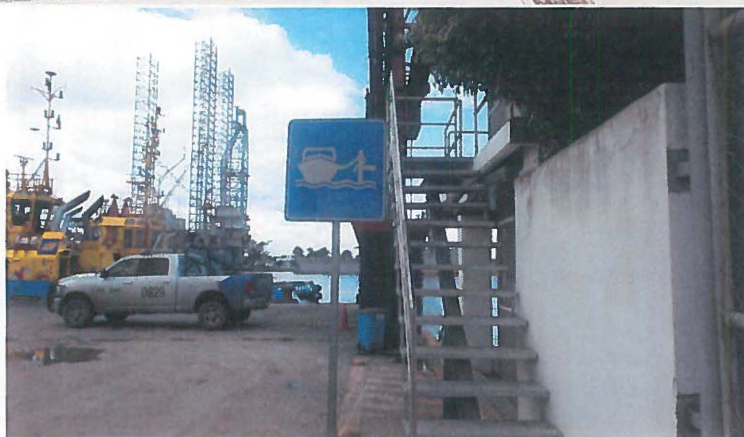
Fabricacion e instalacion de escalera a base de vigas IPR y escalones con lamina antiderrapante, para accesos a casetas situadas en planta alta en muelle tramo I y II.
