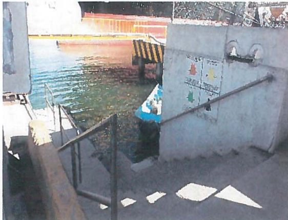
Instalacion de barandales en atracadero gitana asi como en la parte superior e instalacion de eslingas en casetas ubicadas en muelle tramo I y II.
