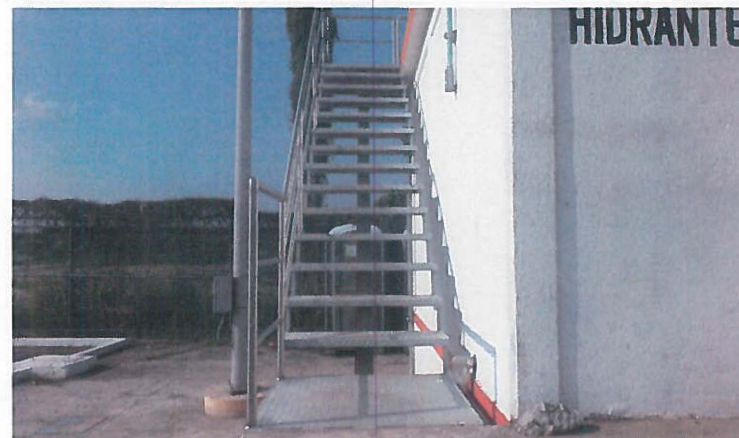
Fabricacion e instalacion de escalera a base de vigas IPR y escalones con lamina antiderrapante, para accesos a casetas situadas en planta alta en muelle tramo I y II.
