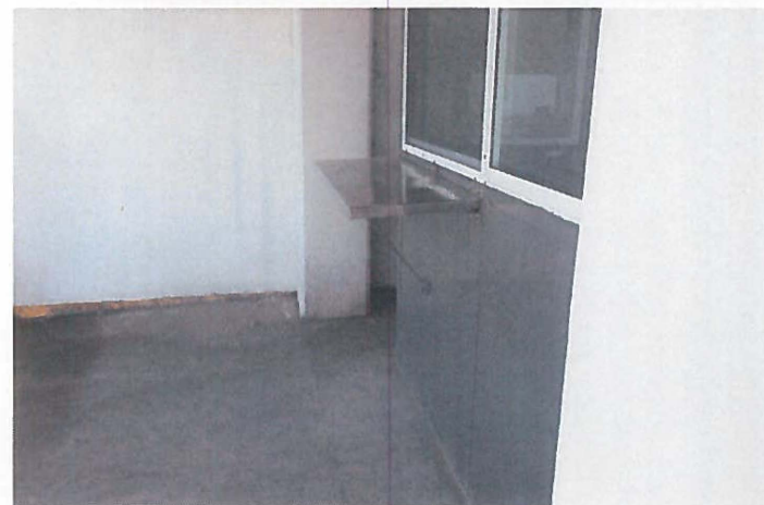
Instalacion de cubierta con estructura de PTR y lamina galvanizada asi como instalacion de respisa de acero inoxidable, en area de caseta situada en muelle tramo I.
