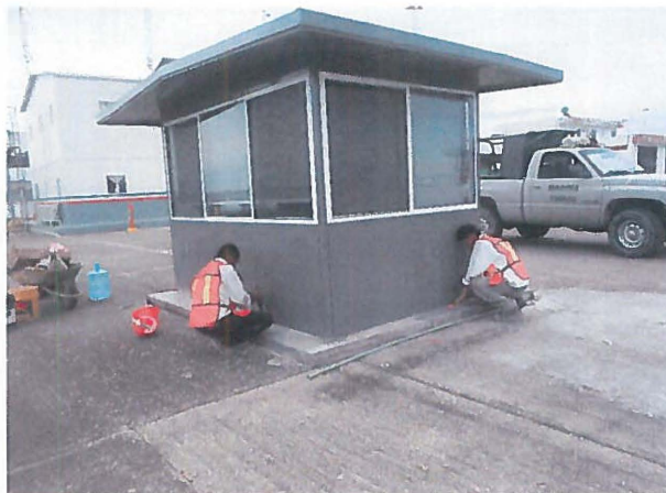
Aplicación de pintura con esmalte alquidamico anticorrosivo brillante en casetas prefabricadas.
