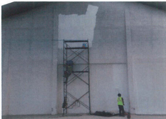
APLIACIÓN DE PINTURA EN MUROS INTERIORES
