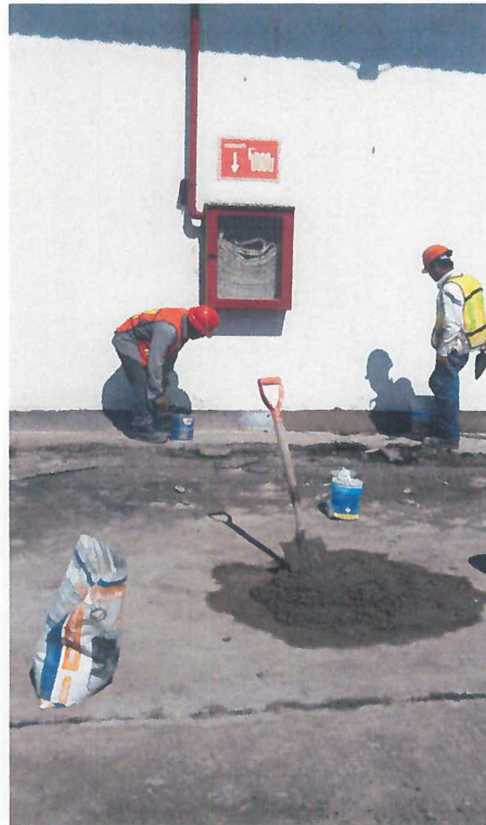
CONSTRUCCIÓN DE CHAFAN EN MURO EXTERIOR DE LA BODEGA A BASE DE MORTERO EXPANSIVO (SIKAGROUT)
