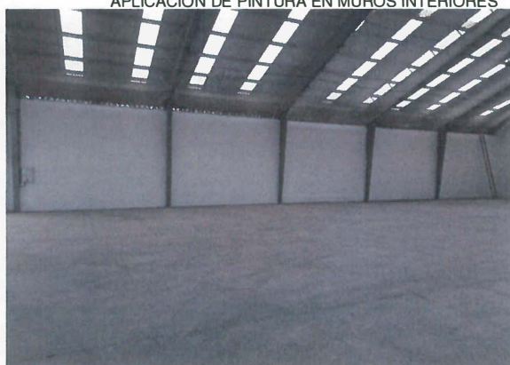
CONCEPTO DE PINTURA TERMINADO EN NAVE 1
