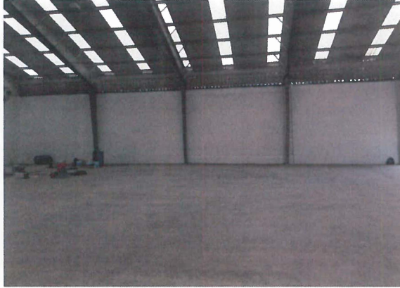
APLIACIÓN DE PINTURA EN MUROS INTERIORES
