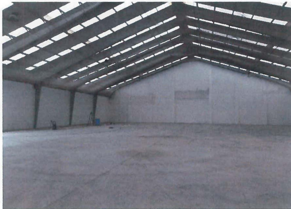
APLICACIÓN DE PINTURA EN MUROS INTERIORES
