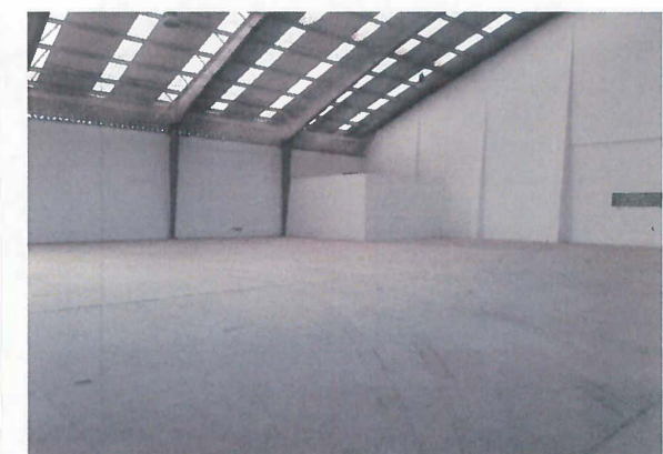
CONCEPTO DE PINTURA TERMINADO EN NAVE 2
