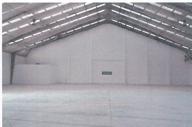
CONCEPTO DE PINTURA TERMINADO EN NAVE 2
