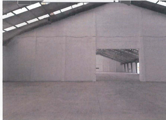
APLICACIÓN DE PINTURA EN MUROS INTERIORES
