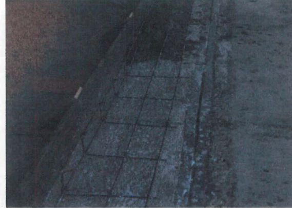
CONSTRUCCIÓN DE SARDINEL A BASE DE CONCRETO f'c=200 kg/cm2
