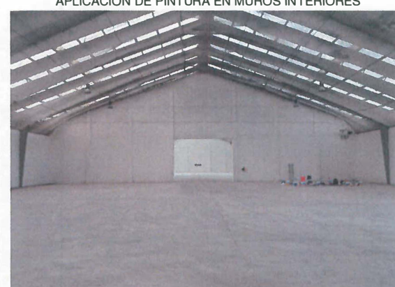
CONCEPTO DE PINTURA TERMINADO EN NAVE 1
