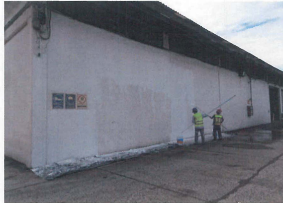
APLICACIÓN DE PINTURA EN MURO EXTERIOR
