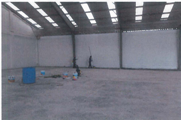
APLICACIÓN DE PINTURA EN MUROS INTERIORES
