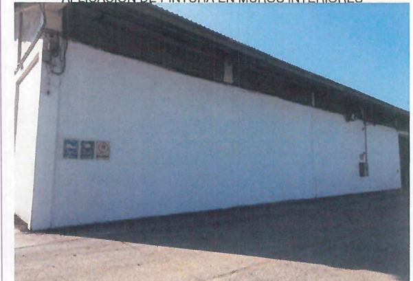
CONCEPTO DE PINTURA TERMINADO EN MURO EXTERIOR FRONTAL
