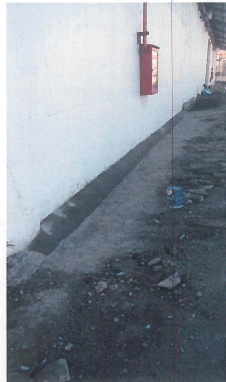
CONSTRUCCIÓN DE CHAFAN EN MURO EXTERIOR DE LA BODEGA A BASE DE MORTERO EXPANSIVO (SIKAGROUT)
