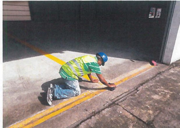
APLICACIÓN DE PINTURA AMARILLA TRAFICO DE 20 CM DE ESPESOR EN BODEGA DE TRANSITO
