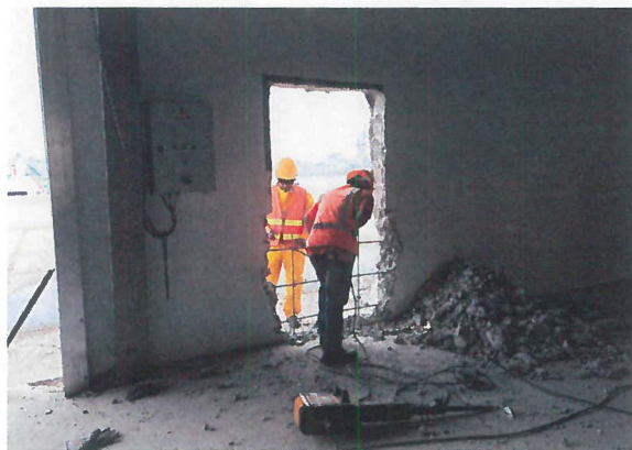
DEMOLICION DE MURO ARMADO DE 20 CM. DE ESPESOR
