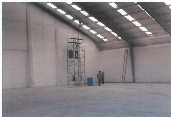
APLICACIÓN DE SELLADOR Y PINTURA EN MUROS LATERALES
