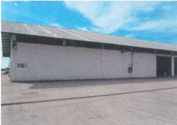
APLICACIÓN DE PINTURA EN MURO EXTERIOR
