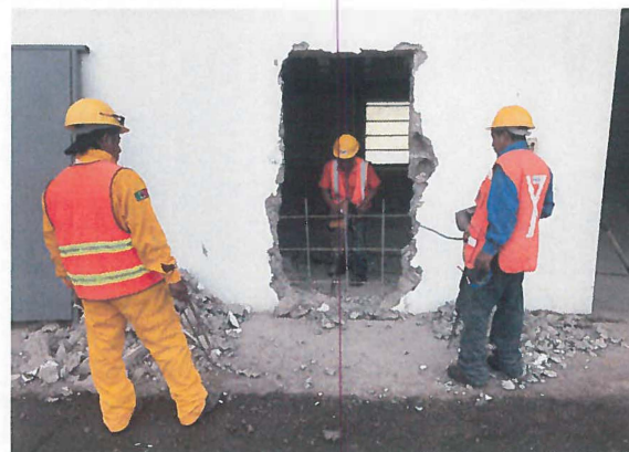
DEMOLICION DE MURO ARMADO DE 20 CM. DE ESPESOR
