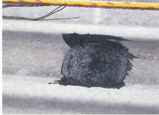
SELLADO DE GOTERAS EN TECHUMBRE DE LAMINA EN BODEGA DE TRANSITO
