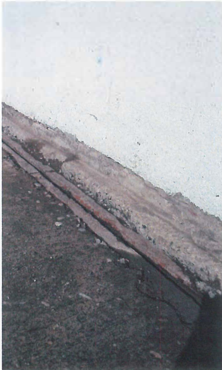
CONSTRUCCIÓN DE CHAFAN EN MURO EXTERIOR DE LA BODEGA A BASE DE MORTERO EXPANSIVO (SIKAGROUT)
