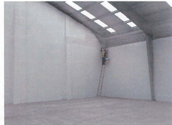
APLICACIÓN DE PINTURA EN MUROS INTERIORES
