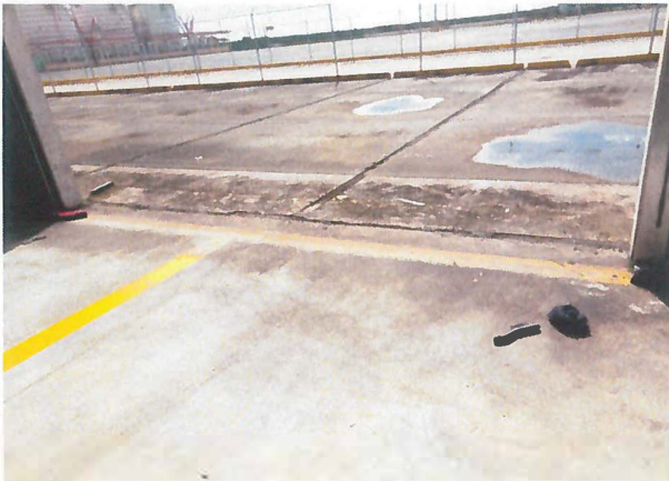
APLICACIÓN DE PINTURA AMARILLA TRAFICO DE 20 CM DE ESPESOR EN BODEGA DE TRANSITO
