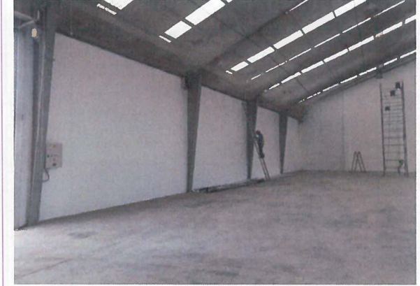
APLICACIÓN DE PINTURA EN MUROS INTERIORES
