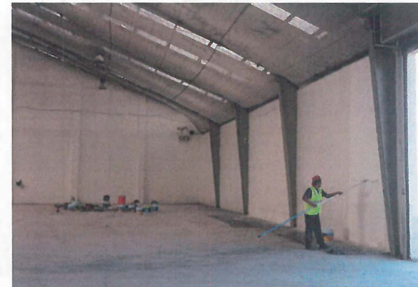
APLICACIÓN DE PINTURA EN MUROS INTERIORES
