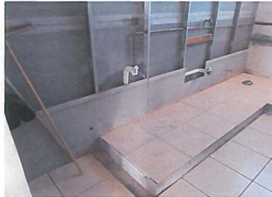
Evidencia fotografica de los trabajos relacionados con **instalaciones hidrosanitarias**, se instalaron salidas sanitarias en area de sanitarios con tuberia de 2" y 4" mismos que fueron conectados al bajante de aguas negras existente,asi mismo instalacion de salidas hidraulicas para alimentar muebles sanitarias conectandolas desde las existentes con tuberia de cobre de 1/2", asi mismo se realizo la instalacion de muebles sanitarios en area de baños para hombres;
