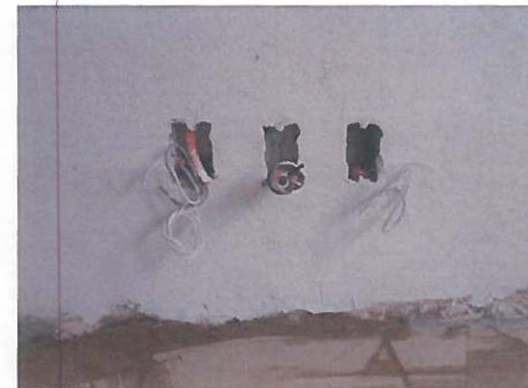
Evidencia fotografica de los trabajos relacionados con **instalaciones electricas**, se realizaron los trabajos de instalacion de salidas electricas para contactos regulados, de seguridad y normales, para voz y datos, iluminacion y apagadores con tuberia mixta de 3/4 asi como el tendido de cable para ambas, y salidas para extractores en area de sanitarios, instalacion de tableros de 30 y 12 circuitos.
