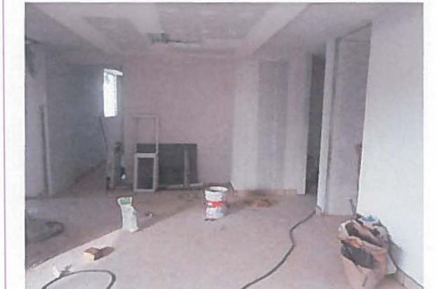
Evidencia fotografica de los trabajos relacionados con **pisos**, se realizo colocacion de azulejo y piso en muros de sanitarios, e iniciaron trabajos aplicacion de pasta en muros y piso en area comun de edificio.
