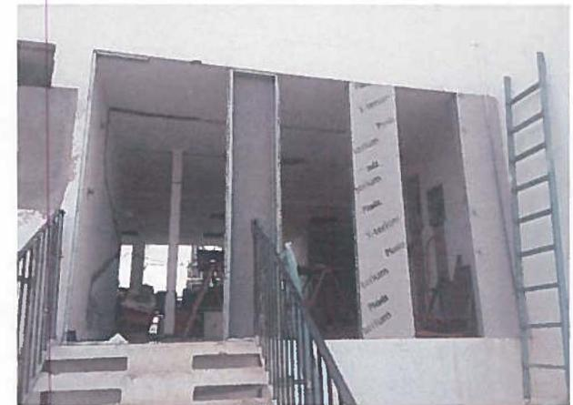
Evidencia fotografica de los trabajos relacionados con **acabados y pisos**, se realizo instalacion de muro de durock en area de ventanas y puertas canceladas, muros divisorios en sanitaria y archivo con acabado basecoat ambas caras, e instalacion de plafon liso de tablaroca con suspension oculta en area de oficinas y area comun.
