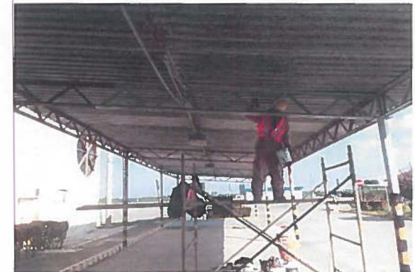
MANTENIMIENTO A ESTRUCTURA DE COBERTIZO DE ESTACIONAMIENTO DE LA APITUXPAN
