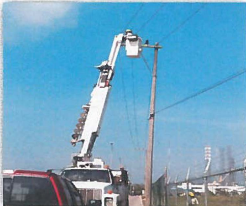
DESMANTELAMIENTO Y RETIRO DE CABLE DE ALUMINIO AAC 266.8
