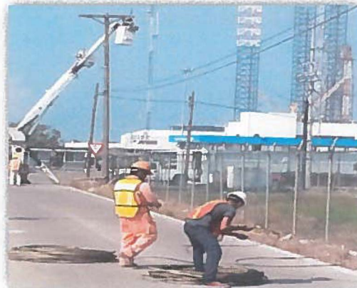
DESMANTELAMIENTO Y RETIRO DE CABLE DE ALUMINIO AAC 1/0
