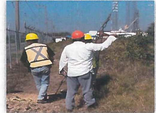
DESMANTELAMIENTO Y RETIRO DE RETENIDA
