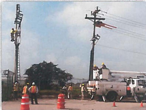
PREPARACIONES PARA INTERCONEXIÓN DEL SISTEMA 34.5 KVA
