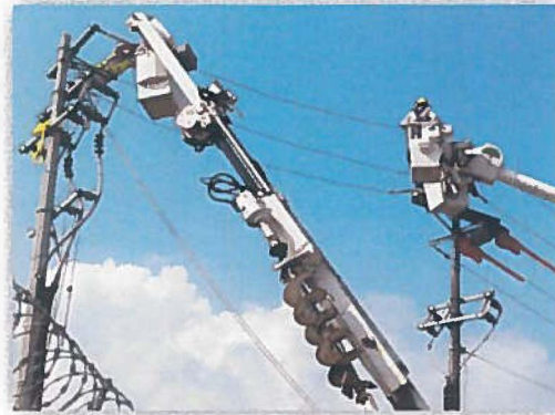
INTERCONEXIÓN DEL SISTEMA 34.5 KVA
