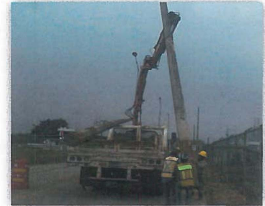
DESMANTELAMIENTO Y RETIRO DE POSTES DE CONCRETO PC-13-600
