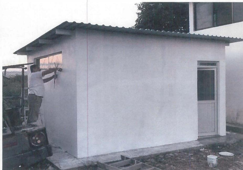
Aplicación de sellador en juntas de ventanas y puertas, Incluye: limpieza de la superficie, aplicación de sellador Adhesivo elástico de poliuretano de curado rápido y alto desempeño Sikabond o similar en calidad, consumibles, materiales, mano de obra, equipo, herramienta y todo lo necesario para su correcta ejecución del concepto, P.U.O.T
