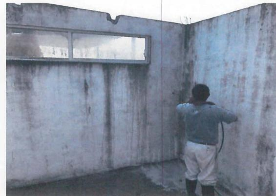
Lavado en muros base de chorro de agua a presión con hidrolavadora, incluye: andamios, consumibles, materiales, mano de obra, equipo, herramientas y todo lo necesario para la correcta ejecución del concepto de trabajo, P.U.O.T.
