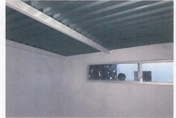
Suministro y colocación de techumbre de 5.47 x 3.88 mts a base de canal monte de 4" x 2" C-14, lamina acanalada r-110 c-26 zintroalum marca ternium o similar en calidad, Incluye: preparación de la superficie, fijación de la lámina a estructura y colocación de la misma, andamios, consumibles, materiales, mano de obra, equipo, herramienta y todo lo necesario para la correcta ejecución del concepto P.U.O.T.
