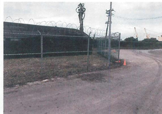
Mantenimiento de concertina helicoidal tipo arpón de 45 cm de diámetro, incluye: retiro y colocación de concertina y tres hilos de alambre de púas, materiales, mano de obra, equipo, herramienta, y todo lo necesario para la correcta ejecución del concepto, P. U. O. T.
