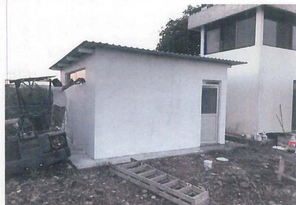
Suministro y aplicación de pintura vinílica marca Comex línea vinimex o similar color blanco aplicada en dos manos en muros exteriores e interiores hasta una altura promedio de 3 metros, Incluye: preparación de la superficie, resanes en su caso, aplicación de sellador 5:1 marca Comex o similar, andamios, consumibles, materiales, mano de obra, equipo, herramienta, y todo lo necesario para la correcta ejecución del concepto P.U.O.T.
