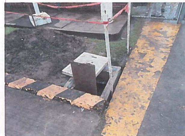
Concluye la instalación de registros prefabricados para la conexión de banco de ductos que comunicaran a Edificios con la introducción de fibra optica.
