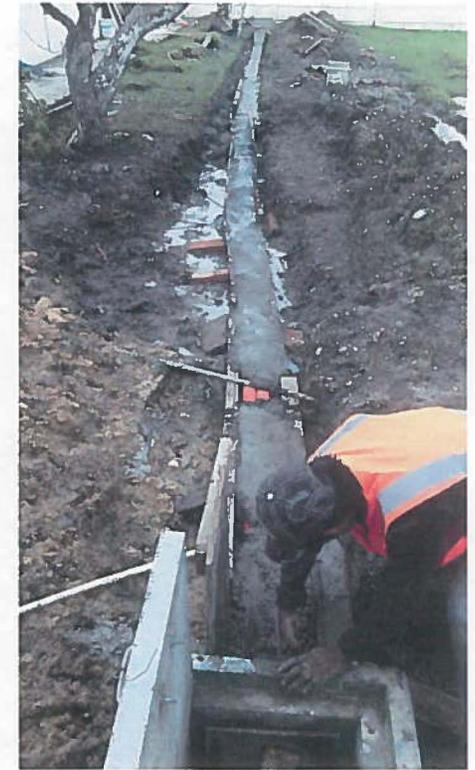
Concluye la construcción de banco de ductos a base de dos ductos de 2" pulgadas pared lisa para la conexión de registros No. 4, No.5, No.6 y No.7 que comunicaran a Edificios con la introducción de fibra optica.
