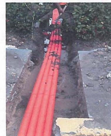
Se realizaron corte y demolición de guarniciones, banquetas y vialidad para alojamiento de bancos de ductos y registros prefabricados conforme a proyecto.
