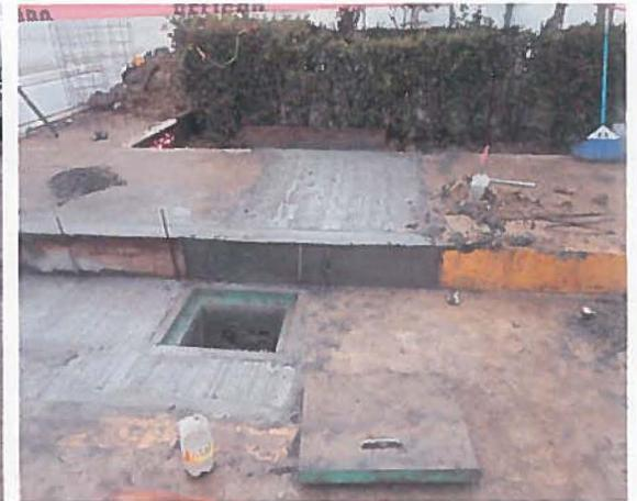
Se realizaron trabajos de reposición en guarniciones, banquetas y vialidad en área de bancos de ductos y colocación de registros del No. 1 al No.4, conforme a proyecto.
