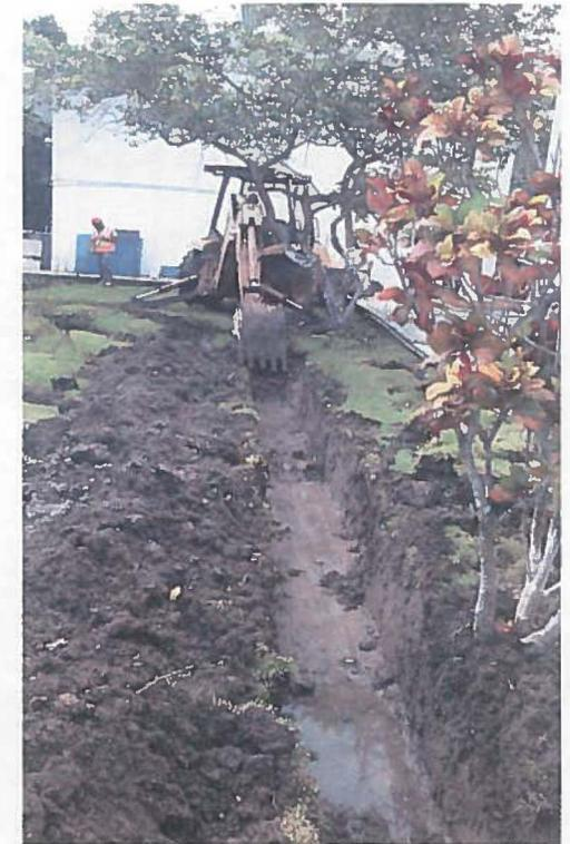
Se realizaron los trabajos de trazo y nivelacion para alojamiento de bancos de ductos y registros prefabricados conforme a proyecto, asi mismo la demolicion, excavacion para su construccion.
