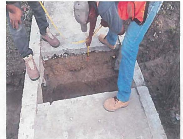
Se realizaron los trabajos de trazo y nivelacion para alojamiento de bancos de ductos y registros prefabricados conforme a proyecto, asi mismo la demolicion, excavacion para su construccion.
