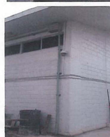
Se realizaron los trabajos de instalación de ducto de pared lisa para alojamiento de cables de fibra óptica a base de tubo de pvc de uso pesado de 2" de diámetro, para interconexión de registros y edificios.
