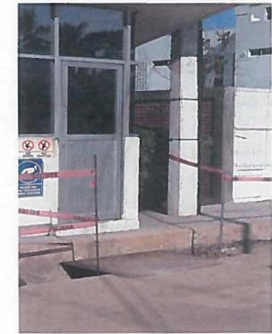
Se realizaron corte y demolición de guarniciones, barnquetas y vialidad para alojamiento de bancos de ductos y registros prefabricados conforme a proyecto.
