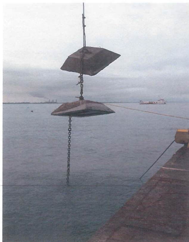
Trabajos de extraccion de los muertos situados en cada una de las boyas instaladas, las cuales estaban fondeadas con dos muertos.
