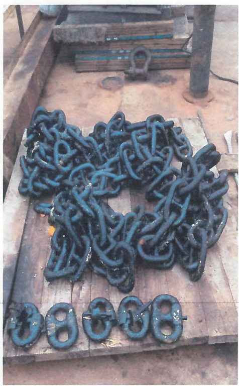
Trabajos de Instalacion de la ampliacion de la cadena en cada una de las boyas instaladas, se añadió 5 metros de cadena para una longitud de 35 metros en su totalidad en cada una.
