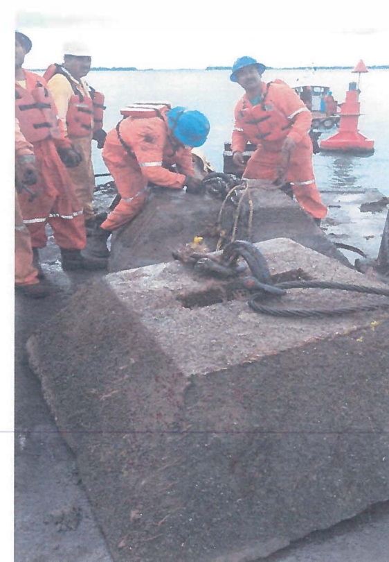
Trabajos de extraccion de los muertos situados en cada una de las boyas instaladas, las cuales estaban fondeadas con dos muertos.
