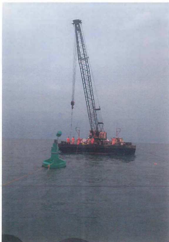
Trabajos de extraccion de los muertos situados en cada una de las boyas instaladas, las cuales estaban fondeadas con dos muertos.
