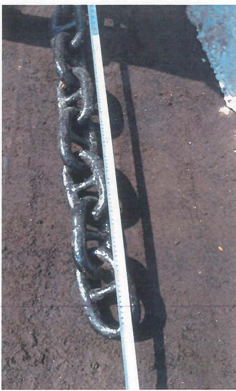
Trabajos de Instalacion de la ampliacion de la cadena en cada una de las boyas instaladas, se añadió 5 metros de cadena para una longitud de 35 metros en su totalidad en cada una.
