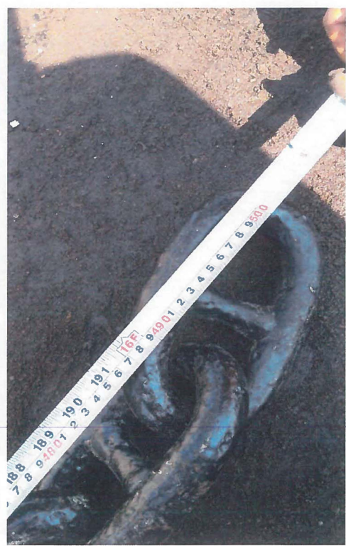
Trabajos de Instalacion de la ampliacion de la cadena en cada una de las boyas instaladas, se añadió 5 metros de cadena para una longitud de 35 metros en su totalidad en cada una.
