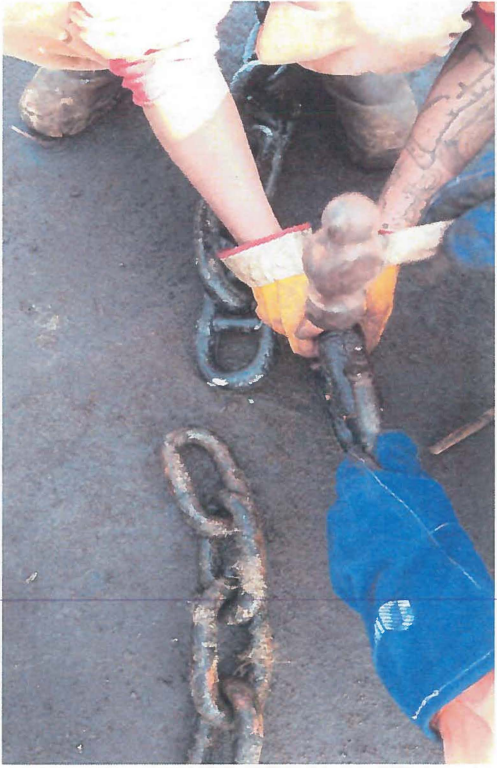
Trabajos de Instalacion de la ampliacion de la cadena en cada una de las boyas instaladas, se añadió 5 metros de cadena para una longitud de 35 metros en su totalidad en cada una.
