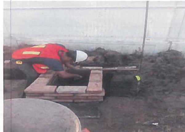
Introduccion de linea a base de tuberia de 6" para descarga de aguas negras y su conexión de registros asi como fabricacion de registros conforme a proyecto.
