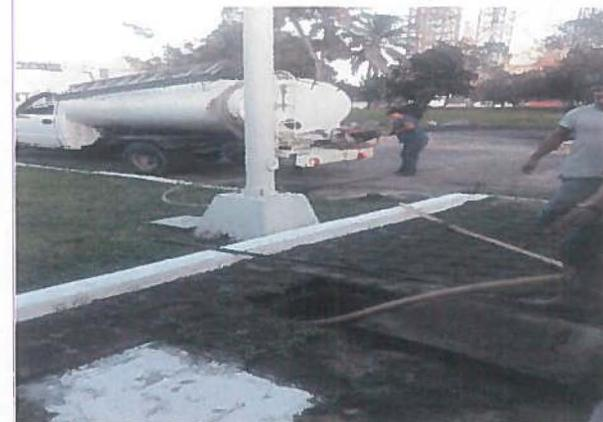
Se realizaron trabajos de limpieza de la red de atarjeas, realizando desazolve y limpieza de linea que conecta registros y pozos de visita que descargan hacia la planta de tratamiento.
