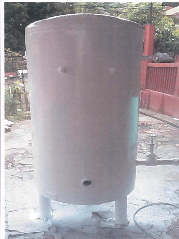
Trabajos de reparación a tanque hidroneumático, consistente en reposición de fondo, con placa metálica de 1/4", aplicación de primario epóxico de dos componentes Pemex RP-6, de la marca Sherwin Williams o similar, y como acabado aplicación de esmalte de poliuretano Pemex RA-28 en dos capas, de la marca Sherwin Williams o similar.
