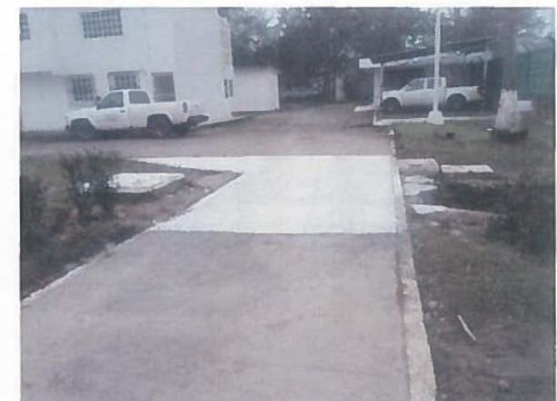
Rehabilitación de vado en áreas administrativas de la APITUXPAN, realizando la demolición del concreto existente, maniobras para retirar tubos existentes, transporte y colocación de tubos de concreto, encofrado de tubos con concreto  $f'c=250 \text{ kg/cm}^2$ , reposición de losa de concreto hidráulico  $f'c=250 \text{ kg/cm}^2$  reforzado con malla electro soldada 66-1010.
