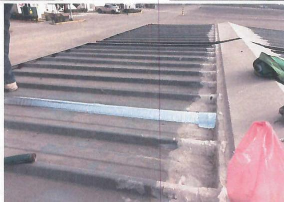
Aplicación de plastic cement y top band adherible de asfalto modificado en juntas de cubierta de lámina. Incluye; limpieza de la superficie, consumibles, materiales, mano de obra, equipo, herramienta y todo lo necesario para la correcta ejecución del concepto P.U.O.T.
