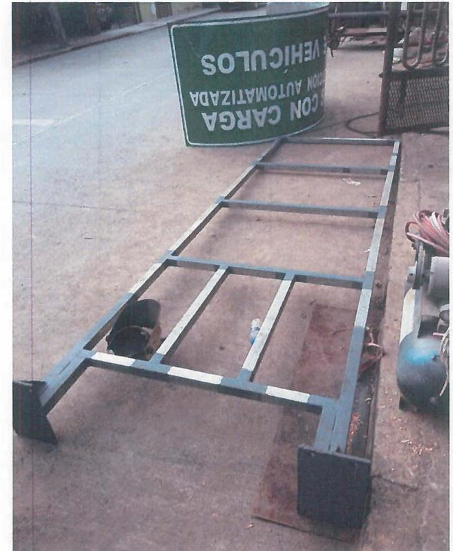
Rehabilitación de tablero de señal vertical elevada informativa de destino tipo bandera SID -13 de 122x366 cm, Incluye: enderezamiento de lámina galvanizada calibre 16, nueva tornillería de acero galvanizado para sujeción con bastidor, aplicación de primario para lámina galvanizada Línea E61/R07KJ56 en tablero, suministro y colocación de PTR de 1 1/2" x 1 1/2", consumibles, materiales, mano de obra, equipo, herramienta y todo lo necesario para la correcta ejecución del concepto P.U.O.T.
