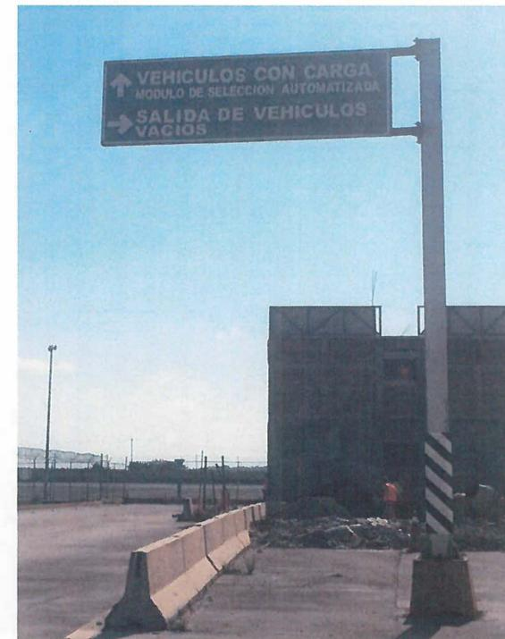
Rehabilitación de tablero de señal vertical elevada informativa de destino tipo bandera SID -13 de 122x366 cm, Incluye: enderezamiento de lámina galvanizada calibre 16; nueva tomillería de acero galvanizado para sujeción con bastidor, aplicación de primario para lámina galvanizada Línea E61/R07K-06 en tablero, suministro y colocación de PTR de 1 1/2" x 1 1/2", consumibles, materiales, mano de obra, equipo, herramienta y todo lo necesario para la correcta ejecución del concepto P.U.O.T.
