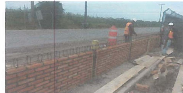
Armado de Castillos y cadenas vs. No. 3 en muro
