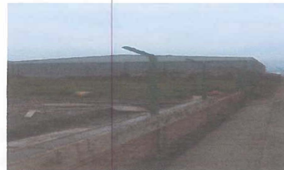
Armado de Castillos y cadenas vs. No. 3 en muro
