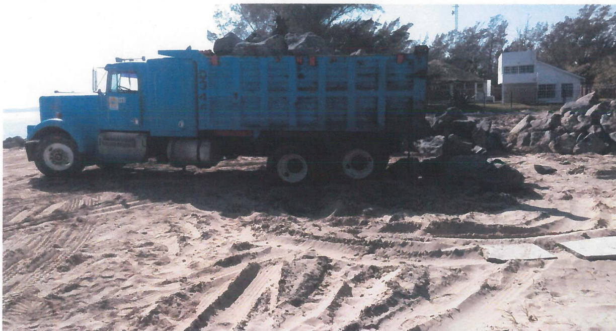
Se da continuidad al acarreo y se almacena provisionalmente la piedra secundaria.
