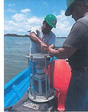
"PROCESO DE COLOCACION DE ESTRUCTURA DE ACERO INOXIDABLE EN BOYAS No. 7 Y 8"
