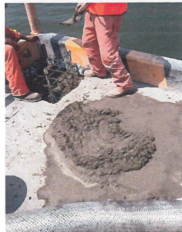
FABRICACIÓN DE BASE PARA SOPORTAR BALIZA
