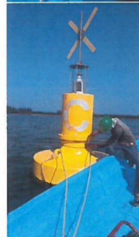
"PROCESO DE COLOCACION DE ESTRUCTURA DE ACERO INOXIDABLE EN BOYAS No. C"
