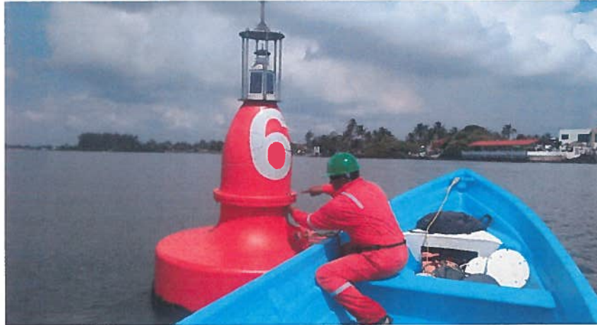
"PROCESO DE COLOCACION DE ESTRUCTURA DE ACERO INOXIDABLE EN BOYAS No. 5 Y 6"
