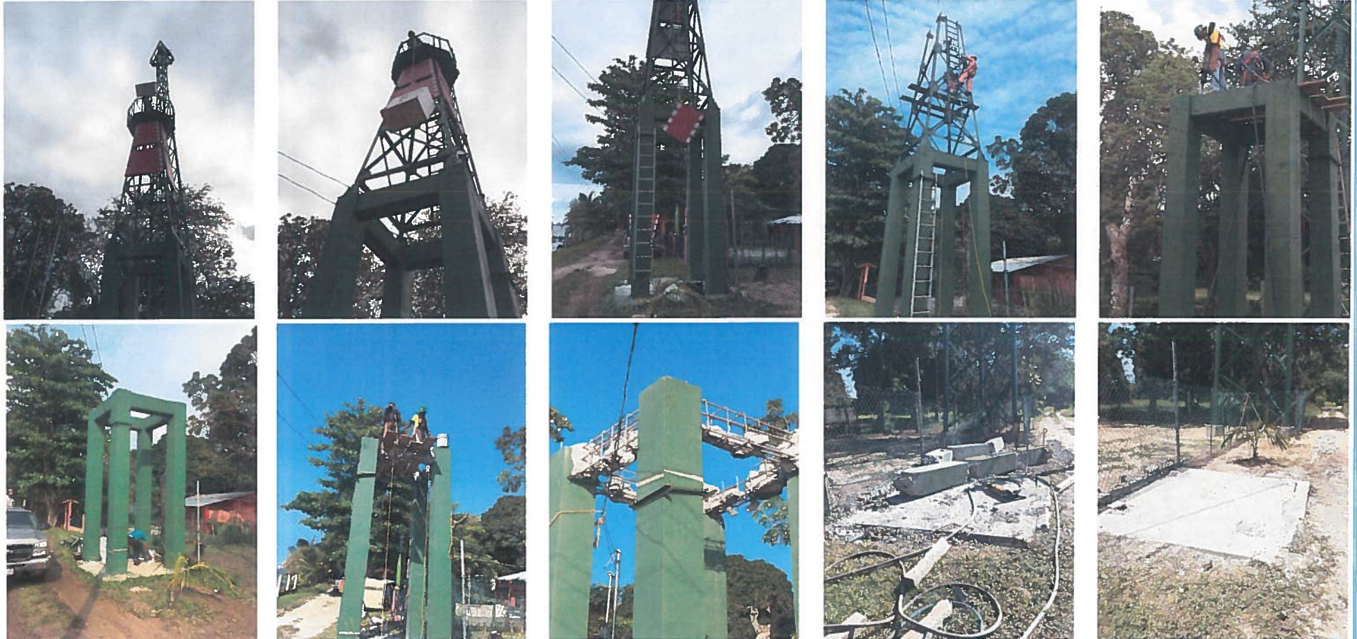
"PROCESO DE DESMANTELAMIENTO DE BALIZA "COBOS"
