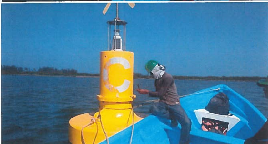
"PROCESO DE COLOCACION DE ESTRUCTURA DE ACERO INOXIDABLE EN BOYAS No. C"
