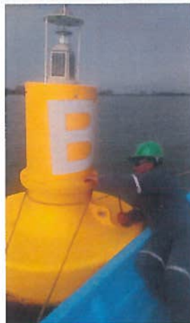
"PROCESO DE COLOCACION DE ESTRUCTURA DE ACERO INOXIDABLE EN BOYAS No. A y B"
