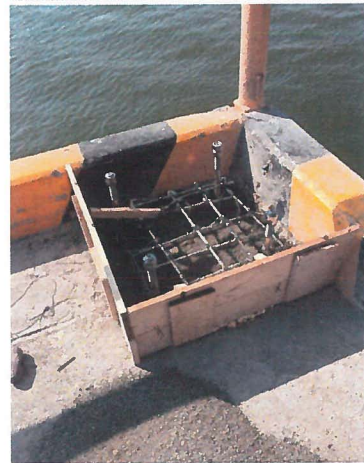
FABRICACIÓN DE BASE PARA SOPORTAR BALIZA
