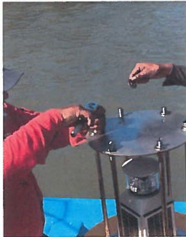
"PROCESO DE COLOCACION DE ESTRUCTURA DE ACERO INOXIDABLE EN BOYAS No. A y B"
