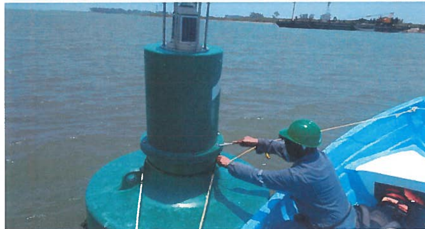
"PROCESO DE COLOCACION DE ESTRUCTURA DE ACERO INOXIDABLE EN BOYAS No. 9 Y 11"
