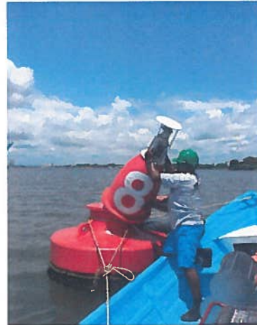
"PROCESO DE COLOCACION DE ESTRUCTURA DE ACERO INOXIDABLE EN BOYAS No. 7 Y 8"
