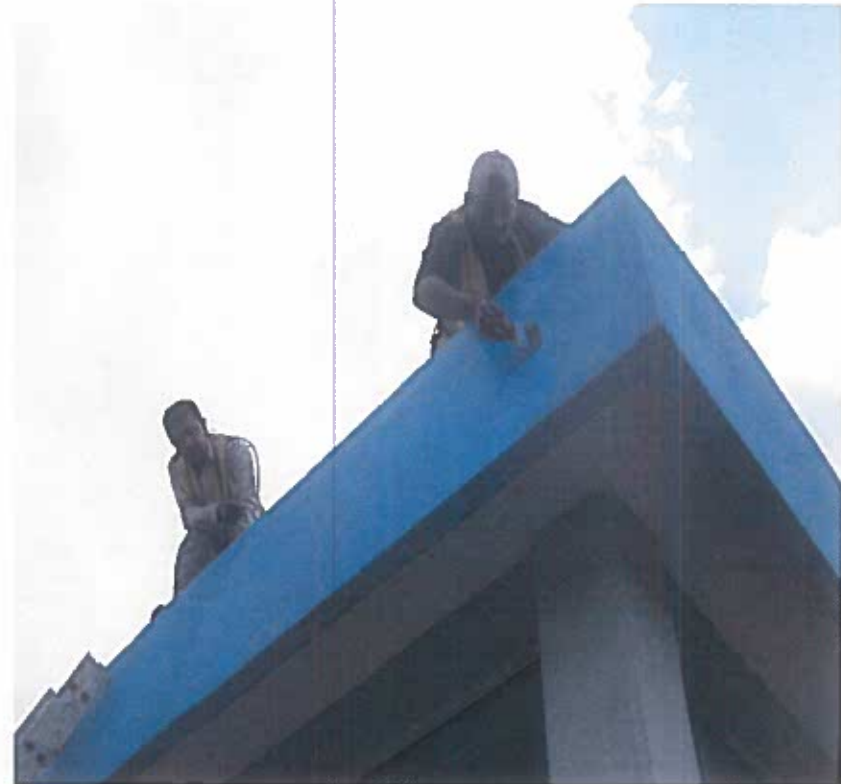
APLICACIÓN DE PINTURA VINILICA EN SUBESTACION ELECTRICA PRINCIPAL DE ENLACE.
