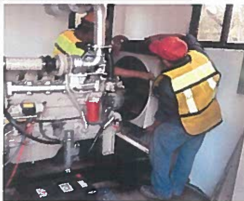
REEMPLAZO DE RADIADOR DETERIORADO POR UN RADIADOR NUEVO, Y SUSTITUCIÓN DE LIQUIDO REFRIGERANTE.
