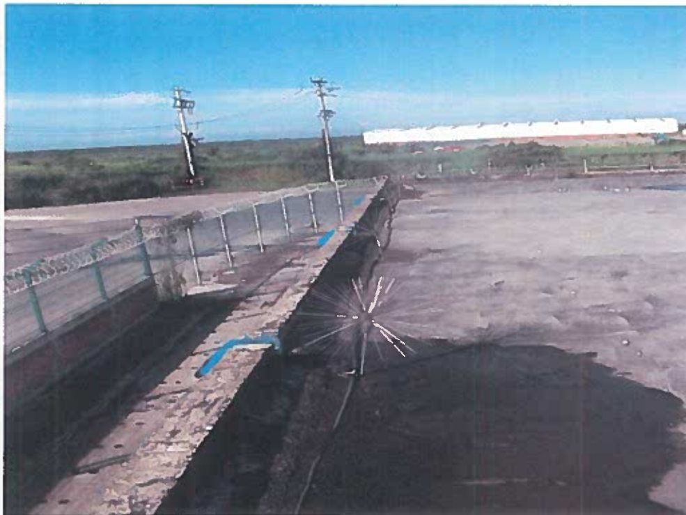
MANTENIMIENTO A SISTEMA PARARRAYOS EN PARTE SUPERIOR DE LOSA EN SUBESTACION PRINCIPAL DE ENLACE DE LA API.
