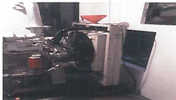
REEMPLAZO DE RADIADOR DETERIORADO POR UN RADIADOR NUEVO, Y SUSTITUCIÓN DE LIQUIDO REFRIGERANTE.
