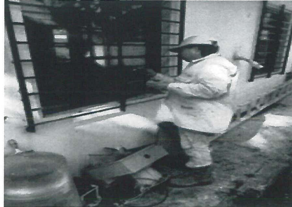
APLICACIÓN DE PINTURA ESMALTE ALQUIDALICO ANTICORROSIVO COLOR NEGRO EN DOS CAPAS SOBRE PROTECCIONES
