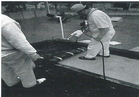
INSTALACIÓN DE IMPERMEABILIZANTE PREFABRICADO
