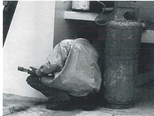
APLICACIÓN DE PINTURA EN MUROS DE LA CASA
