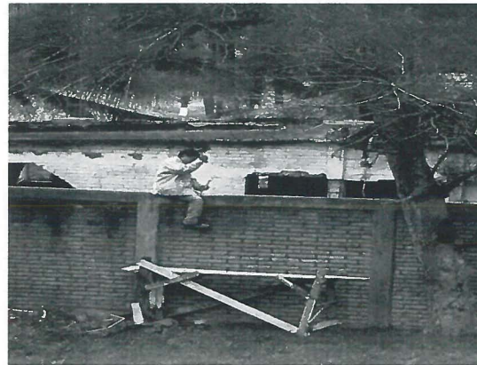
INSTALACIÓN DE CONCERTINA
