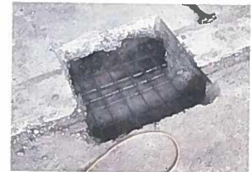
Excavación por medios manuales en área de bodega para alojar estructura de cimentación, con medidas de 0.80m x 0.80m hasta una profundidad de 0.60m de acuerdo a lo indicado en el proyecto. Incluye: traspaleos horizontales y verticales, compactación de la superficie de fondo, retiro del material producto de la excavación hasta el lugar indicado por la supervisión, mano de obra, equipo, herramienta y todo lo necesario para la correcta ejecución del concepto, P.U.O.T.
