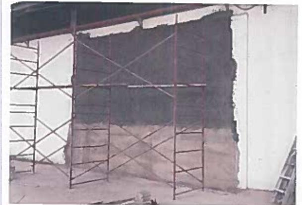
Repellado y aplanado fino en muros de por ambas caras con mortero cemento arena proporción 1:4, incluye: andamios, consumibles, materiales, mano de obra, equipo, herramienta y todo lo necesario para la correcta ejecución del concepto P.U.O.T.
