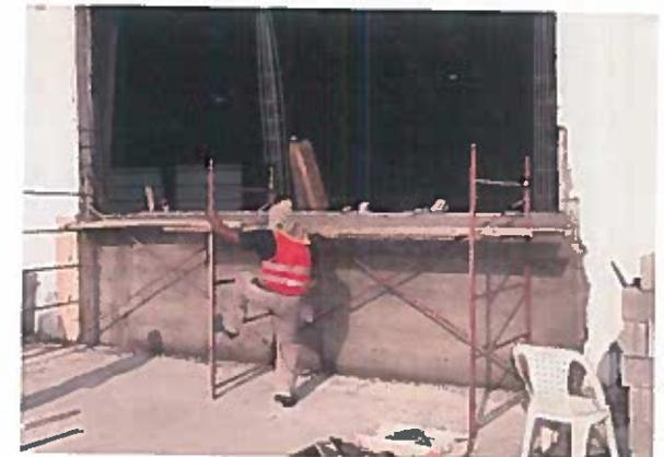
Construcción de muro de contención de 5.85m x 1.60 x 0.30 mts. Hecho a base de concreto f'c=250 kg/cm2, armado con largueros de Varilla de #4 y estribos #3 @ 20cm de acuerdo a lo indicado en proyecto. Incluye: habilitado y colocación de acero de refuerzo, cimbrado, suministro, colocación y vibrado del concreto, descimbrado, consumibles, materiales, mano de obra, equipo, herramienta y todo lo necesario para la correcta ejecución del concepto, P.U.O.T.
