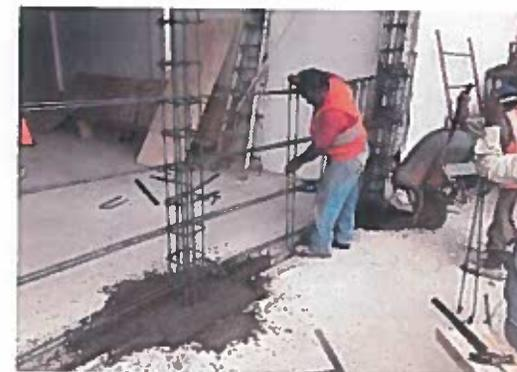
Construcción de zapata aislada con medidas de 0.80 x 0.80 x 0.60 mts. Con concreto f'c=250 kg/cm2, armada con varilla de #3 @ 20 cm en ambos sentidos en parrilla y #4 en dado de acuerdo a lo indicado en el proyecto. Incluye: habilitado y colocación de acero de refuerzo, vaciado y vibrado del concreto, consumibles, materiales, mano de obra, equipo, herramienta y todo lo necesario para la correcta ejecución del concepto, P.U.O.T.
