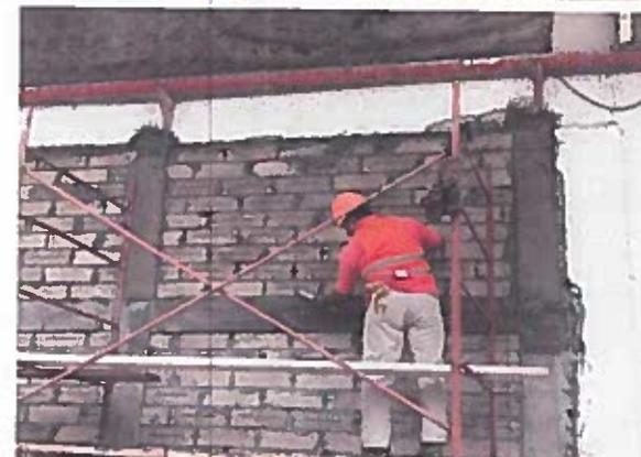
Construcción de muro a base de block macizo de 12x20x40 cm asentado con mortero cemento - arena 1:4 acabado común, juntas de 1.5 cm promedio de acuerdo a lo indicado en proyecto, incluye: fabricación de mortero, preparación del área de trabajo, colocación, alineación, plomeo, cuatrapeo del tabique, desperdicios, consumibles, materiales, mano de obra, equipo, herramienta y todo lo necesario para la correcta ejecución del concepto, P.U.O.T.
