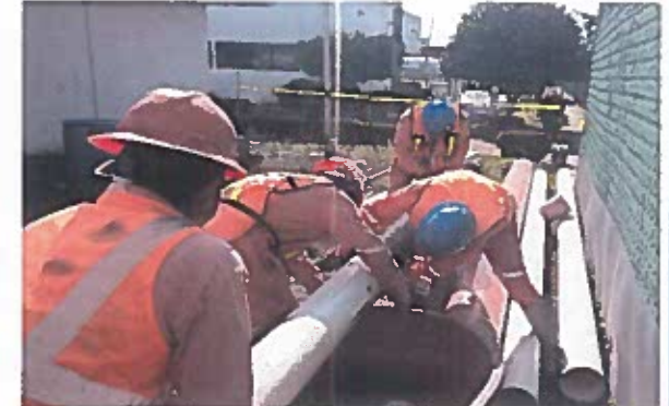
Suministro y colocación de tubería hidráulica ced 40 de 8" de diámetro
