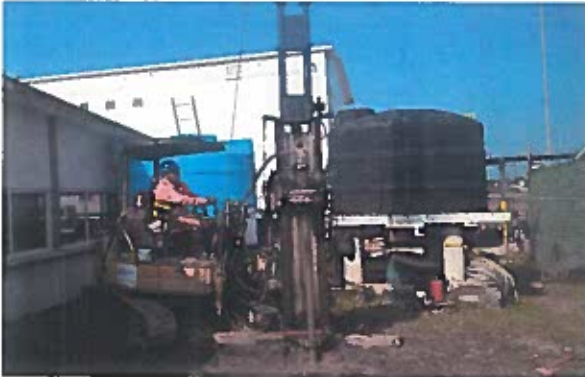
Perforación exploratoria del pozo de 4" de diámetro de 0 a 40 m
