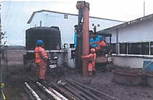
Suministro y colocación de tubería hidráulica ced 40 de 12" de diámetro
