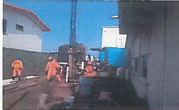
Suministro y colocación de PVC hidráulico de 4" de diámetro
