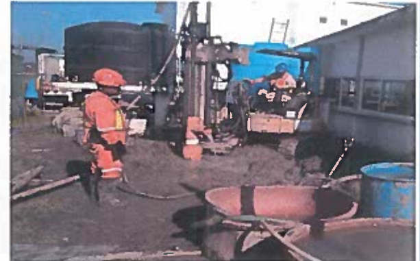
Lavado del pozo para eliminar azolves
