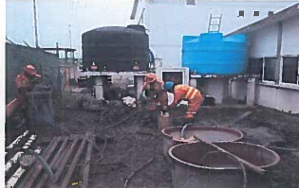
Colocación de grava de cuarzo para filtro de pozo calibre 1/4"-1/8"
