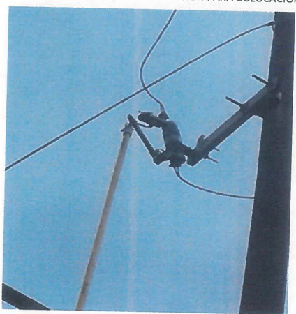
INSTALACION DE CORTACIRCUITO
