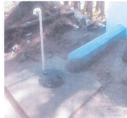
COLOCACION DE TANQUE ROTOPLAS BIODIGESTOR DE 1300 LTS. CON SU LOSA PARA MAYOR SEGURIDAD Y TUBERIA ENCOFRADA CON CONCRETO.
