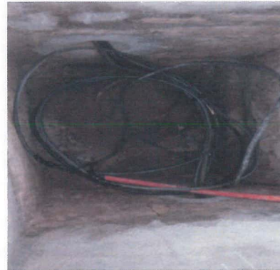
INSTALACION DE CABLE CALIBRE 10 AWG Y CALIBRE 2 PARA ALIMENTACION A CASETA Y BAÑO
