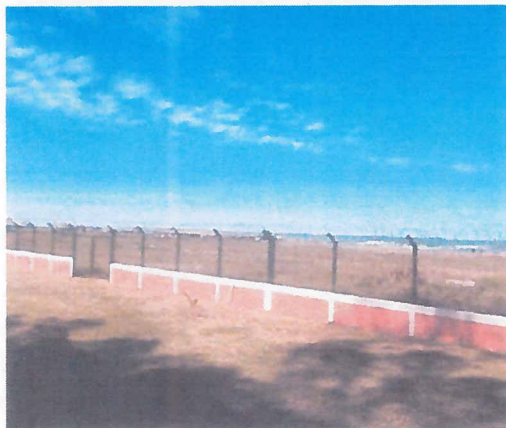
BARDA REHABILITADA CON TOP REPELENTE BASE SOLVENTE EN MUROS DE TABIQUE Y PINTURA VINILICA A CASTILLOS Y CADENAS.
