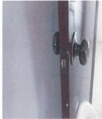
INSTALACION DE NUEVA CERRADURA PARA PUERTA INTERIOR
