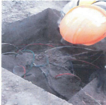
LIMPIEZA DE REGISTROS ELECTRICOS RETIRANDO ARENA.
