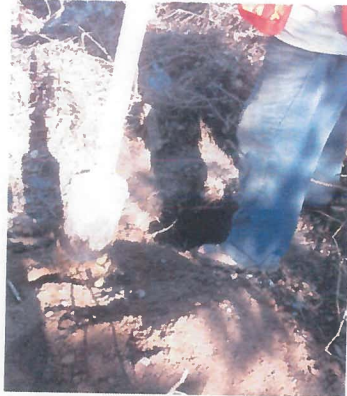
ESCAVACIONES NECESARIAS PARA ALOJAR RETENIDAS.
