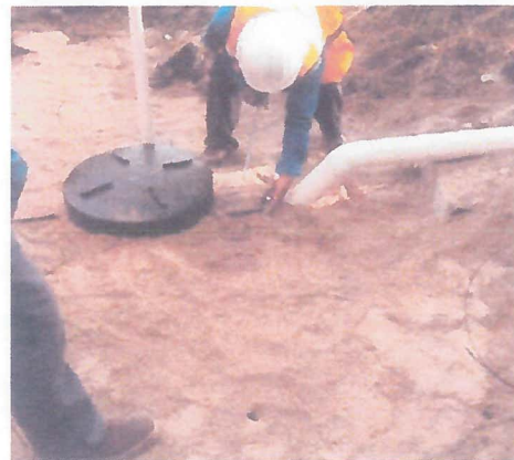
COLOCACION DE TANQUE ROTOPLAS BIODIGESTOR DE 1300 LTS. CON SU LOSA PARA MAYOR SEGURIDAD Y TUBERIA ENCOFRADA CON CONCRETO.
