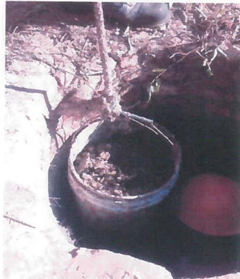
RETIRO DE MATERIAL DE FOSA SEPTICA
