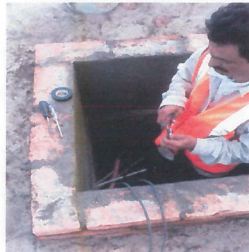
ARREGLO DE CABLES EN REGISTROS ELECTRICOS Y CONSTRUCCION DE ENRASE
