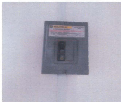
INSTALACION DE CENTRO DE CARGA MOD. QOD2 MCA. SQUARE D. E INTERRUPTOR TERMOMAGNETICO DE UN POLO DE 30 AMP.
