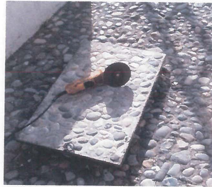
TAPA DE REGISTRO SANIATRIO REHABILITADA PARASU COLOCACION.
