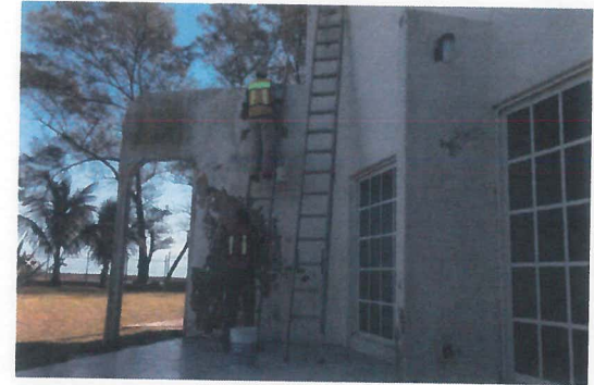
TRABAJOS DE RETIRO DE PINTURA VIEJA PARA RECIBIR LA NUEVA.
