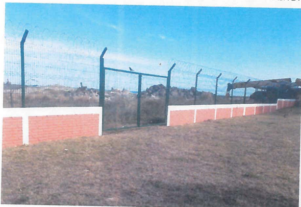
BARDA REHABILITADA EN SU TOTALIDAD CON NUEVA REJA DEACERO, NUEVA CONCERTINA Y ACCESORIOS DE COLOCACION.
