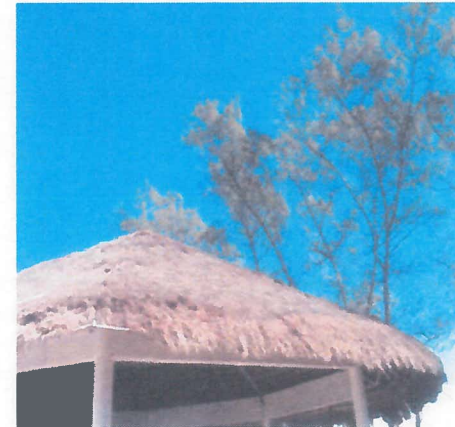
RED DE SEGURIDAD COLOCADA
