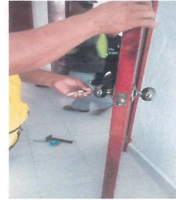
NUEVA CERRADURA INSTALADA
