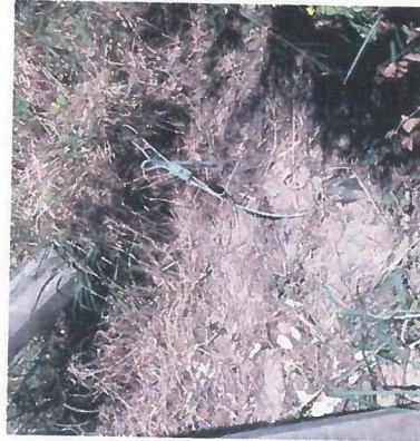
ANCLAJE DE RETENIDA AL TERRENO NATURAL.
