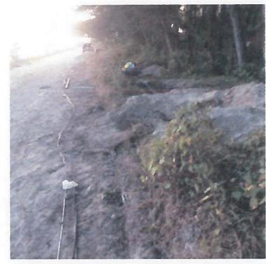
TENDIDO DE CABLES CALIBRE 1/0 AWG Y CALIBRE 2 AWG.
