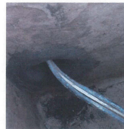
VISTA GENERAL DE LOS CABLES INSTALADOS Y ABOCINADO DE LOS DUCTOS
