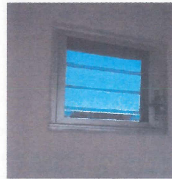
VENTANA EN PARTE TRASERA DE BAÑO CON MEDIDAS DE 0.40 X0.40
