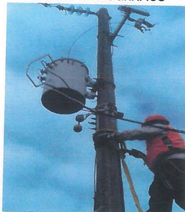
TRABAJOS DE MANTENIMIENTO AL TRANSFORMADOR
