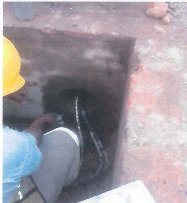
ABOCINADO DE DUCTOS.
