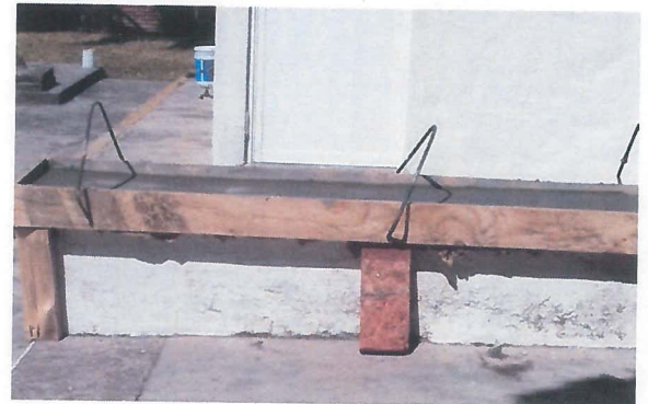
DESCANSOS REPARADOS DE LA PALAPA.
