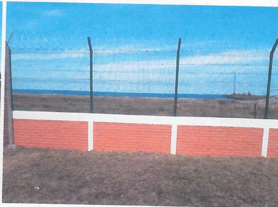
BARDA REHABILITADA EN SU TOTALIDAD CON NUEVA REJA DEACERO, NUEVA CONCERTINA Y ACCESORIOS DE COLOCACION.
