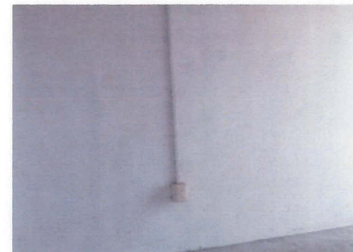
INSTALACION DE CONTACTOS DUPLEX POLARIZADO.
