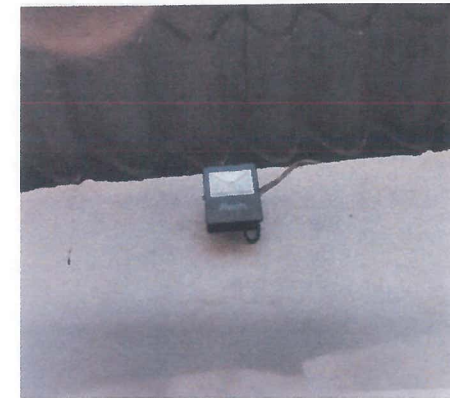
VISTA DE LOS REFLECTORES INSTALADOS.
