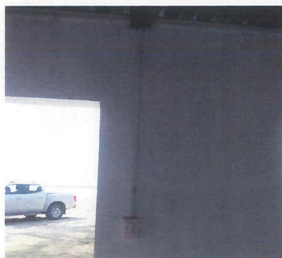
INSTALACION DE APAGADORES EN CASETA DE VIGILANCIA.
