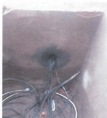
ABOCINADO DE DUCTOS PARA CABLES.
