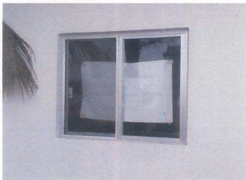
VENTANA DE ALUMINIO CON MEDIDAS DE 1.24 X 1.05 MTS
