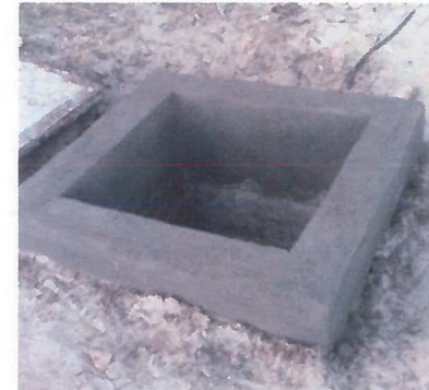
ENRASE DE REGISTROS ELECTRICOS CONSTRUIDOS.
