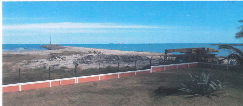
BARDA REHABILITADA CON TOP REPELENTE BASE SOLVENTE EN MUROS DE TABIQUE Y PINTURA VINILICA A CASTILLOS Y CADENAS.
