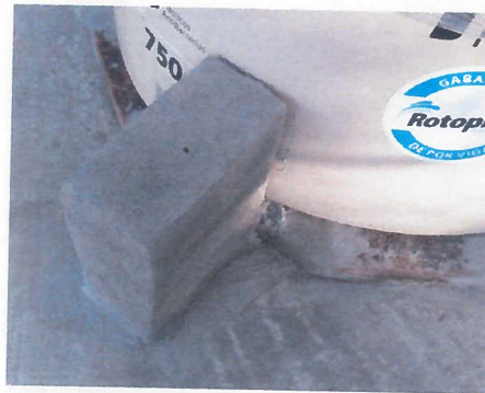
CONSTRUCCION DE RETENIDAS PARA TANQUE A BASE DE BLOCK Y MORTERO.
