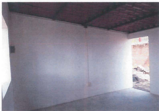
TRABAJOS DE INSTALACION ELECTRICA EN INTERIOR DE CASETA DE CONTROL Y VIGILANCIA DE LA PALAPA.
