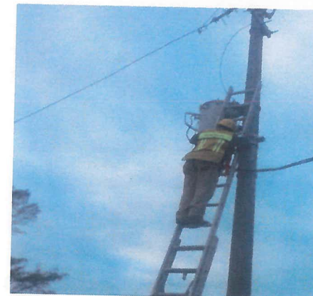
TRABAJOS DE MANTENIMIENTO AL TRANSFORMADOR TIPO POSTE
