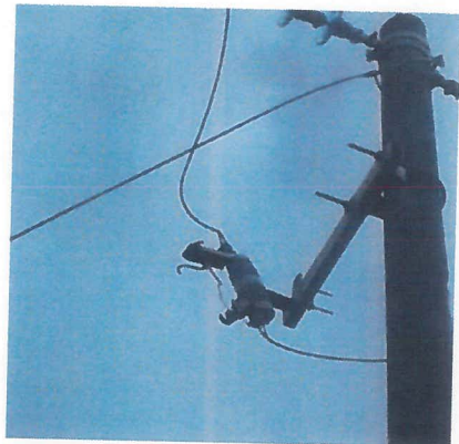
TRABAJOS DE ADECUACION PARA COLOCACION DE PORTAFUSIBLE EN MEDIA TENSION
