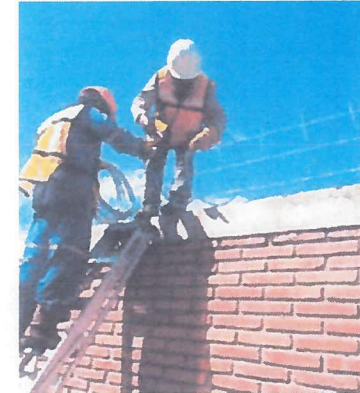
COLOCACION DE NUEVA CONCERTINA HELICOIDAL EN BARDA PERIMETRAL
