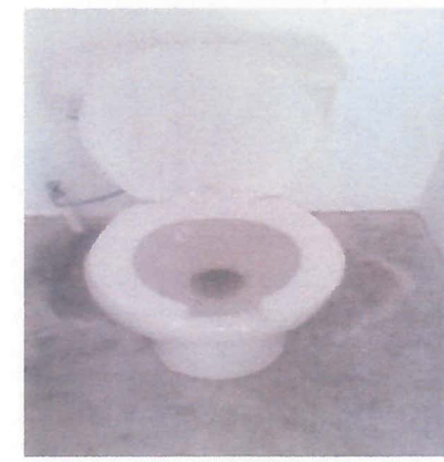
W.C. INSTALADO CORRECTAMENTE.
