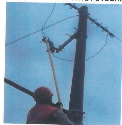
TRABAJOS DE ADECUACION PARA COLOCACION DE PORTAFUSIBLE EN MEDIA TENSION
