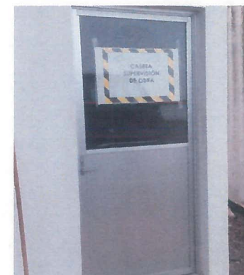
PUERTA INSTALADA DE ALUMINIO DE 0.93 X 2.12 MTS.
