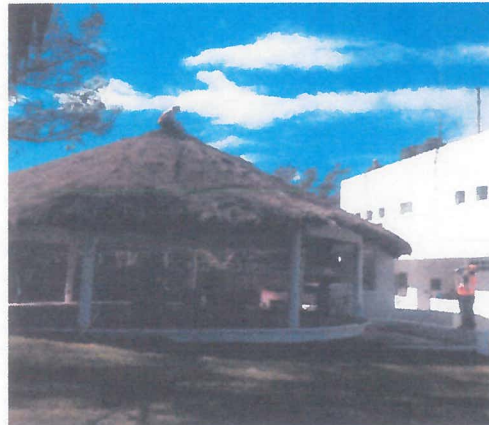
OTRA VISTA DE LA COLOCACION DE RED DE SEGURIDAD.
