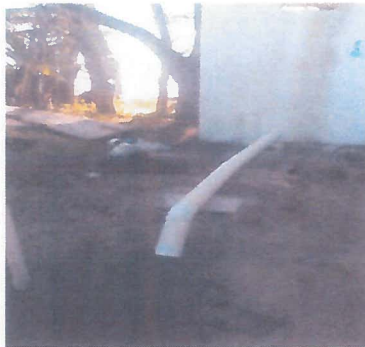
SALIDA SANITARIA PARA LAVABO Y W.C.
