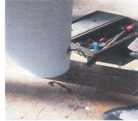
INSTALACION DE CONTACTOS DUPLEX
