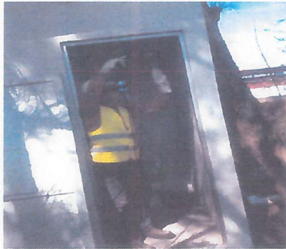
TRABAJOS DE INSTALACION DE PUERTA EN BAÑO
