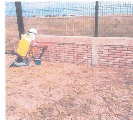
APLICACION DE TOP REPELENTE A MUROS
