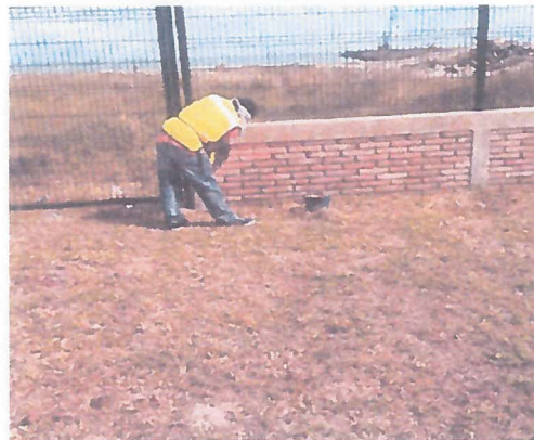
APLICACION DE TOP REPELENTE BASE SOLVENTE EN MUROS DE TABIQUE
