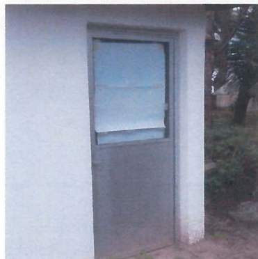
INSTALACION DE PUERTA DE ALUMINIO EN PARTE POSTERIOR A CASETA DE CONTROL Y VIGILANCIA CON MEDIDAS DE 0.84 X 2.00 MTS.
