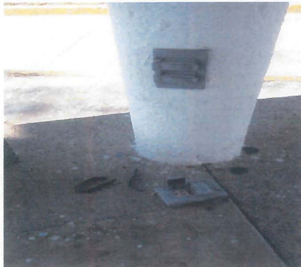
TRABAJOS DE INSTALACION DE CONTACTOS DUPLEX
