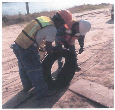
TRABAJS DE DESENRLLADO DE CABLE PARA SER TENDIDO.
