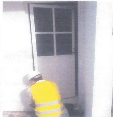
REHABILITACION DE PUERTA DE ALUMINIO CON MEDIDAS DE 0.90 X 2.10 MTS
