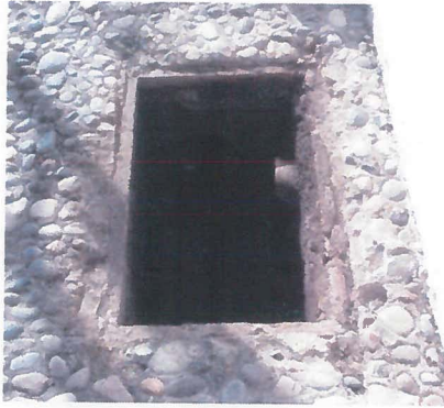
REHABILITACION DE TAPAS DE REGISTROS SANITARIO.
