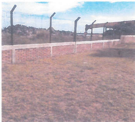
ESTADO ACTUAL DE LA BARDA ANTES DE LA APLICACION DE PINTURA
