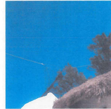
COLOCACION DE RED DE SEGURIDAD EN PALAPA
