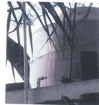
TANQUE ROTOPLAS INSTALADO DE 800 LTS.
