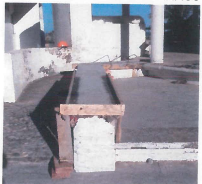
DESCANSOS DE LA PALPA REPARADOS CON CONCRETO HECHO EN OBRA
