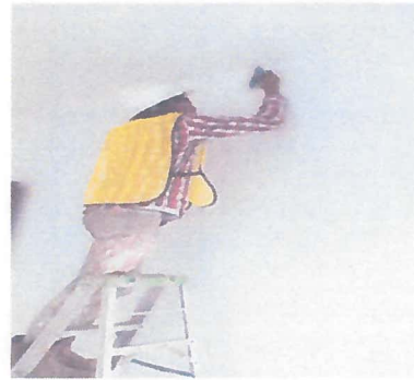
RETIRO DE PINTURA EN MAL ESTADO
