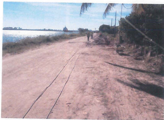
CABLES TENDIDOS PARA SER COLOCADOS DENTRO DE LA CANALIZACION PARA PUESTA EN SERVICIO.
