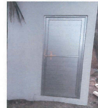
OTRA VISTA DE LA PUERTA DEL BAÑO INSTALADA.
