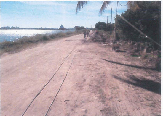
CABLES TENDIDOS PARA SER COLOCADOS DENTRO DE LA CANALIZACION PARA PUESTA EN SERVICIO.
