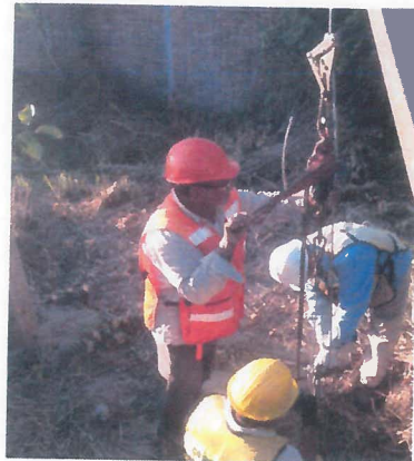
AJUSTE DE RETENIDAS PARA DEJAR TENSADA.
