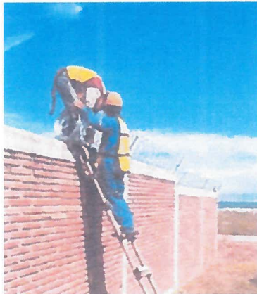
COLOCACION DE NUEVA CONCERTINA HELICOIDAL
