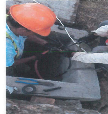
INSTALACION DE CABLE CALIBRE 10 AWG Y CALIBRE 2 PARA ALIMENTACION A CASETA Y BAÑO
