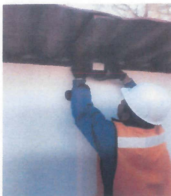
TRABAJOS DE INSTALACION DE REFLECTORES EN CASETA DE VIGILANCIA EN PALAPA.
