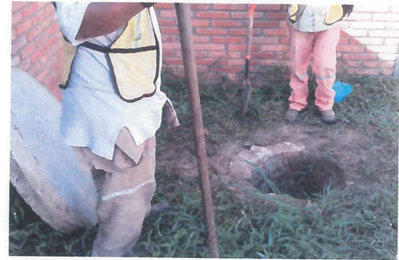
TRABAJOS DE MANTENIMIENTO Y LIMPIEZA A FOSA SEPTICA
