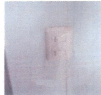
COLOCACION DE CONTACTOS Y APAGADORES EN CASETA Y BAÑO
