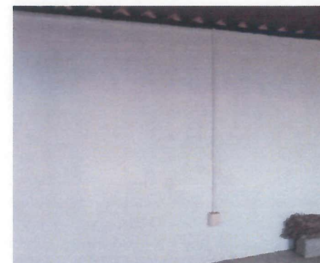
INSTALACION DE CONTACTOS DUPLEX POLARIZADO.
