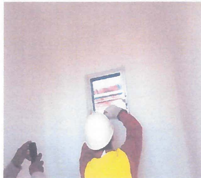
VENTANA EN PARTE TRASERA DE BAÑO CON MEDIDAS DE 0.40 X0.40
