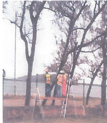
COLOCACION DE CONCERTINA EN BARDA PERIMETRAL
