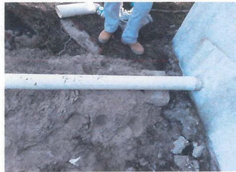
TUBERIA DE PVC DE 4" PARA SALIDA SANITARIA
