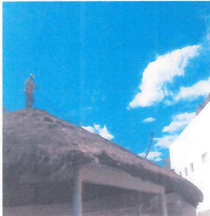
TRABAJOS DE COLOCACION DE RED DE SEGURIDAD
