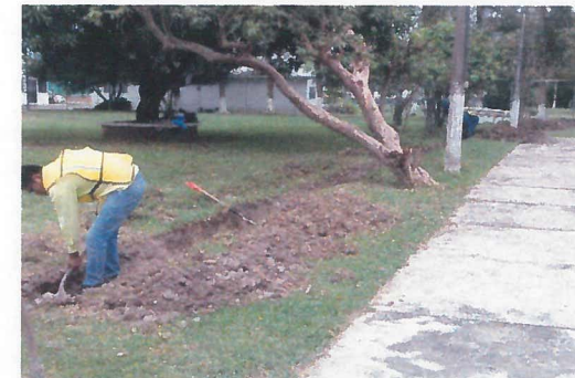
CONTRUCCION DE CANALIZACION PARA FIBRA
