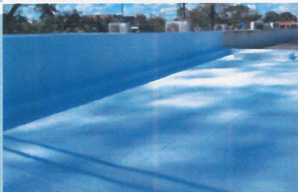
COLOCACION DE IMPERMEABILIZANTE
