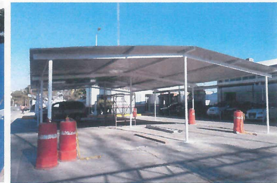
LAMINAS ESTRUCTURALES COLOCADAS AL 100%.
