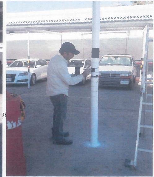
APLICACION DE PINTURA A ESTRUCTURAS DE COBERTIZOS
