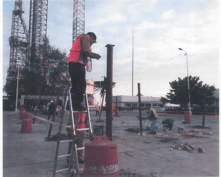
COLOCACION DE POSTES LATERALES
