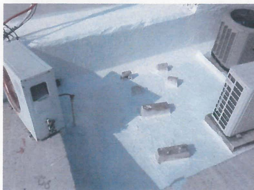
APLICACION DE IMPERMEABILIZANTE TOP TOTAL 10 AÑOS SECADO RAPIDO)
