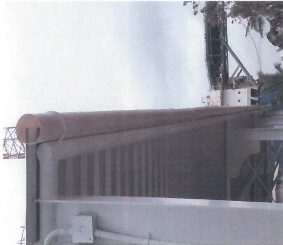
COLOCACION DE TUBO DE PVC DE 4" PARA CAPTACION DE AGUA PLUVIAL EN COBERTIZO EN AREA ADMINISTRATIVAS
