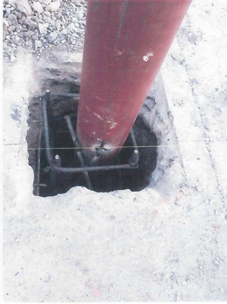
POSTES LATERALES COLOCADOS CON SU ACERO DE REFUERZO
