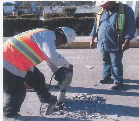
DEMOLICION CON ROMPEDOR PARA ALOJAR POSTES DE ACERO.
