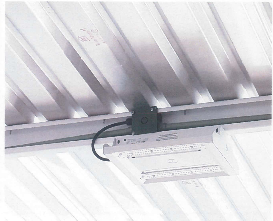
SALIDA ELECTRICA DESDE TABLERO DE DISTRIBUCION A COBERTIZO PARA ILUMINACION CONSTRUIDA CON CABLE THW CALIBRE 8
