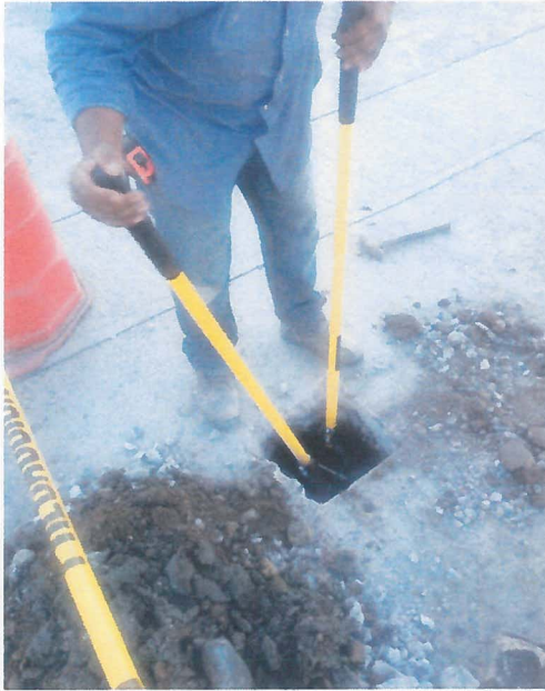
EXCAVACION PARA ALOJAMIENTO DE POSTES DE ACERO.
