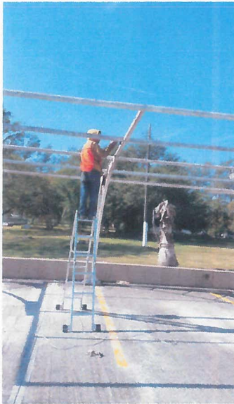
LIMPIEZA Y CARDEO EN ESTRUCTURAS DE COBERTIZO PARA APLICACION DE PINTURA
