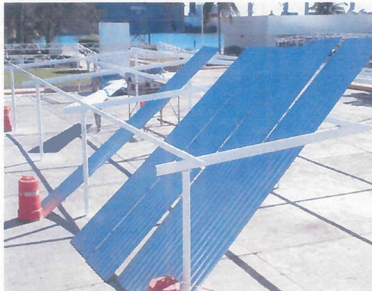
LAMINA ESTRUCTURAL R-101 PARA TECHUMBRE DE COBERTIZO.
