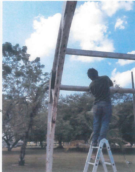
LIMPIEZA Y CARDEO EN ESTRUCTURAS DE COBERTIZO PARA APLICACION DE PINTURA
