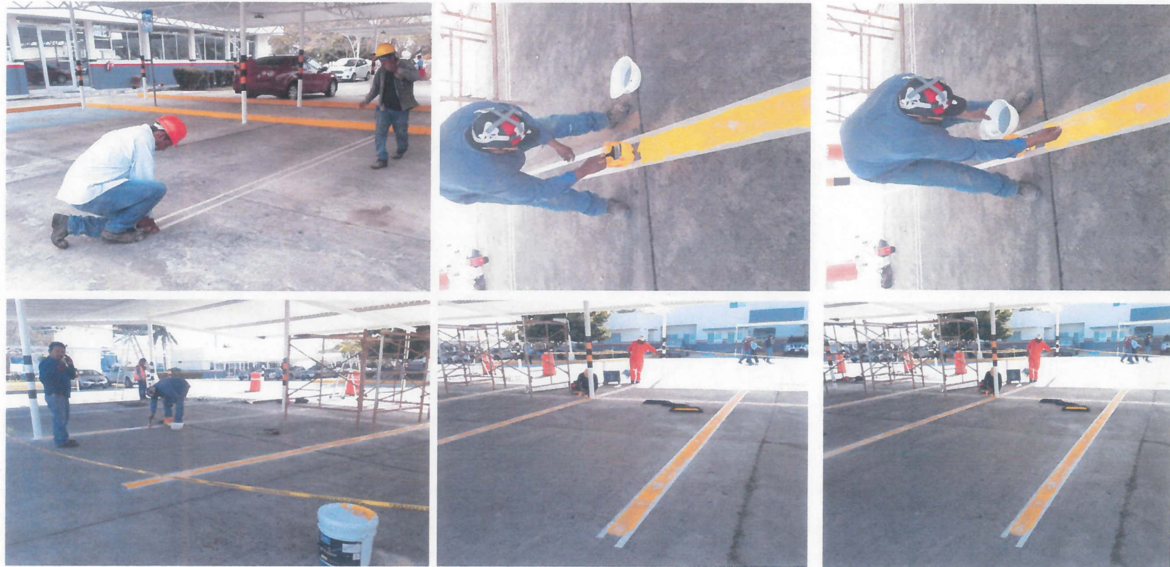
RECUBRIMIENTO DE PAVIMENTO M-1.1 RAYA CENTRAL CONTINUA SENCILLA
