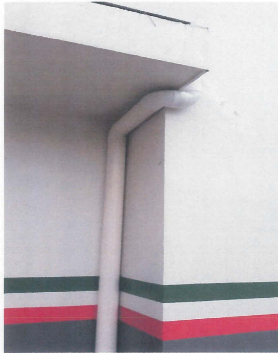
BAJANTES DE DREN PLUVIAL A BASE DE TUBO DE PVC DE 4" DE 3 A 6M DE ALTO
