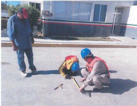
TRAZO DEL AREA DE TRABAJO PARA DELIMITAR EJES DE REFERENCIA Y REALIZAR LAS DEMOLICIONES Y ANCLAJE DE POSTES PARA SOPORTE DE LA ESTRUCTURA DEL COBERTIZO.
