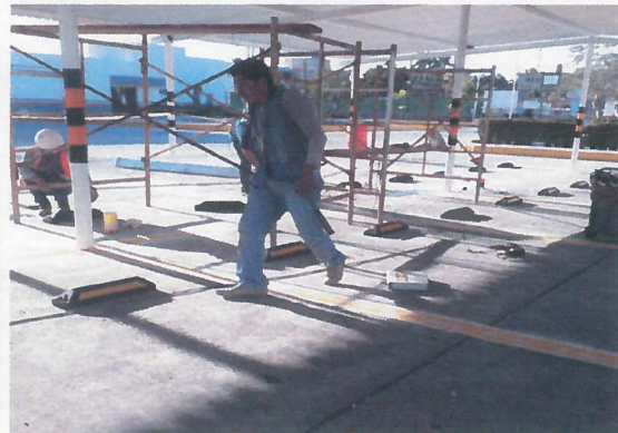
INSTALACION DE TOPE-E55 PARA ESTACIONAMIENTO
