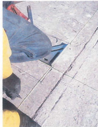
TRAZO DEL AREA DE TRABAJO PARA DELIMITAR EJES DE REFERENCIA Y REALIZAR LAS DEMOLICIONES Y ANCLAJE DE POSTES PARA SOPORTE DE LA ESTRUCTURA DEL COBERTIZO.
