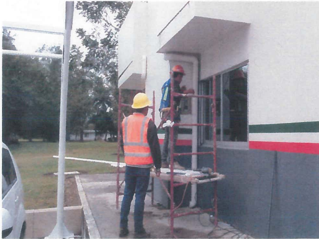
CAJILLO DE PERMABASE PARA OCULTAR TUBERIA DE BAJANTES DE DREN PLUVIAL
