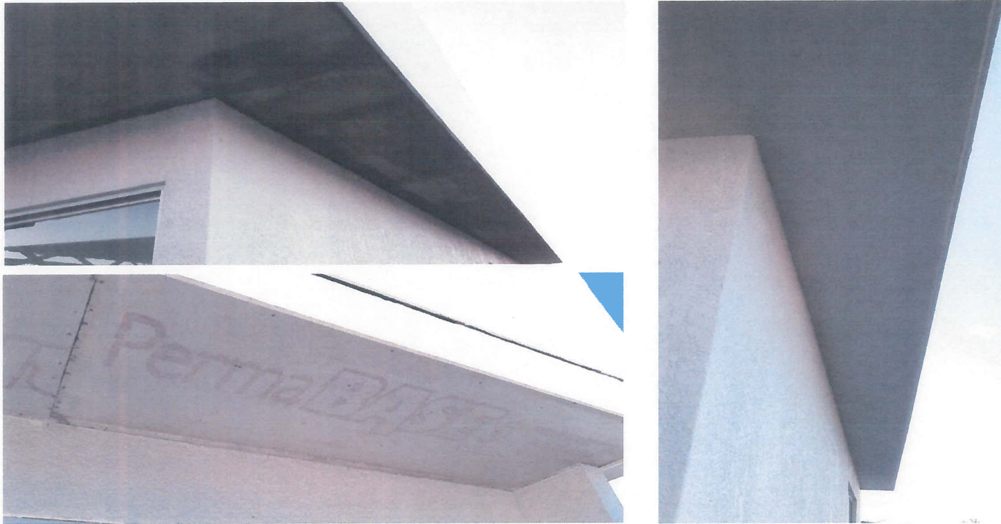
COLOCACION DE FALSO PLAFON DE DUROCK EN AREAS DE CORREDOR DEL EDIFICIO DE FINANZAS.
