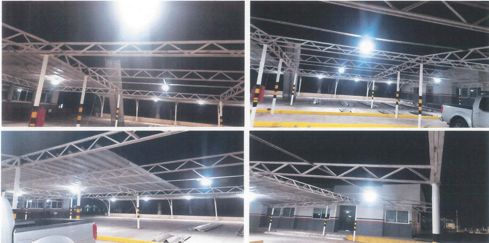
RETIRO DE LAMINA EN TECHUMBRE DE COBERTIZO EXISTENTE EN AREA ADMINISTRATIVA
