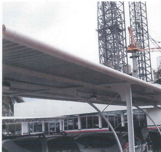
COLOCACION DE TUBO DE PVC DE 4" PARA CAPTACION DE AGUA PLUVIAL EN COBERTIZO EN AREA ADMINISTRATIVAS
