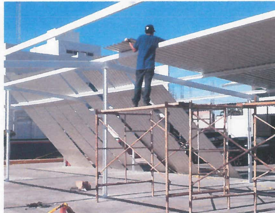
COLOCACION DE LAMINA ESTRUCTURAL.
