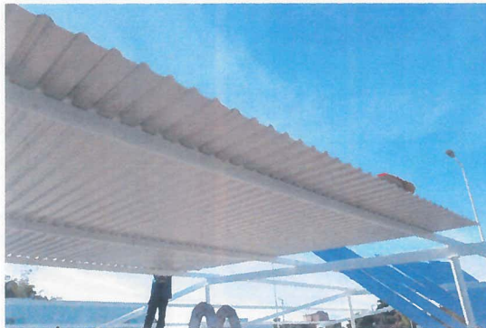
ASEGURAMIENTO DE LAMINA A POLINES DE ESTRUCTURA.
