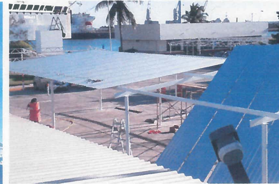
COLOCACION DE LAMINAS ESTRUCTURALES
