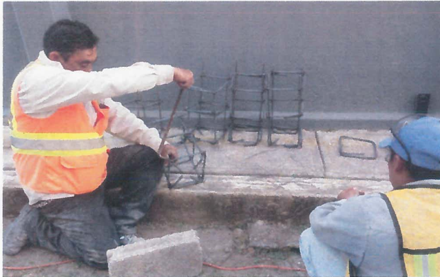
HABILITADO Y ARMADO DE ACERO DE REFUERZO PARA POSTES.
