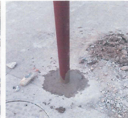
POSTES CENTRALES DE ACERO COLOCADOS.
