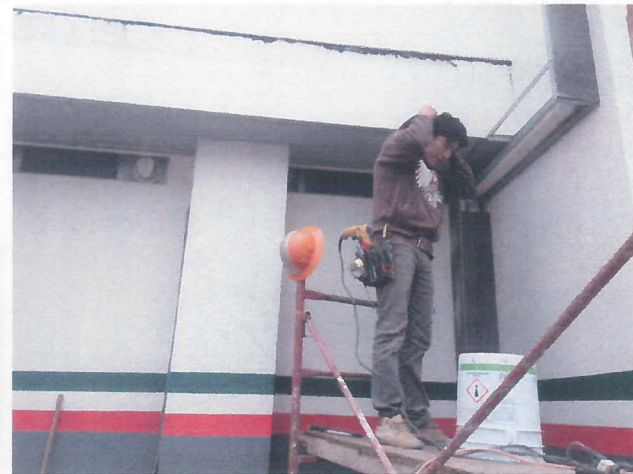
CAJILLO DE PERMABASE PARA OCULTAR TUBERIA DE BAJANTES DE DREN PLUVIAL
