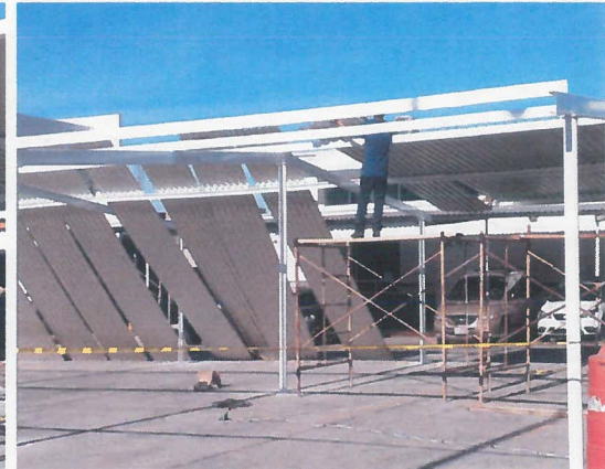
TRABAJOS DE COLOCACION DE LAMINA ESTRUCTURAL.
