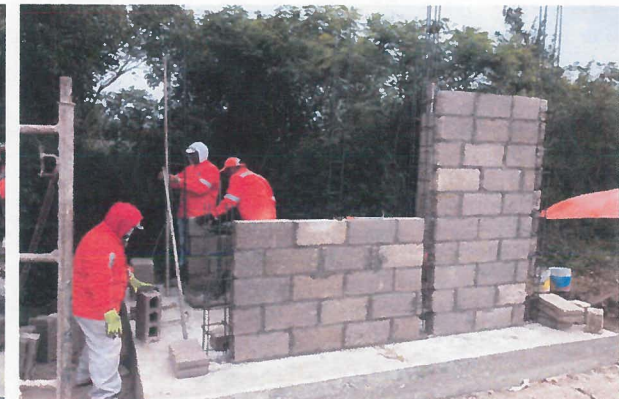
MUROS DE BLOCK MACIZO DE 12X20X40
