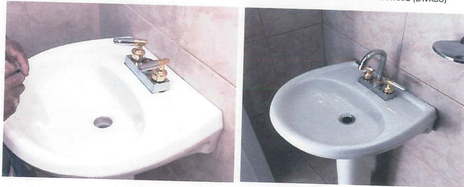
LAVABO COLOCADO CORRECTAMENTE
