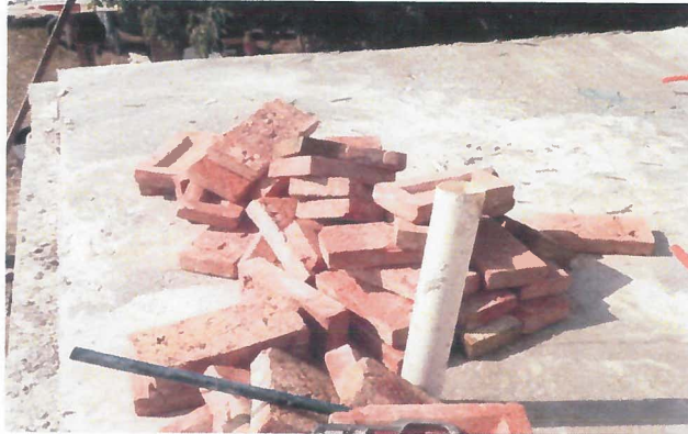
TABIQUE DE 7X14X28 PARA CONSTRUCCION DE PRETEL
