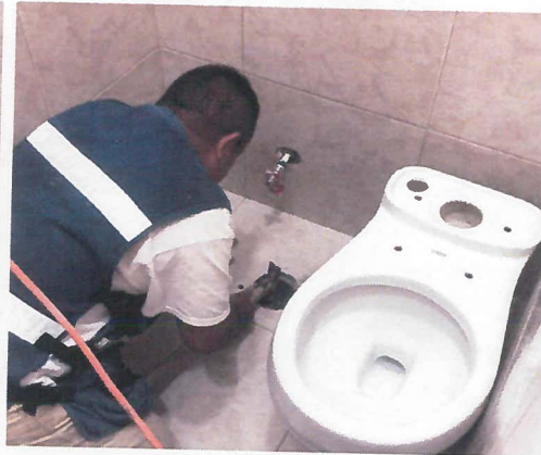
COLOCACION DE MUEBLE SANITARIO (W.C.)
