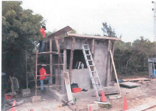
ARMADO DE LOSA CON VARILLAS #3 @20CM EN AMBOS SENTIDOS
