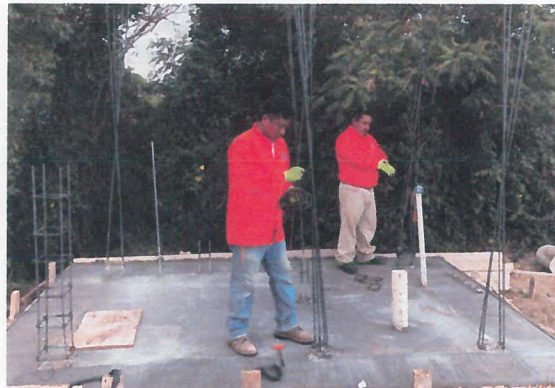
COLOCACION DE ESTRIBOS EN CASTILLOS DE SECCION DE 15 X 15 CM.
