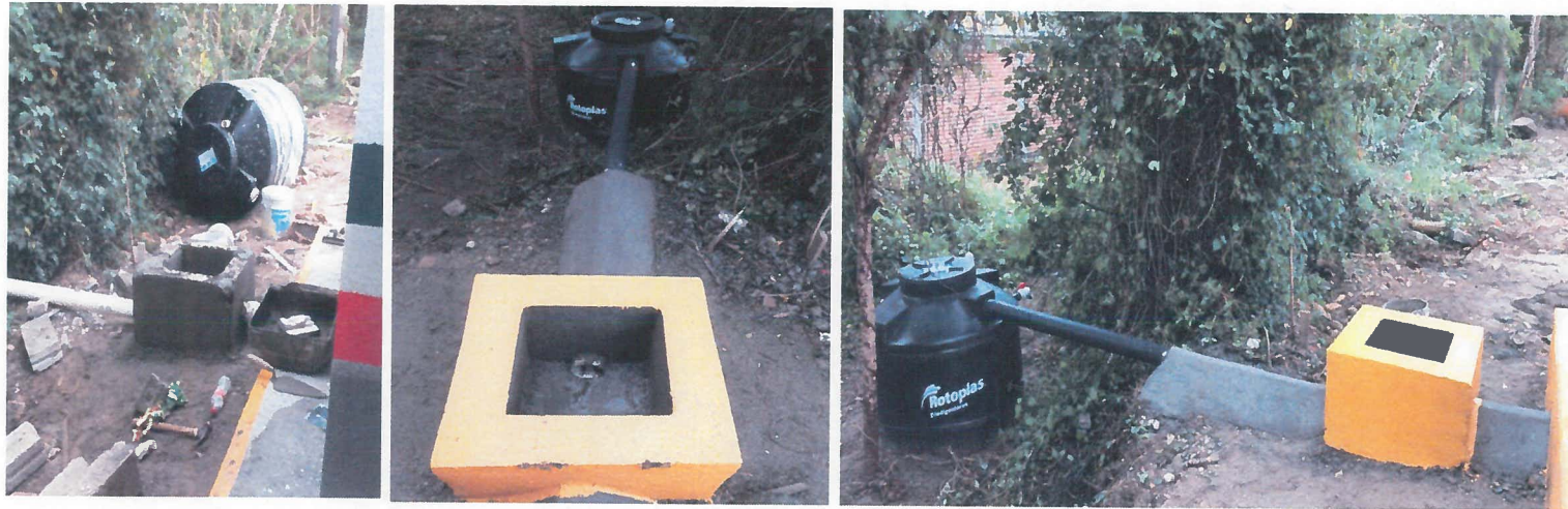
COLOCACION DE ROTOPLAS BIODIGESTOR DE 1300 LTS CON REGISTRO SANITARIO .
