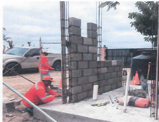
CONSTRUCCION DE MURO DE BLOCK MACIZO
