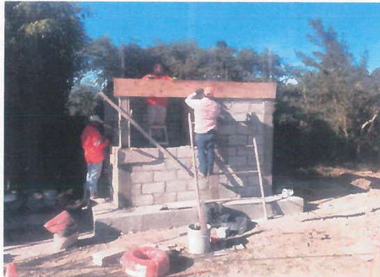
ARMADO CON ACERO DE REFUERZO PARA CADENAS DE CERRAMIENTO
