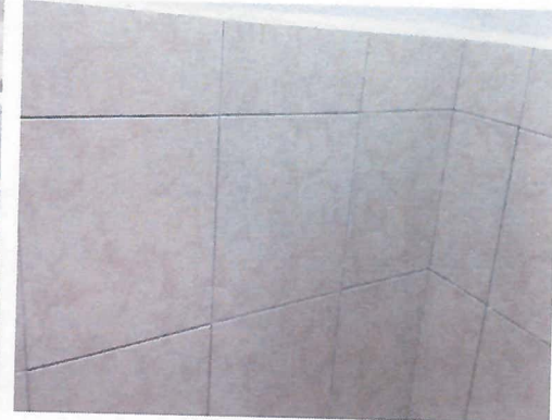
TRABAJO DE RECUBRIMIENTO DE PAREDES Y PISO CON AZULEJO INTERCERAMIC VENATO ARENA DE 20X30 CM ASENTADO CON ADHESIVO NORMAL GRIS
