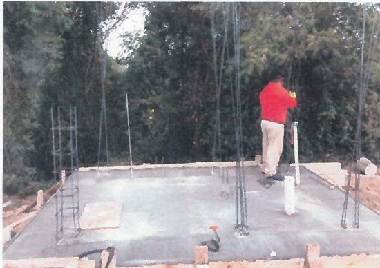
ARMADO DE CASTILLOS CON SECCION DE 15 X 15 CM.
