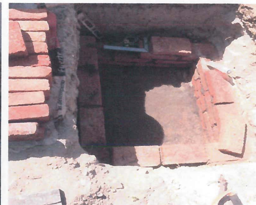
CONSTRUCCION DE REGISTROS ELECTRICOS A BASE DE TABIQUE DE 7X14X28 ASENTADO CON MORTERO CEMENTO ARENA 1:6
