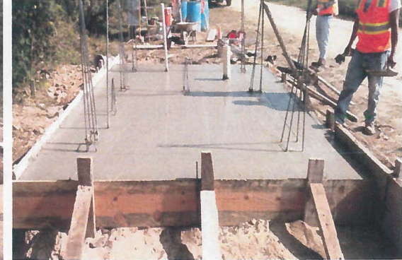
LOSA DE CIMENTACION COLADA.
