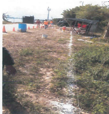
TRAZO DE LINEA PARA CONSTRUCCION DE CANALIZACION PARA ALOJAMIENTO DE 1 TUBO PAD DE 2" PARA ALOJAR 2 CABLES CALIBRE 1/0 AWG Y 1 CABLE CALIBRE 2 AWG
