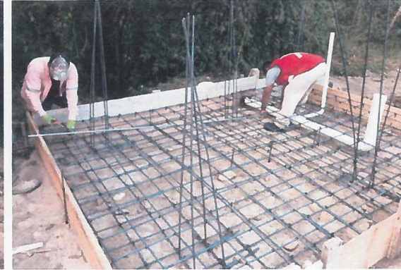
ARMADO DE ACERO DE REFUERZO PARA LOSA DE CIMENTACION
