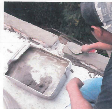
CONSTRUCCION DE BAJANTE DE AGUAS PLUVIALES
