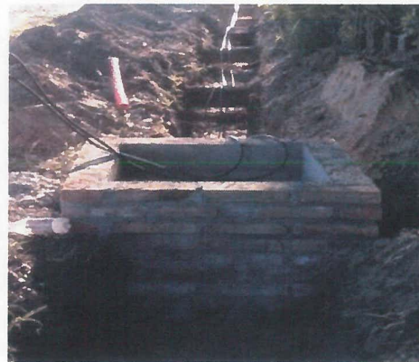
OTRA VISTA DE LA CONSTRUCCION DE REGISTROS ELECTRICOS PARA PASO DE CONDUCCION DE CABLES, CON TAPA DE CONCRETO F'C=200 KG/CM2
