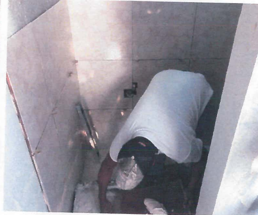
TRABAJO DE RECUBRIMIENTO DE PAREDES Y PISO CON AZULEJO INTERCERAMIC VENATO ARENA DE 20X30 CM ASENTADO CON ADHESIVO NORMAL GRIS
