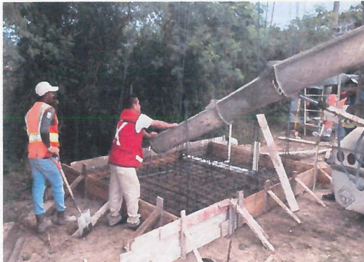
COLADO DE LOSA DE CIMENTACION CON CONCRETO PREMEZCLADO F'c=250 KG/CM2.
