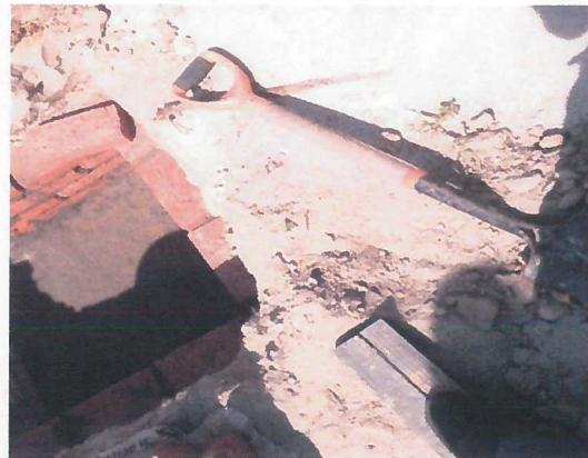
CONSTRUCCION DE REGISTROS ELECTRICOS A BASE DE TABIQUE DE 7X14X28 ASENTADO CON MORTERO CEMENTO ARENA 1:6
