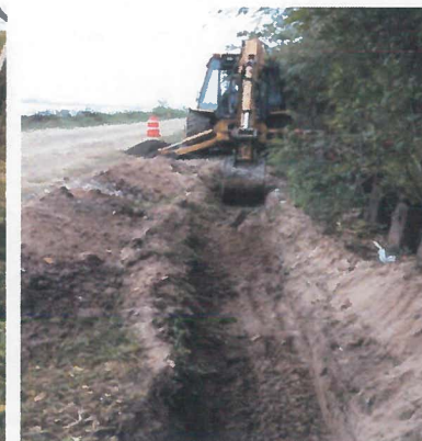
TRAZO DE LINEA PARA CONSTRUCCION DE CANALIZACION PARA ALOJAMIENTO DE 1 TUBO PAD DE 2" PARA ALOJAR 2 CABLES CALIBRE 1/0 AWG Y 1 CABLE CALIBRE 2 AWG
