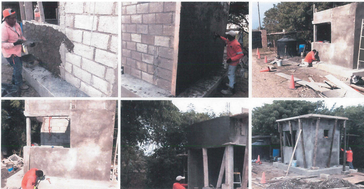
REPELLADO Y APLANADO FINO EN MUROS DE TABIQUE CON MORTERO CEMENTO-ARENA 1:6 A PLOMO Y REGLA
