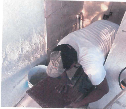
TRABAJO DE RECUBRIMIENTO DE PAREDES Y PISO CON AZULEJO INTERCERAMIC VENATO ARENA DE 20X30 CM ASENTADO CON ADHESIVO NORMAL GRIS
