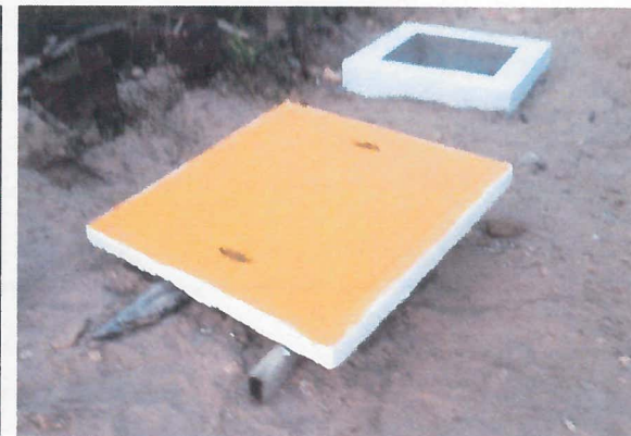
OTRA VISTA DE LA CONSTRUCCION DE REGISTROS ELECTRICOS PARA PASO DE CONDUCCION DE CABLES, CON TAPA DE CONCRETO F'C=200 KG/CM2
