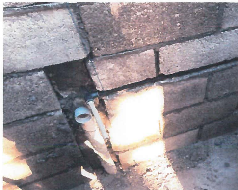
TRABAJOS DE RANURADO EN MUROS DE BLOCK PARA CONSTRUCCION DE SALIDAS HIDRAULICAS DESDE TICACO ROTOPLAS.
