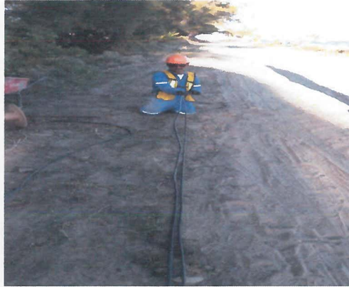
TENDIDO DE CABLE PARA CONDUCCION ELECTRICA A BASE DE DOS CONDUCTORES CALIBRE 1/0 AWG Y UN CABLE DE COBRE CALIBRE 2 AWG.
