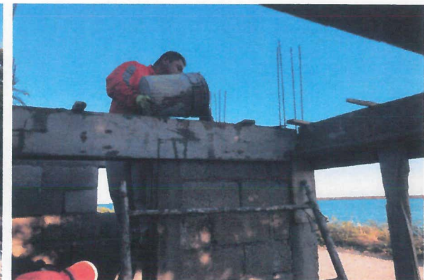
COLADO DE CADENAS DE CERRAMIENTO CON MEDIDAS DE 15X25CM CON CONCRETO F' C=250 KG/CM2
