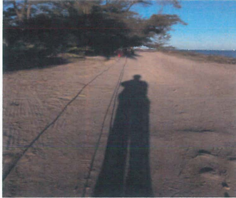
TENDIDO DE CABLE PARA CONDUCCION ELECTRICA A BASE DE DOS CONDUCTORES CALIBRE 1/0 AWG Y UN CABLE DE COBRE CALIBRE 2 AWG.
