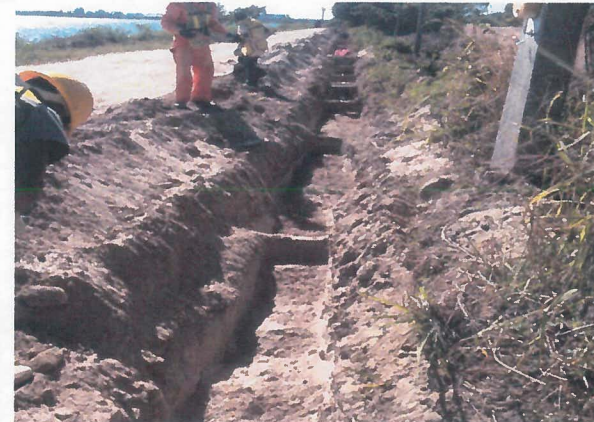
CANALIZACION PARA INSTALACION DE TUBERIA PAD DE 2"
