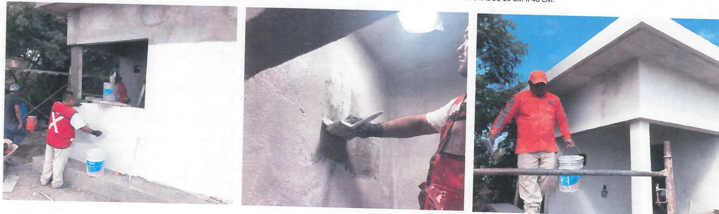
SUMINISTRO Y APLICACION DE PINTURA EN MUROS DE BLOCK
