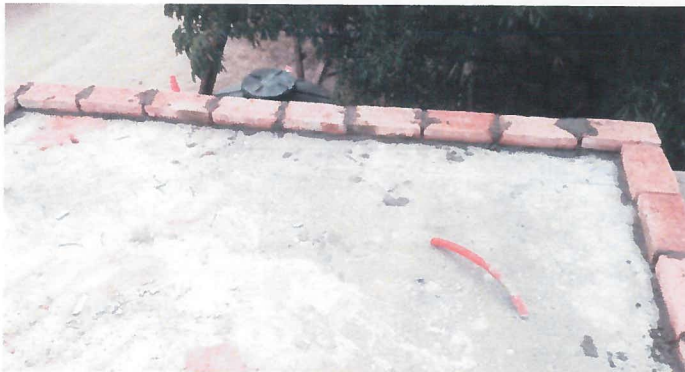
PRETEL CON TABIQUE
