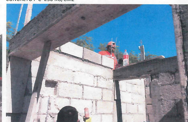
DESCIMBRADO DE CADENAS DE CERRAMIENTO
