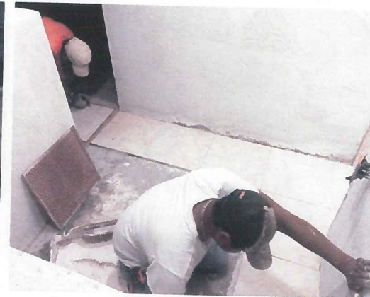
COLOCACION DE PISO EN AREA DE ESTANCIA.
