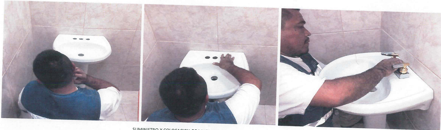
SUMINISTRO Y COLOCACION DE MUEBLE SANITARIO (LAVABO)
