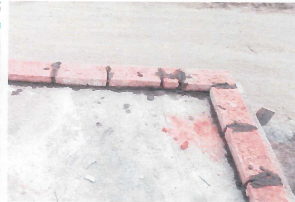
CONSTRUCCION DE PRETEL EN TODO EL PERIMETRO DE LA LOSA
