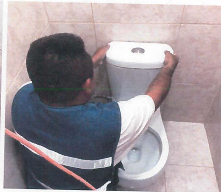
MUEBLE SANITARIO COLOCADO.
