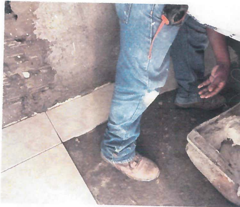
COLOCACION DE PISO DE LOSETA CREMA MARFIL NATURAL DE 40 X 40 CM DE INTERCERAMIC ASENTADO CON ADHESIVO NORMAL GRIS.
