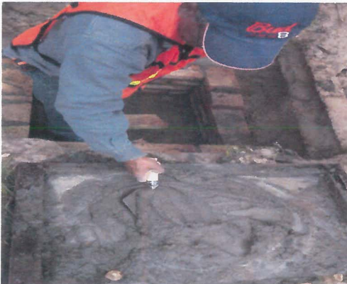
OTRA VISTA DE LA CONSTRUCCION DE REGISTROS ELECTRICOS PARA PASO DE CONDUCCION DE CABLES, CON TAPA DE CONCRETO F'C=200 KG/CM2
