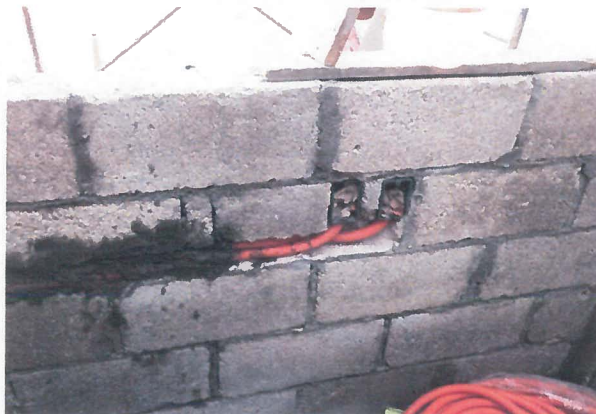
SALIDA ELECTRICA PARA CONTACTO DUPLEX DE CORRIENTE NORMAL.
