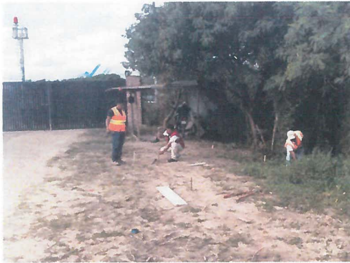
TRABAJOS DE TRAZO Y NIVELACION PARA CONSTRUCCION DE CASETA
