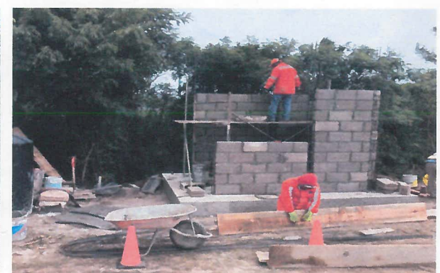
MUROS DE BLOCK MACIZO DE 12X20X40
