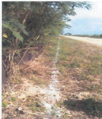
TRAZO DE LINEA PARA CONSTRUCCION DE CANALIZACION PARA ALOJAMIENTO DE 1 TUBO PAD DE 2" PARA ALOJAR 2 CABLES CALIBRE 1/0 AWG Y 1 CABLE CALIBRE 2 AWG
