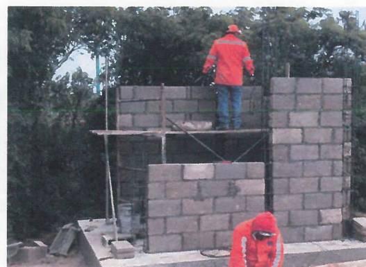
MUROS DE BLOCK MACIZO DE 12X20X40CM PARA CASETA DE CONTROL Y VIGILANCIA DE LA ESCOLLERA NORTE
