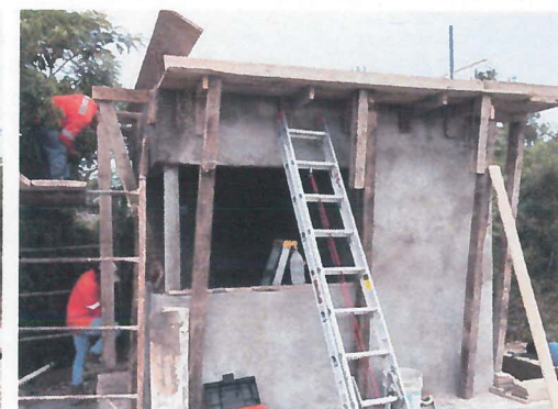
CIMBRADO DE LOSA
