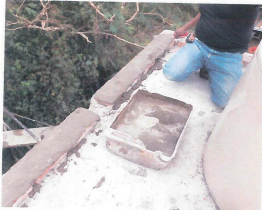
CONSTRUCCION DE CHAFLANES
