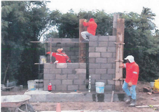
COLADO DE CASTILLOS CON CONCRETO HECHO EN OBRA F'c=250 KG/CM2
