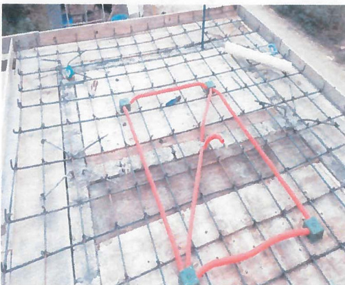
REGISTRO ELECTRICO CON MEDIDAS DE 0.60 X 0.60M MEDIDAS EXTERIORES.
