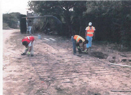
HABILITADO Y ARMADO DE ACERO DE REFUERZO PARA LOSA DE CIMENTACION DE CASETA DE VIGILANCIA
