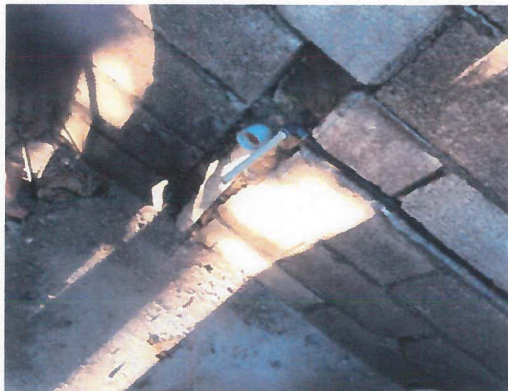
TRABAJOS DE RANURADO EN MUROS DE BLOCK PARA CONSTRUCCION DE SALIDAS HIDRAULICAS DESDE TICACO ROTOPLAS.
