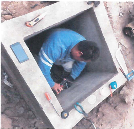
REGISTRO ELECTRICO CON MEDIDAS DE 0.60 X 0.60M MEDIDAS EXTERIORES.
