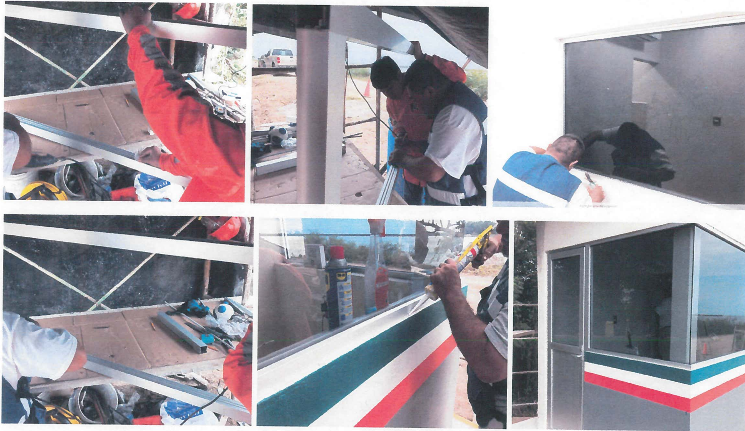
FABRICACION Y COLOCACION DE VENTANALES FIJOS A BASE DE ALUMINIO ANODIZADO NATURAL PULIDO SERIE 3 Y CRISTAL TINTEX DE 9 MM A HUESO CON MEDIDAS DE 1.70X1.00 MTS. Y 1.15X1.00 MTS.
