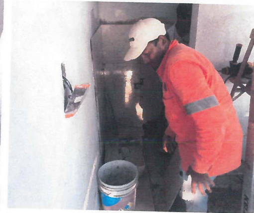
TRABAJO DE RECUBRIMIENTO DE PAREDES Y PISO CON AZULEJO INTERCERAMIC VENATO ARENA DE 20X30 CM ASENTADO CON ADHESIVO NORMAL GRIS
