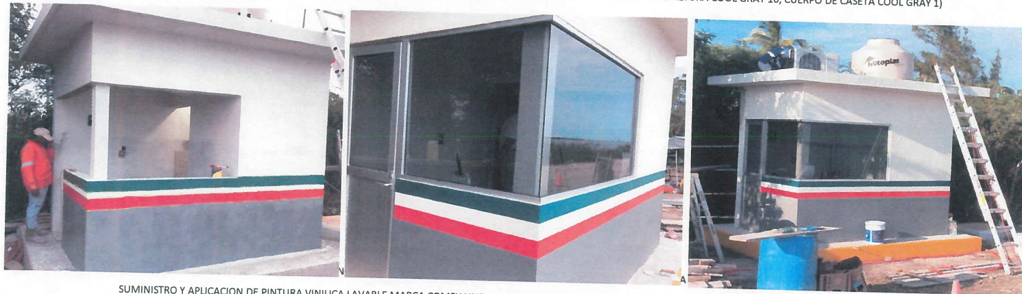
SUMINISTRO Y APLICACION DE PINTURA VINILICA LAVABLE MARCA COMEX LINEA VINIMEX APLICADA EN FRANJAS DE 10CM DE ANCHO (PANTONE 200C Y PANTONE256C)
