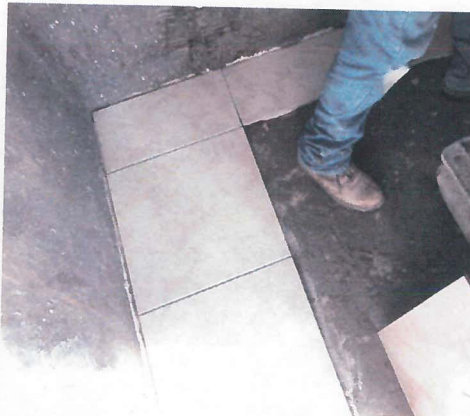
COLOCACION DE PISO DE LOSETA CREMA MARFIL NATURAL DE 40 X 40 CM DE INTERCERAMIC ASENTADO CON ADHESIVO NORMAL GRIS.
