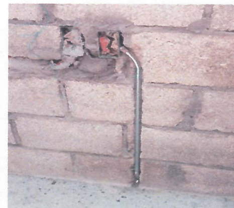
SALIDA ELECTRICA PARA CONTACTO DUPLEX DE CORRIENTE NORMAL.
