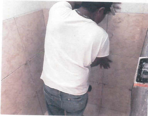
SEGUIMIENTO EN LA COLOCACION DE AZULEJO EN AREA DE BAÑO Y VISTA DE COMO QUEDO TERMINADO EN SU TOTALIDAD
