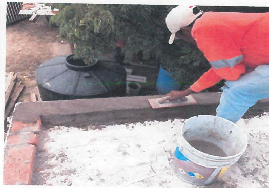
VISTA DE CHAFALNES EN TODO EL PERIMETRO DE LA LOSA
