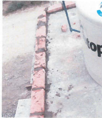
PRETEL A BASE DE LADRILLO
