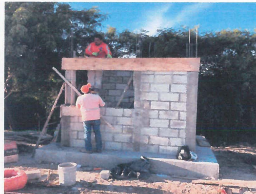
CIMBRADO DE CADENAS DE CERRAMIENTO
