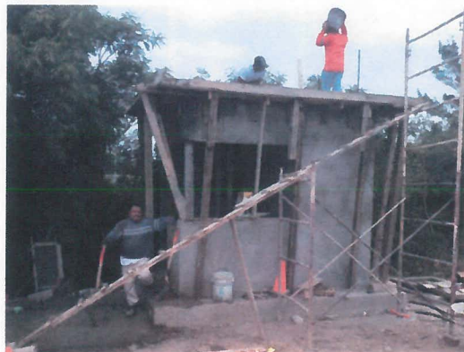
COLADO DE LOSA CON CONCRETO F'c=250 KG/CM2 DE 10 CM ESPESOR
