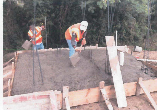
ACOMODO DE CONCRETO PREMEZCLADO EN LOSA DE CIMENTACION
