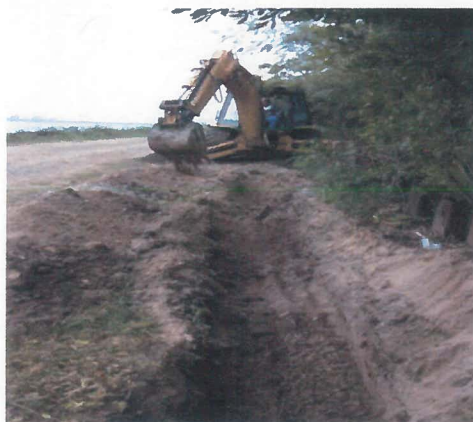
TRABAJOS DE EXCAVACION PARA CANALIZACION
