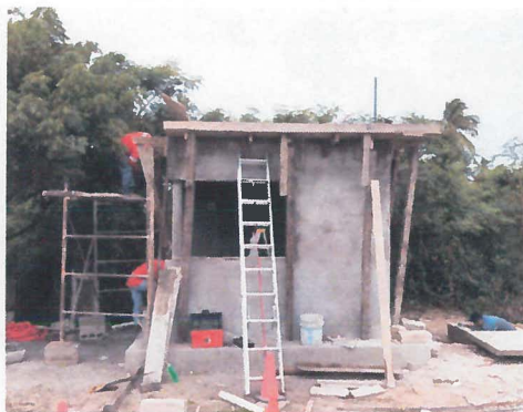
TRABAJOS DE CIMBRADO PARA COLADO DE LOSA
