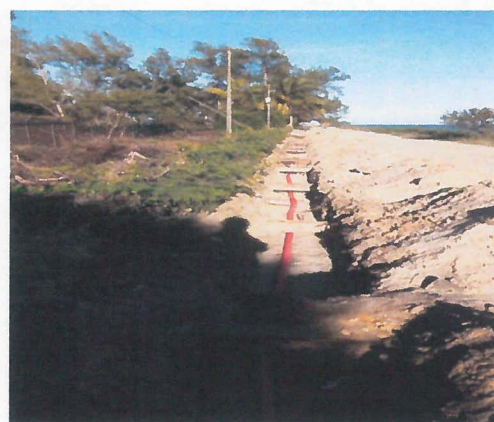
INSTALACION DE TUBERIA DE 2" DE DIAMETRO
