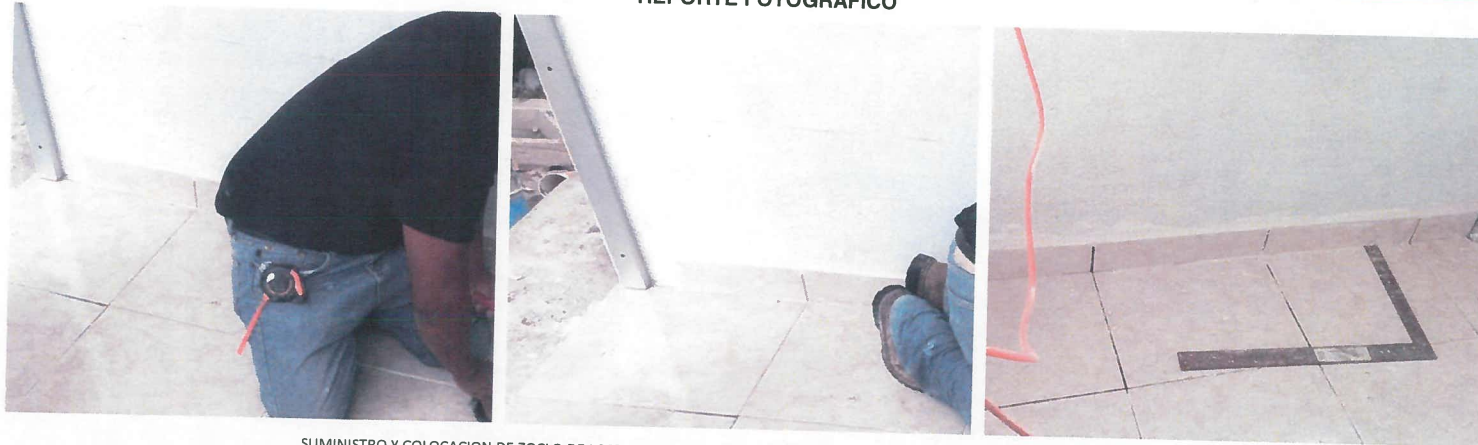
SUMINISTRO Y COLOCACION DE ZOCLO DE LOSETA CERAMICA INTERCERAMIC CREMA MARFIL NATURAL DE 10 CM X 40 CM.
