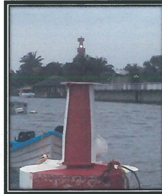
Traslado e instalación de la boya auxiliar de señalamiento para enfilación del segundo cambio de rumbo en el canal interior de navegación, una vez fijada se le instalo la linterna
