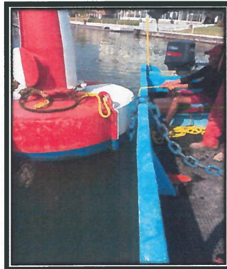
Traslado e instalación de la boya auxiliar de señalamiento para enfilación del segundo cambio de rumbo en el canal interior de navegación, una vez fijada se le instalo la linterna
