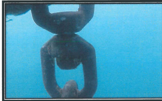
Revisión y limpieza de cadena de anclaje y grillete de la boya No. 1 del Canal de Navegación,
