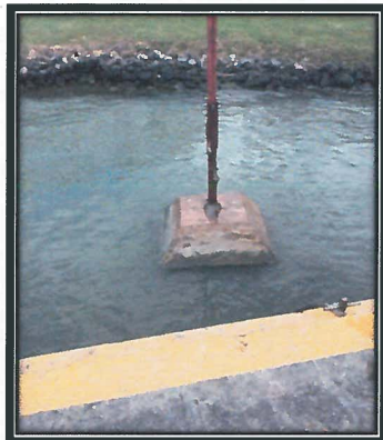
Con ayuda de una grúa tipo Hiabb y de una lancha fuera de borda se realiza el traslado de los muertos al sitio indicado en el proyecto.
