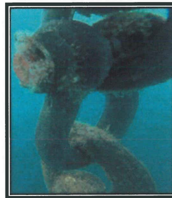
Mantenimiento a boya de recalada que indica el área de fondeo, ubicada en el cadenamamiento -5+100, los trabajos consistieron en la limpieza y revisión de cadena de anclaje, cambio de grillete de 1 1/4" de unión entre cadena y muerto de anclaje.
