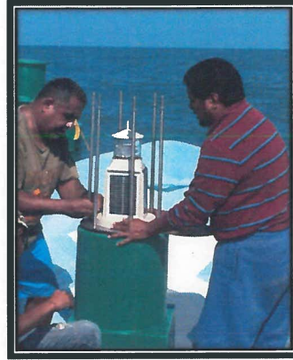
Instalación de canastillas de protección en boya No. 1 del Canal Exterior de Navegación. Instalación de canastillas de protección en boya No. 2 del Canal Exterior de Navegación.
