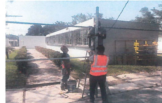
COLOCACION DE POSTES SUPERIORES
