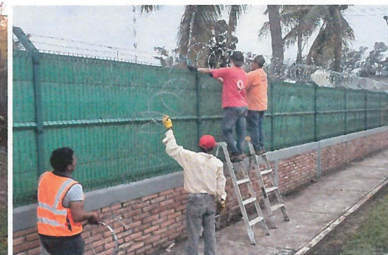
COLOCACION DE CONCERTINA
