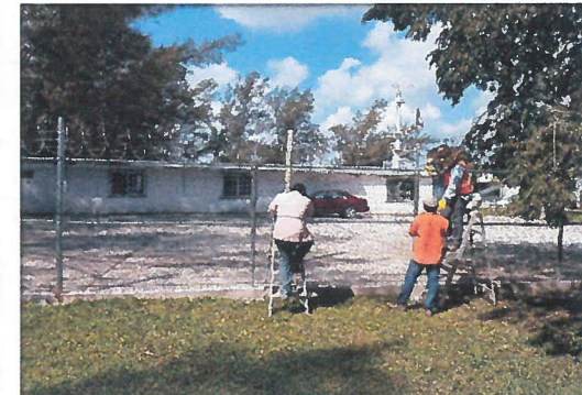
COLOCACION DE CONCERTINA HELICOIDAL
