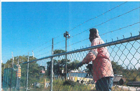
COLOCACION DE ALAMBRE DE PUAS
