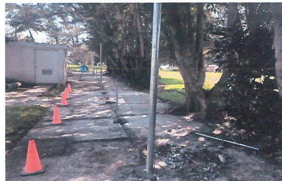
EXCAVACIONES PARA CIMENTACION
