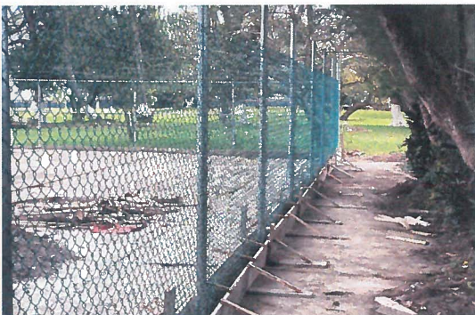
CIMBRADO Y COLADO DE DALA
