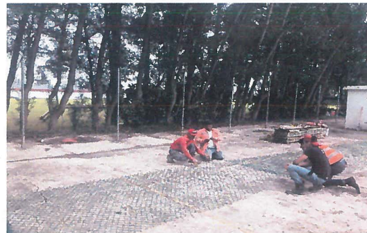
PREPARACION DE LA MALLA CICLONICA
