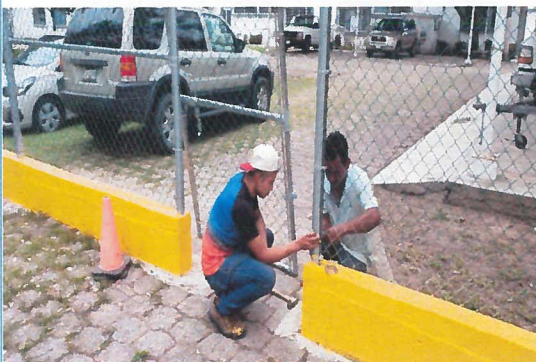
COLOCACION DE PORTON DE MALLA
