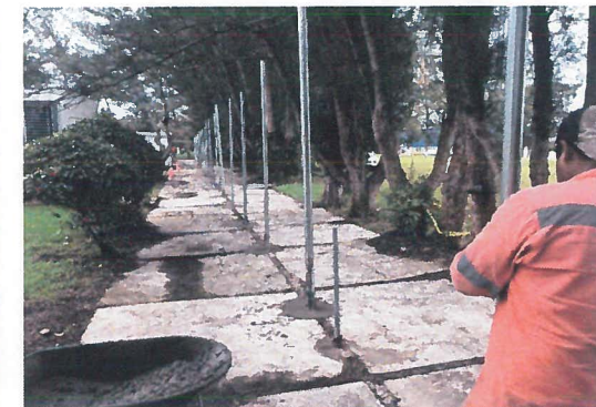
COLOCACION DE POSTES
