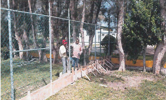
CIMBRADO Y COLADO DE DALA
