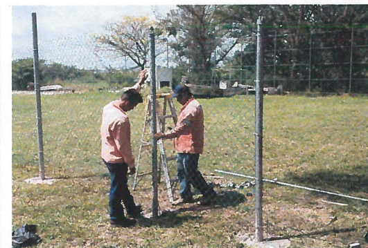
COLOCACION DE POSTES Y MALLA
