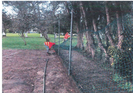
RETIRO DE MALLA CICLONICA
