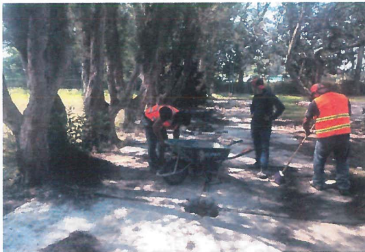
EXCAVACION PARA DADO
