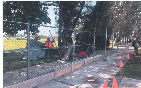
CIMBRADO Y COLADO DE DALA
