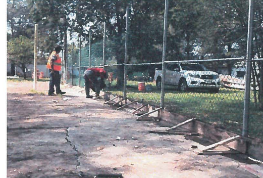
CIMBRADO Y COLADO DE DALA
