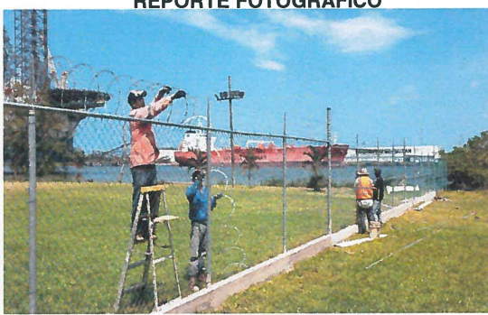
COLOCACION DE CONCERTINA
