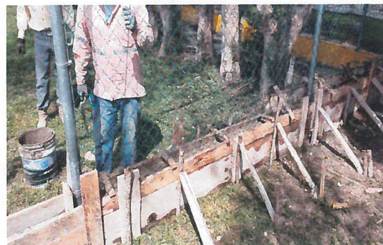
CIMBRADO Y COLADO DE DALA
