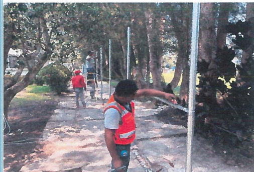
NIVELACION DE POSTES INTERMEDIOS
