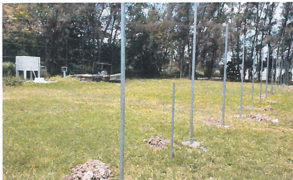
COLOCACION DE POSTES
