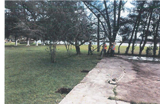
EXCAVACION PARA DADO
