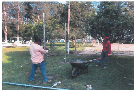
COLADO DE DADO DE CIMENTACION
