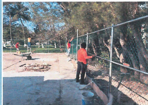
COLOCACION DE MALLA
