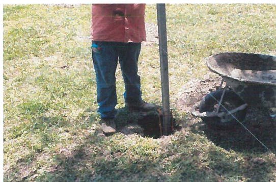
EXCAVACION PARA DADO
