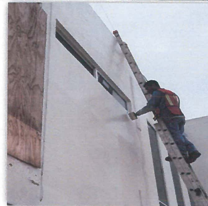
Aplicación de pintura vinil-acrílica
