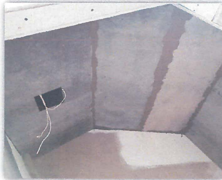
salidas electricas para luminarias
