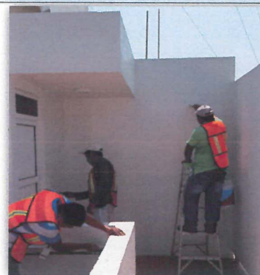
aplicación de pintura en muros exteriores
