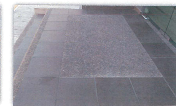
Firme de concreto
