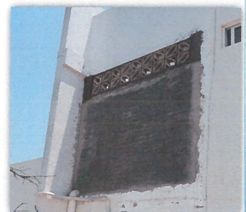
rehabilitacion de muro a base de tabique, y aplanado en muros.
