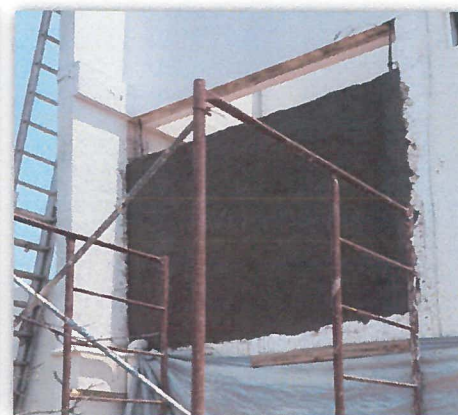
rehabilitacion de muro a base de tabique, y aplanado en muros.
