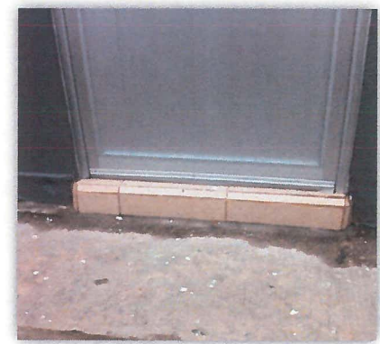
colocación de guardapolvo
