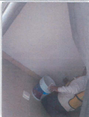
Aplicación de Recubrimiento de pasta en muros
