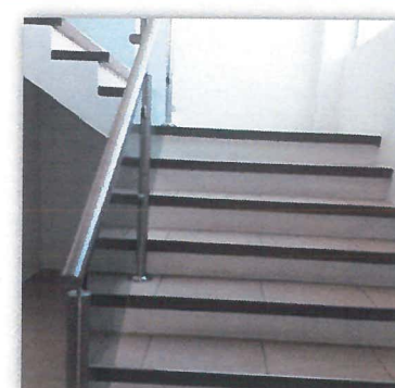
Forrado de escalera
