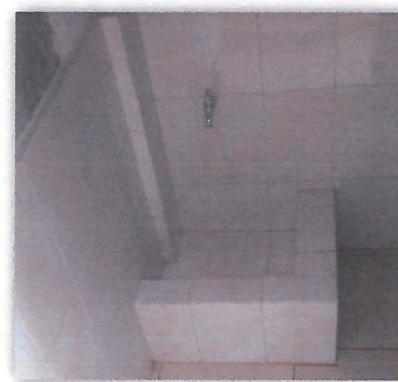
Instalación de llave de nariz
