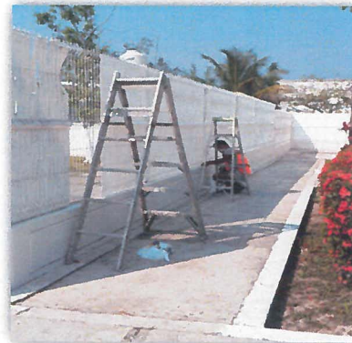
Suministro y colocacion de cinta de privacidad en malla de rejá acero
