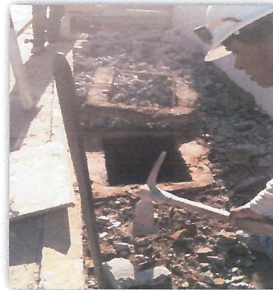
Demolición de guarnición y banqueta
