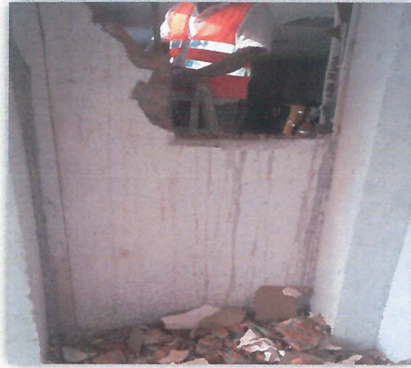
Demolicion de muro de celosia
