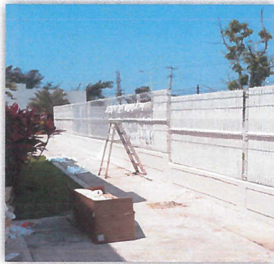
se continua con la colocación de cinta de privacidad en reja acero
