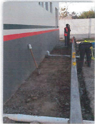
Construcción de baquetas
