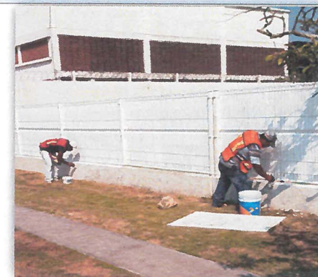
aplicación de pintura en muros exteriores
