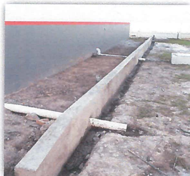
Construccion de guarniciones
