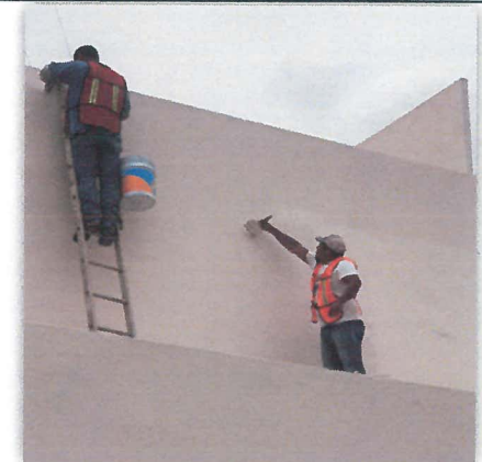
Aplicación de pintura vinil-acrílica
