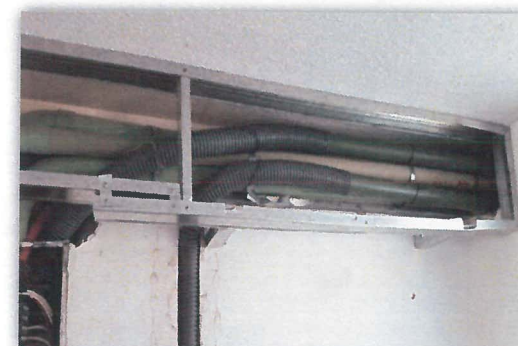
Readecuacion de salida de climas
