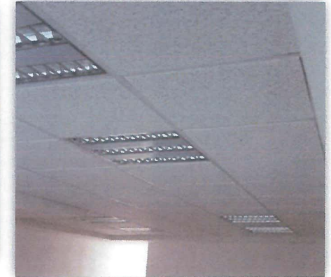
colocacion de luminarias
