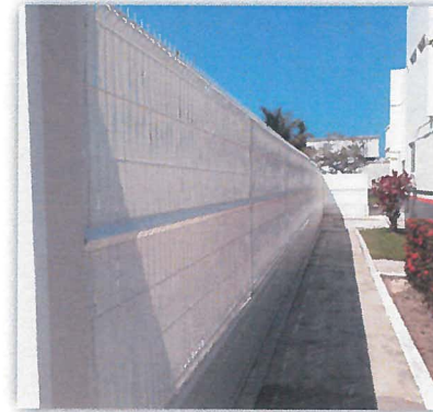
Suministro y colocacion de cinta de privacidad en malla de rejá acero
