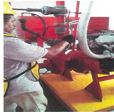
MANTENIMIENTO PREVENTIVO-CORRECTIVO DE CUARTO DE BOMBAS DEL SISTEMA CONTRA INCENDIOS
