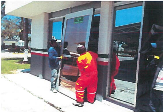
"Retiro de puerta principal de acceso con medida 1.08 m de ancho x 3 mts de altura por una hojas y 2 hojas fijas de 0.80m de ancho x 3.00 mts de altura
