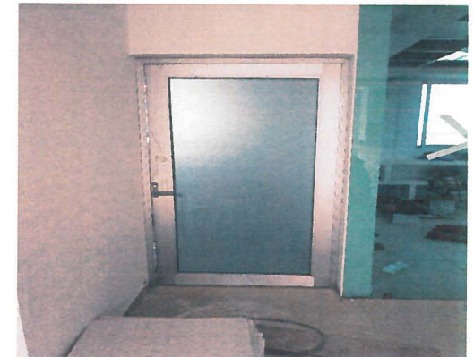
puerta de aluminio anodizado natural pulido y cristal tintex verde de 6mm. de 0.90 A 1.10 x 2.10 m con película de vinil esmerilado de ancho
