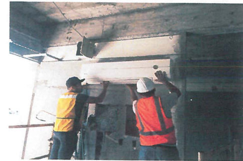
Reubicación, servicio e instalación de equipo de aire acondicionado tipo minisplit de 1 a 3 ton a 220 v.
