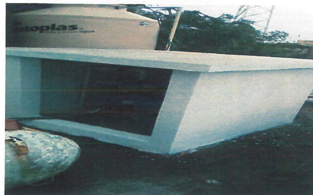
construccion nicho de 1m x 1m x 1m
