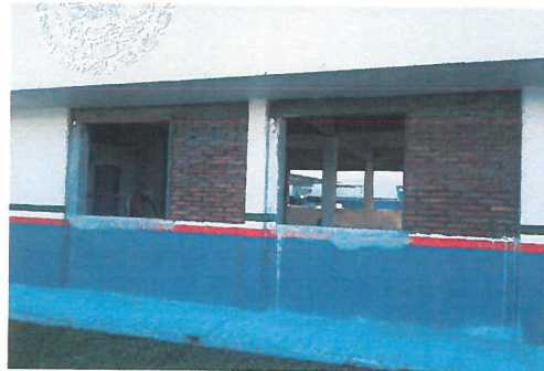
Muro de tabique rojo recocido de 7x14x28 de 1a. De 14cms de espesor.
