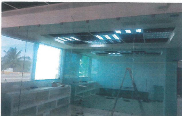
muro de cristal templado color tintex verde de 9mm de espesor con dimensiones 2.00 A 2.10 m de ancho x 2.60 m de altura
