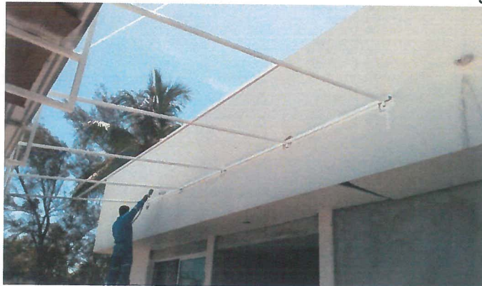
Galera a base de lámina de policarbonato cristal macrolux de 6mm con medidas de 3.20 de ancho x 6ms
