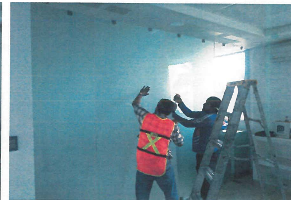
muro de cristal templado color tintex verde de 9mm de espesor con dimensiones 2.00 A 2.10 m de ancho x 2.60 m de altura
