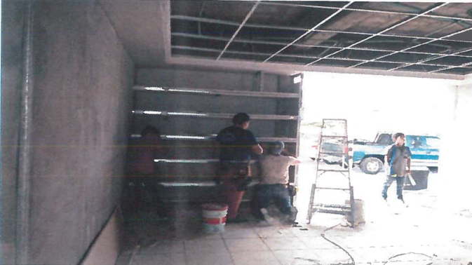
Módulo de archivero a base de panel yeso de tabla roca con dimensiones de 2.30 a 2.60 m ancho y 2.60 m de alto
