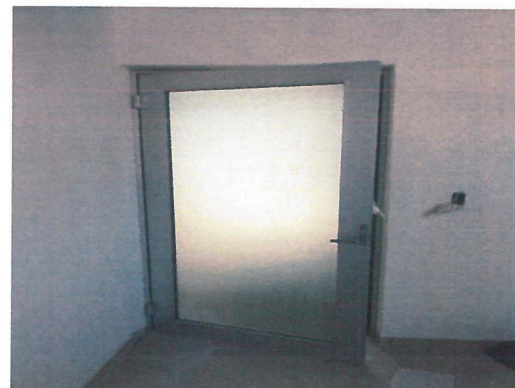
puerta de aluminio anodizado natural pulido y cristal tintex verde de 6mm. de 0.90 A 1.10 x 2.10 m con película de vinil esmerilado de ancho
