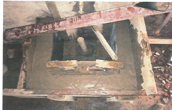
Sardinel a base de concreto f c=150 kg/cm2 con medidas de 0.70 x 0.50 mts. de lados x 0.30 mts. de alto
