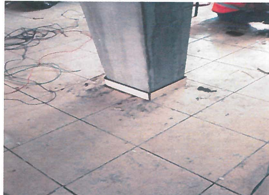
colocación de zoclo de loseta cerámica interceramic crema marfil natural de 10 x 40 cm,
