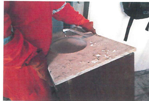
Desmontaje de placas de mármol en muebles de baños de lavabos
