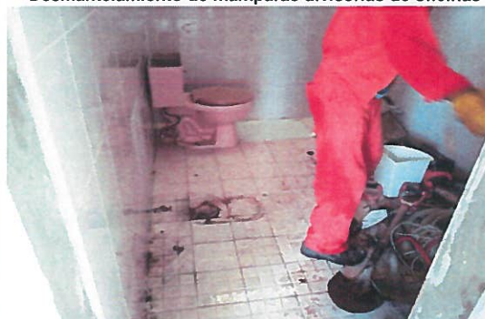
Desmantelamiento de muebles sanitarios, el retiro de 4 W.C, 3 lavabos, 1 mingitorio y accesorios de baños,
