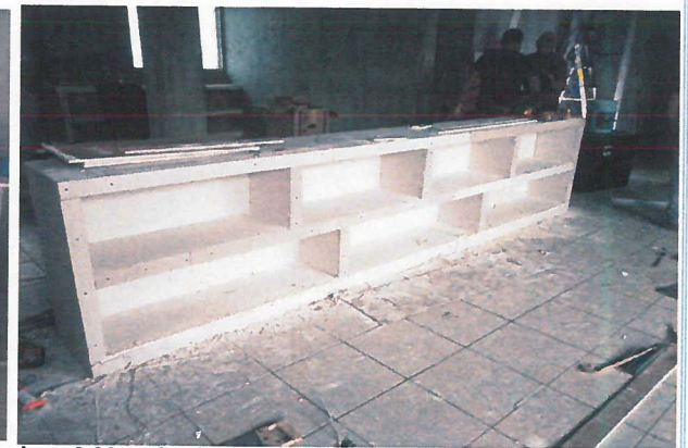
Módulo de archivero a base de panel yeso de tabla roca con dimensiones de 4.10 m ancho y 0.90 m de alto
