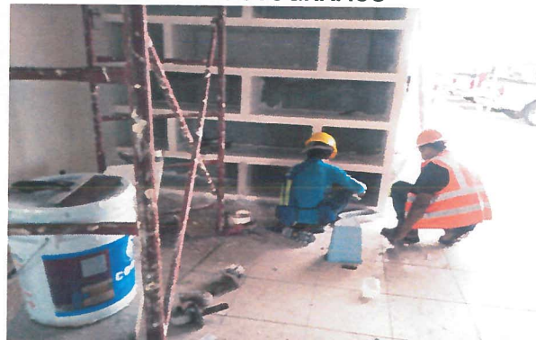
Módulo de archivero a base de panel yeso de tabla roca con dimensiones de 2.30 a 2.60 m ancho y 2.60 m de alto
