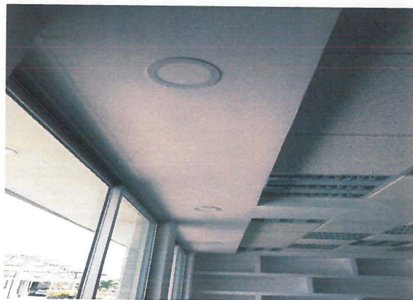
colocacion de luminarias de ledpanel
