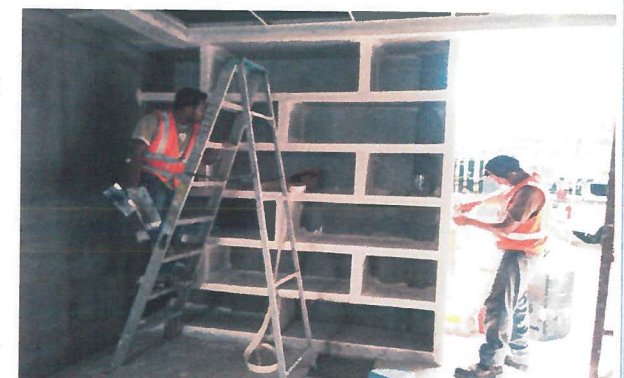
Módulo de archivero a base de panel yeso de tabla roca con dimensiones de 2.30 a 2.60 m ancho y 2.60 m de alto
