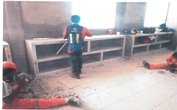
Módulo de archivero a base de panel yeso de tabla roca con dimensiones de 3.00 m ancho y 0.90 m de alto
