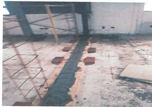
Dala de desplante de 15x20cm de sección, acabado común f_c=200\text{kg/cm}^2 , armado con armex 15x20-4
