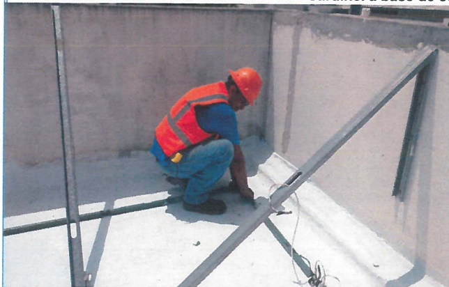
Sardinel a base de concreto f c=150 kg/cm2 con medidas de 0.70 x 0.50 mts. de lados x 0.30 mts. de alto
