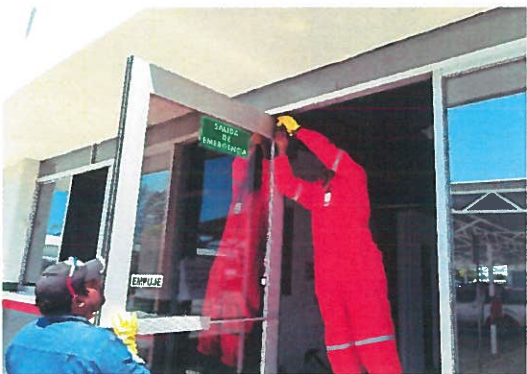
"Retiro de puerta principal de acceso con medida 1.08 m de ancho x 3 mts de altura por una hojas y 2 hojas fijas de 0.80m de ancho x 3.00 mts de altura
