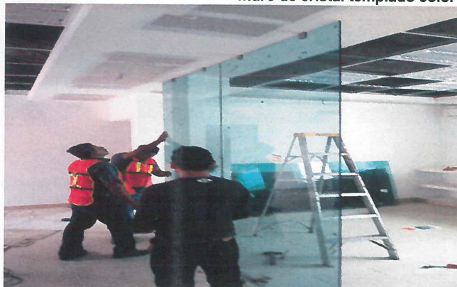
muro de cristal templado color tintex verde de 9mm de espesor con dimensiones 3.34 m de ancho x 2.60 m de altura
