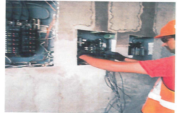
Suministro y colocación de interruptor termomagnético de un polo de 30 AMP marca SQUARE D
