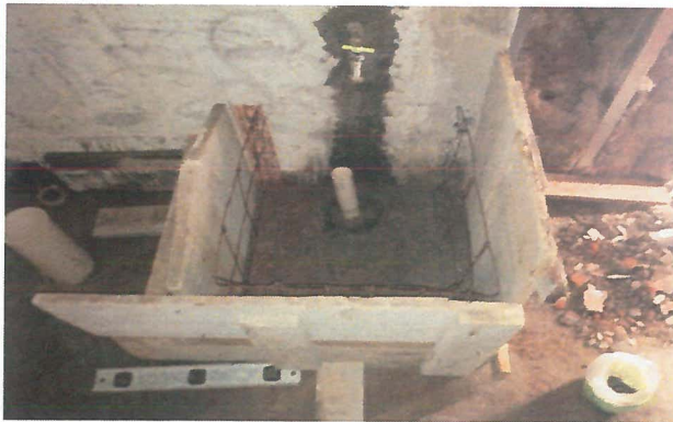
Sardinel a base de concreto f c=150 kg/cm2 con medidas de 0.70 x 0.50 mts. de lados x 0.30 mts. de alto
