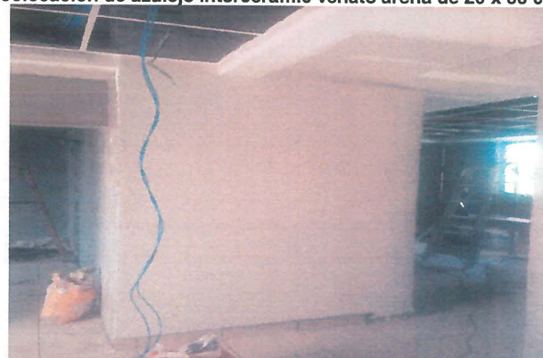
Recubrimiento con pasta grano medio en muros
