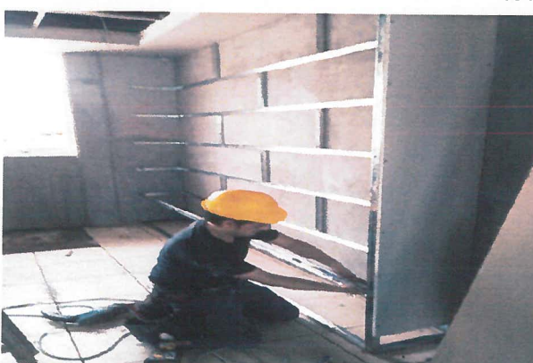
Módulo de archivero a base de panel yeso de tabla roca con dimensiones de 3.20 m ancho y 2.60 m de alto
