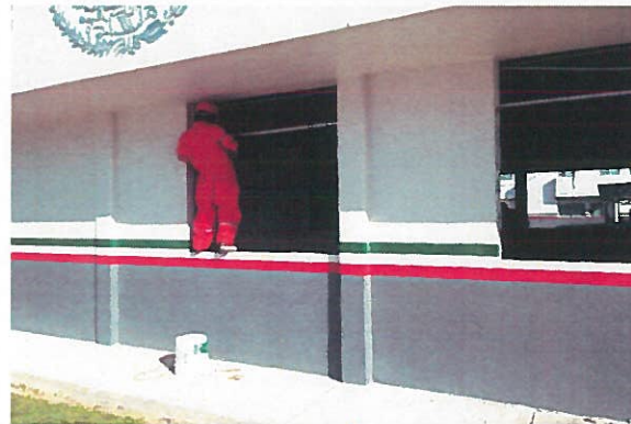
Retiro de ventana cuadrada 1.73 mts de ancho x 1.90 mts de alto
