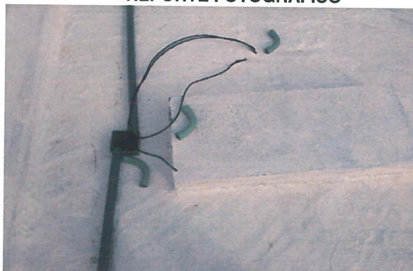
Salida eléctrica para unidad condensadora circuito C/A6
