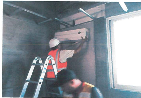
Reubicación, servicio e instalación de equipo de aire acondicionado tipo minisplit de 1 a 3 ton a 220 v.
