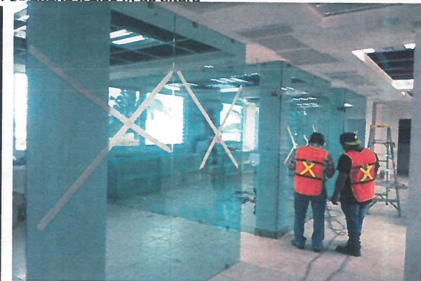
muro de cristal templado color tintex verde de 9mm de espesor con dimensiones 3.34 m de ancho x 2.60 m de altura
