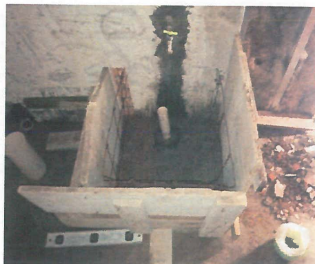
Salida hidráulica para llave de nariz y salidad hidraulica para tarja
