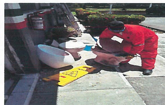
Desmantelamiento de muebles sanitarios, el retiro de 4 W.C, 3 lavabos, 1 mingitorio y accesorios de baños,
