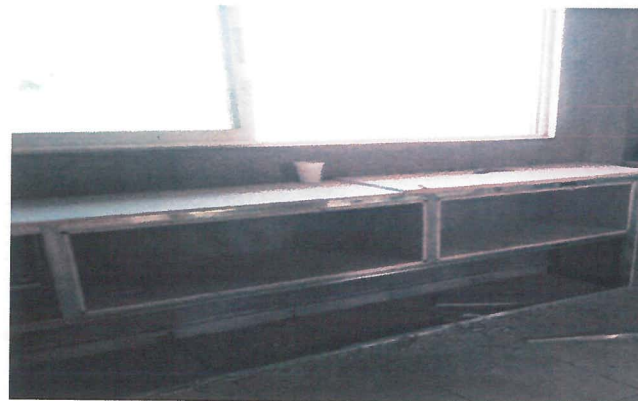
Módulo de archivero a base de panel yeso de tabla roca con dimensiones de 4.10 m ancho y 0.90 m de alto
