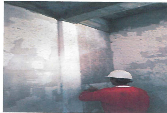
Desmantelamiento de azulejo en baños por medios manuales.
