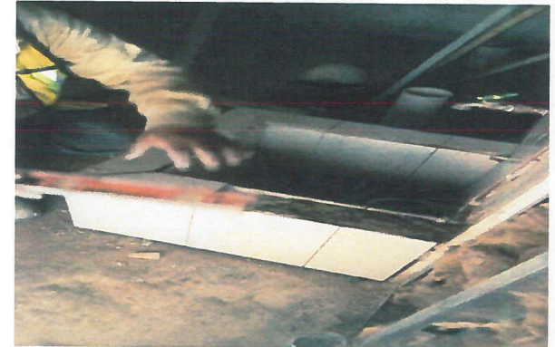
Sardinel a base de concreto f c=150 kg/cm2 con medidas de 0.70 x 0.50 mts. de lados x 0.30 mts. de alto
