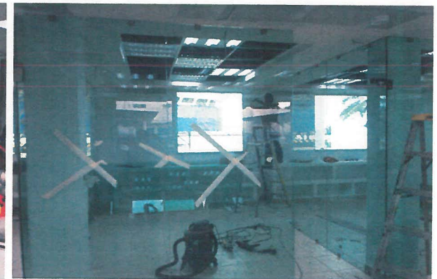
colocación de muro de cristal templado color tintex verde de 9mm de espesor con dimensiones 4.05 m de ancho x 2.60 m de altura
