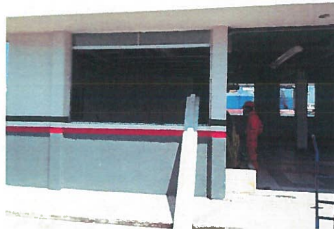
Retiro de ventana cuadrada 2.73 mts de ancho x 1.90 mts de alto
