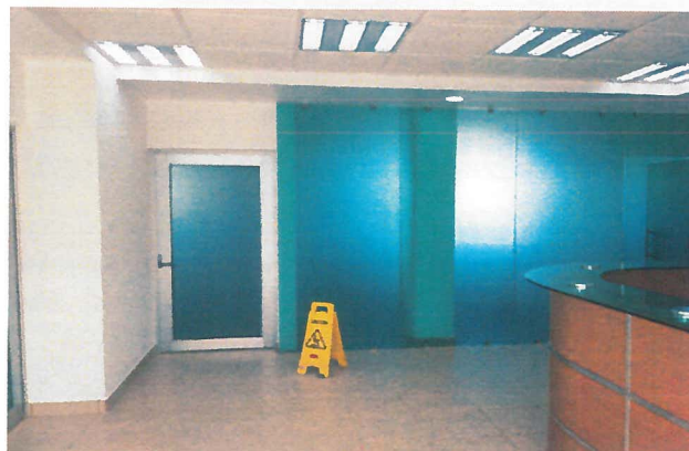
película esmerilada en muro de cristal
