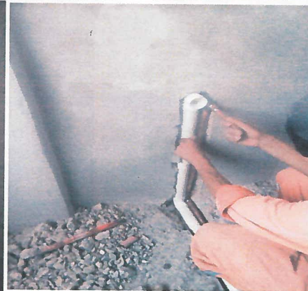
colocacion de sanitarios w.c., mignitorio y salidas hidraulicas.
