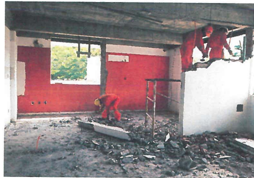
Demolición de muros de tabique rojo recocido de 14 cm de espesor.
