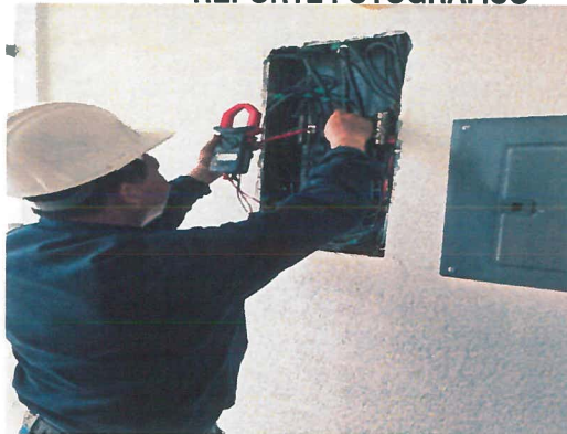
balanceo de cargas en tableros de distribucion
