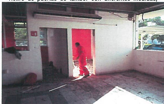
Desmantelamiento de puertas de aluminio (dimensiones de 0.90 x altura promedio 2.10m.)
