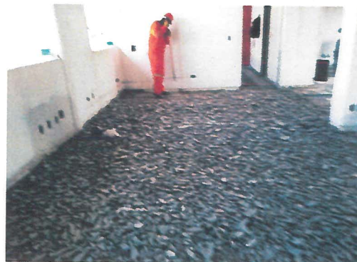
Retiro de piso de loseta
