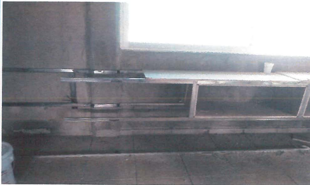
Módulo de archivero a base de panel yeso de tabla roca con dimensiones de 3.00 m ancho y 0.90 m de alto
