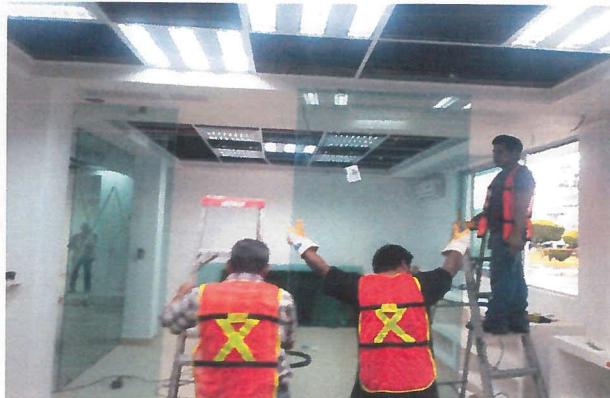
colocación de muro de cristal templado color tintex verde de 9mm de espesor con dimensiones 4.05 m de ancho x 2.60 m de altura
