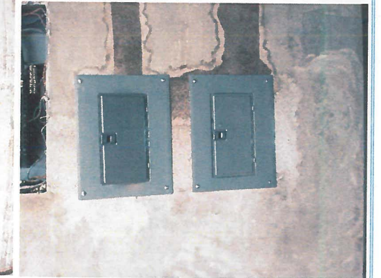
Suministro y colocación de tablero de distribución marca square D QO320L125G o similar 3 faces de 12 circuitos con tapa tipo empotrar
