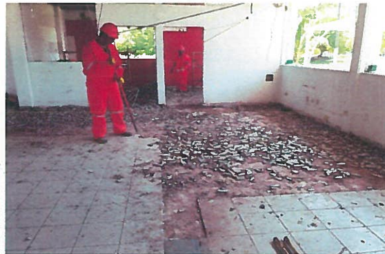
Retiro de piso de loseta por medios manuales
