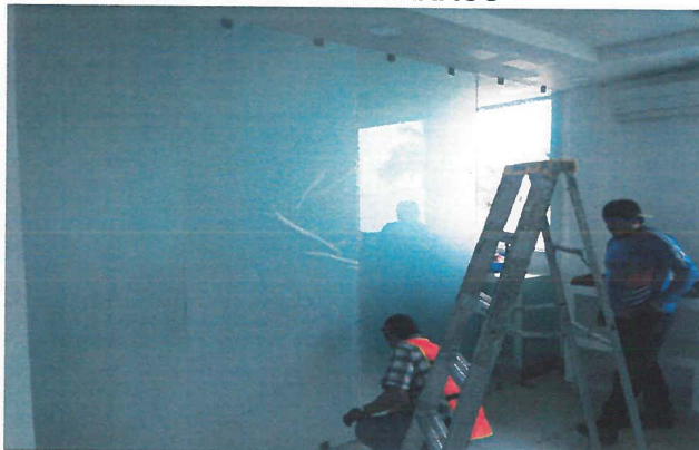
muro de cristal templado color tintex verde de 9mm de espesor con dimensiones 2.00 A 2.10 m de ancho x 2.60 m de altura
