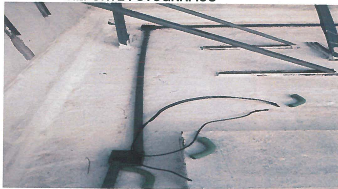
Salida eléctrica para unidad condensadora circuito C/A8
