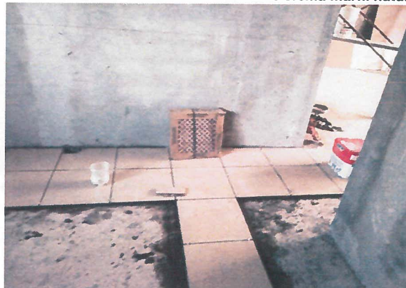
colocación de piso de loseta crema marfil natural de 40 x 40 cm
