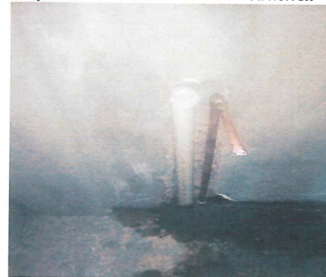
Salida hidráulica para llave de nariz y salidad hidraulica para tarja
