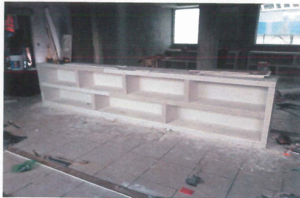
Módulo de archivero a base de panel yeso de tabla roca con dimensiones de 4.10 m ancho y 0.90 m de alto
