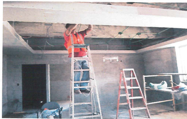
salidad para luminarias y colocacion de luminarias
