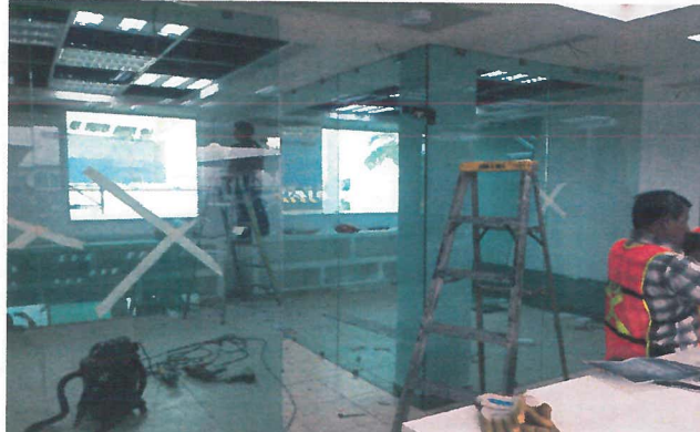
colocación de muro de cristal templado color tintex verde de 9mm de espesor con dimensiones 4.05 m de ancho x 2.60 m de altura
