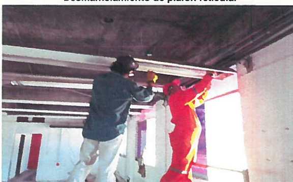
Retiro de luminarias existentes,
