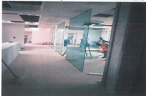
muro de cristal templado color tintex verde de 9mm de espesor con dimensiones 3.34 m de ancho x 2.60 m de altura
