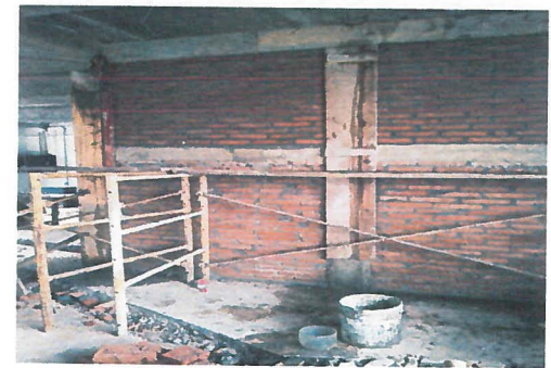
Castillo tipo k-2 ó DL-1 de 15x20cm de sección, acabado común, concreto f_c=200\text{kg/cm}^2 , armado con armex 15x20-4.
