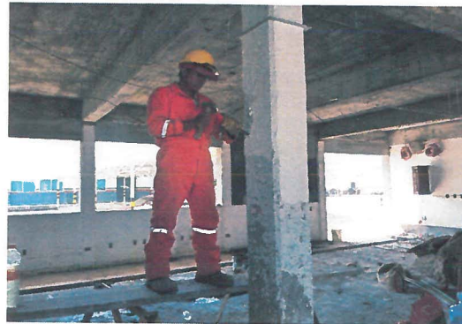
Retiro de acabado texturizado en muros, columnas,
