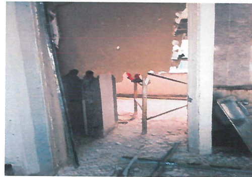
Demolición de muros de tabique rojo recocido de 14 cm de espesor.
