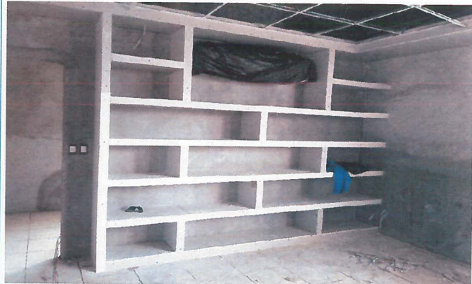
Módulo de archivero a base de panel yeso de tabla roca con dimensiones de 3.20 m ancho y 2.60 m de alto
