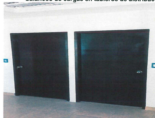
colocacion de puertas de madera
