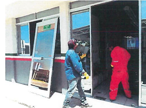
"Retiro de puerta principal de acceso con medida 1.08 m de ancho x 3 mts de altura por una hojas y 2 hojas fijas de 0.80m de ancho x 3.00 mts de altura
