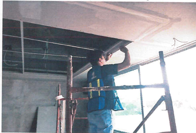
Cajillo tabla roca (platabanda) para plafón con un ancho de 0.10 a 0.61 m.
