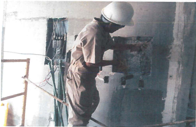
Suministro y colocación de tablero de distribución marca square D QO320L125G o similar 3 faces de 12 circuitos con tapa tipo empotrar
