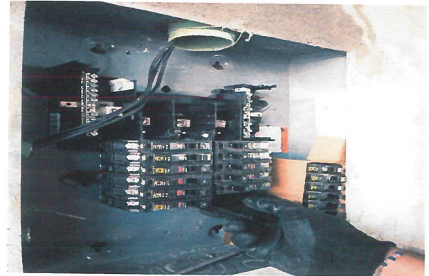
Suministro y colocación de interruptor termomagnético de un polo de 15 AMP marca SQUARE D
