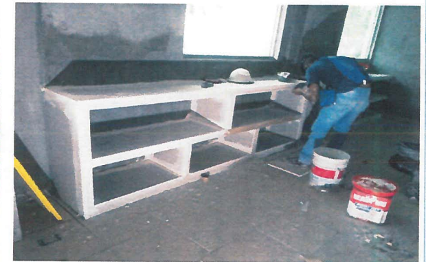
Módulo de archivero a base de panel yeso de tabla roca con dimensiones de 3.00 m ancho y 0.90 m de alto
