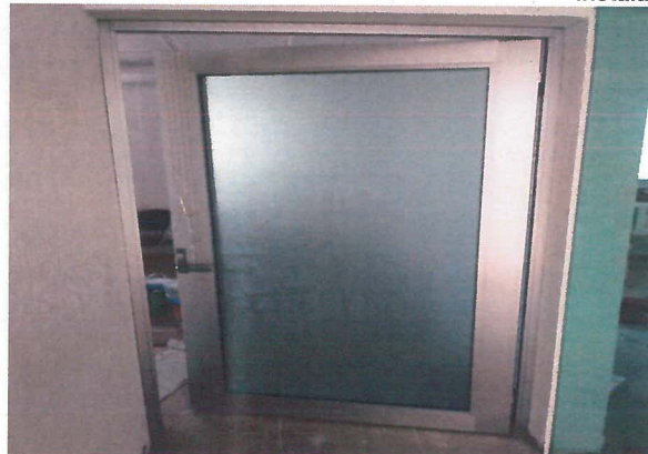
puerta de aluminio anodizado natural pulido y cristal tintex verde de 6mm. de 0.90 A 1.10 x 2.10 m con película de vinil esmerilado de ancho
