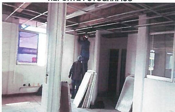
Desmantelamiento de plafon reticular
