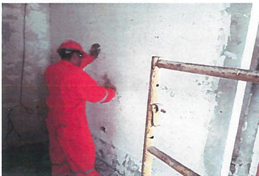
Retiro de acabado texturizado en muros, columnas,
