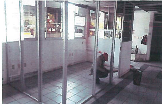
Retiro de piso de loseta por medios manuales
