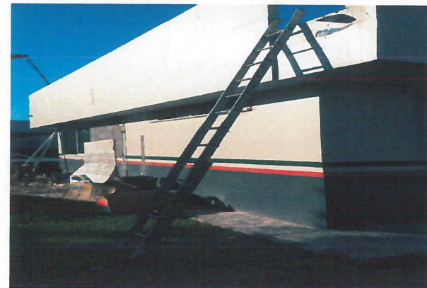
aplicación de pintura para placa tricolor
