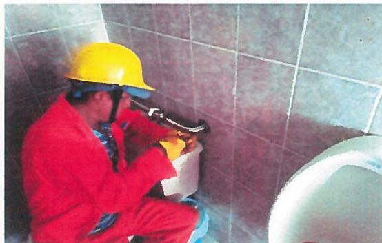
Desmantelamiento de muebles sanitarios, el retiro de 4 W.C, 3 lavabos, 1 mingitorio y accesorios de baños,
