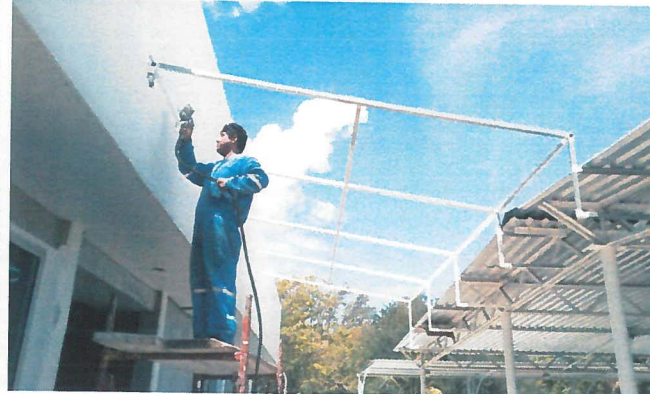
Galera a base de lámina de policarbonato cristal macrolux de 6mm con medidas de 3.20 de ancho x 6ms
