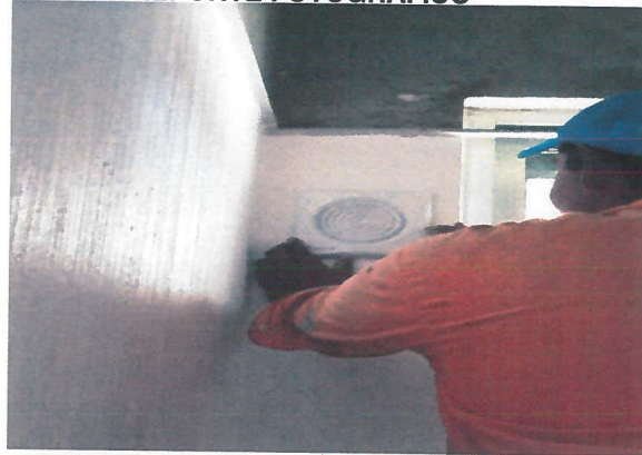
Suministro e instalacion de extractor de aire de 25 cm
