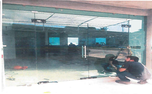
instalación de puerta de dos hojas con medidas de 0.90 x 2.1 y fijo de templado
