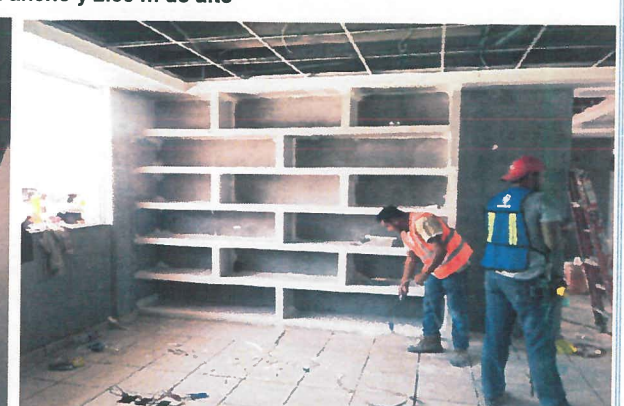
Módulo de archivero a base de panel yeso de tabla roca con dimensiones de 3.20 m ancho y 2.60 m de alto
