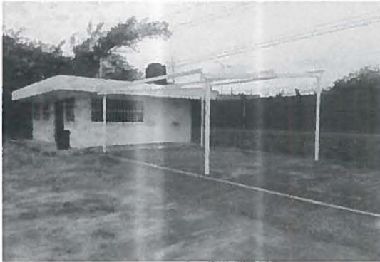
EN LAS IMÁGENES SE MUESTRAN LOS TRABAJOS DE COLOCACIÓN DE LÁMINA ESTRUCTURAL R-101 CALIBRE 26 DE 1.01M X 6.1M,
