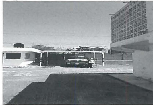
EN LAS IMÁGENES SE MUESTRAN LOS TRABAJOS DE COLOCACIÓN DE LÁMINA ESTRUCTURAL R-101 CALIBRE 26 DE 1.01M X 6.1M,
