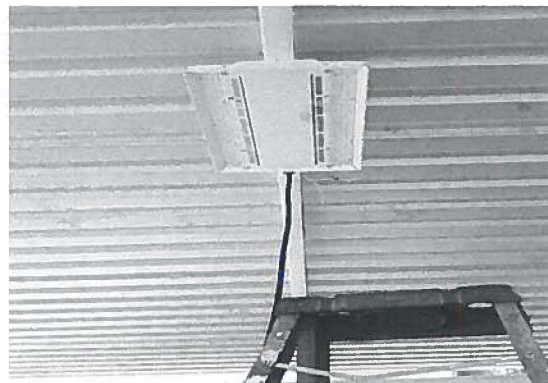
EN LAS IMÁGENES SE MUESTRAN LOS TRABAJOS DE COLOCACIÓN DE LUMINARIA LED ALTO MONTAJE, 95W, 12310 MODELO ABV101V571NV41ANW.
