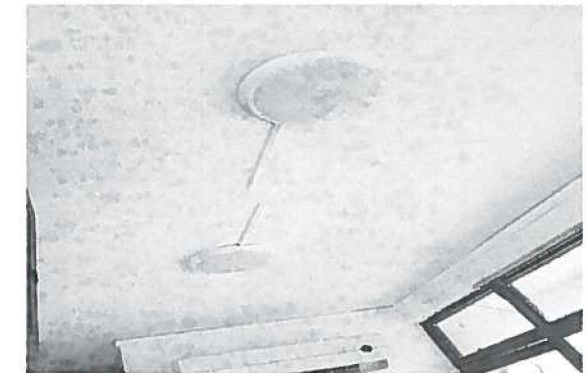
EN LAS IMÁGENES SE MUESTRAN LOS TRABAJOS DE COLOCACIÓN DE LUMINARIA PARA PLAFÓN DE SOBREPONER DE LED BLANCO, MARCA TECNO LIFE MODELO: FC-LEDRL/004/65, LUZ DE DÍA DE 16 W
