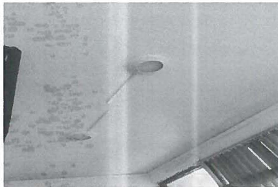
EN LAS IMÁGENES SE MUESTRAN LOS TRABAJOS DE COLOCACIÓN DE LUMINARIA PARA PLAFÓN DE SOBREPONER DE LED BLANCO, MARCA TECNO LIFE MODELO: FC-LEDRL/004/65, LUZ DE DÍA DE 16 W
