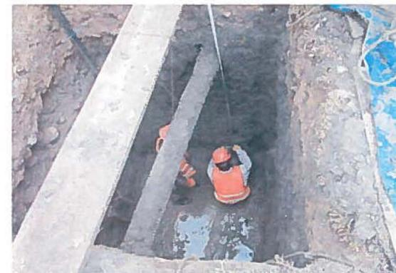
En las imágenes se muestran los trabajos de excavación a cielo abierto, por medios manuales para alojar carcamo de bombeo en area de operaciones.
