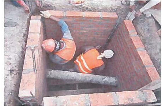
se muestran imágenes de los trabajos de fabricación de cárcamo de bombeo con dimensiones de 1.63 x 1.63 mts. y una altura de 3.30 mts.
