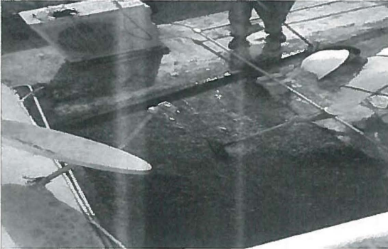
COLOCACION DE HIRDOPRIMER EN AREA OIC.
