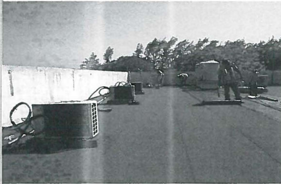
IMPERMEABILIZACION DE AREA DE ADMINISTRACION
