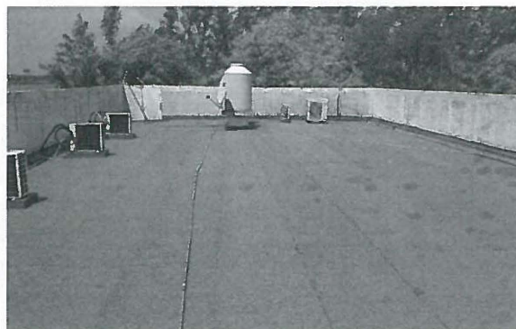
CONCLUSION DE IMPERMEABILIZACION DE AREA DE ADM
