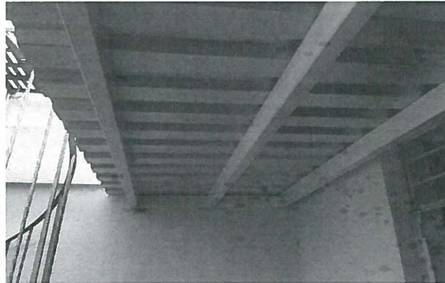
COLOCACION DE GALERA A BASE DE LAMINA ESTRUCTURAL R-101.
