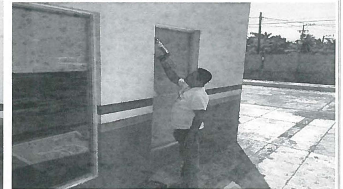
COLOCACION DE SELLADOR EN VENTANAS
