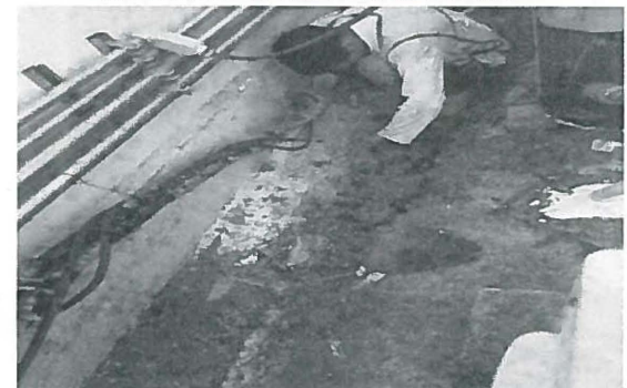
PREPRACION DE LA SUPERFICIE EN CHALAN (FINANZAS)
