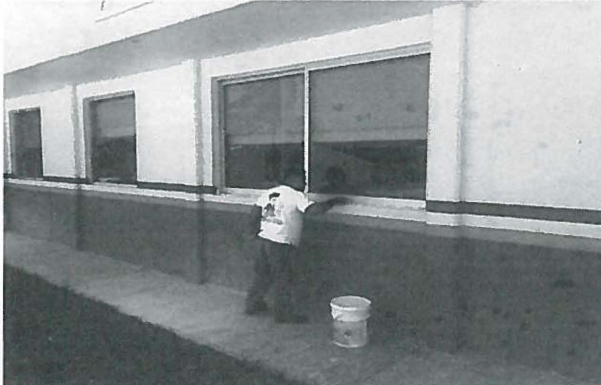
COLOCACION DE CELLADOR EN VENTANA
