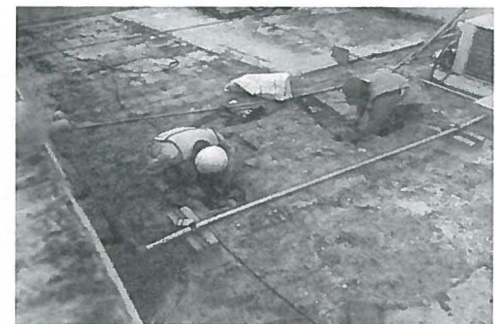
PREPRACION DE LA SUPERFICIE DE OIC.
