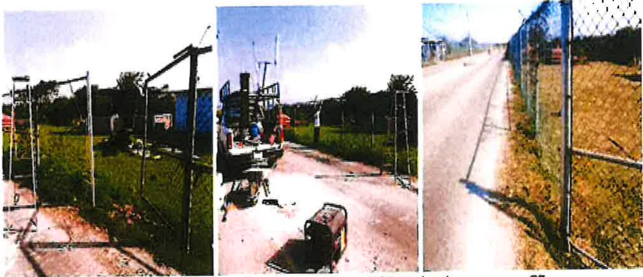
Proceso de reparación de la Malla y del Portón de acceso a C3
